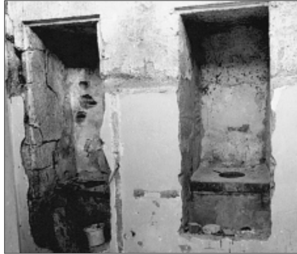
Fig. 23. LATRINES dans la cour de l'hôtel de la rue des Lazaristes à Figeac (XIV e siècle) Cliché A.-L. Napoléone.
