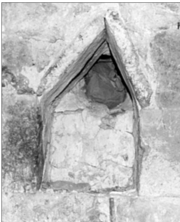
Fig. 29. NICHE DE LUMINAIRE, maison de la rue de la Citadelle à Tournon-d'Agenais (XIII e siècle). Cliché A.-L. Napoléone.
