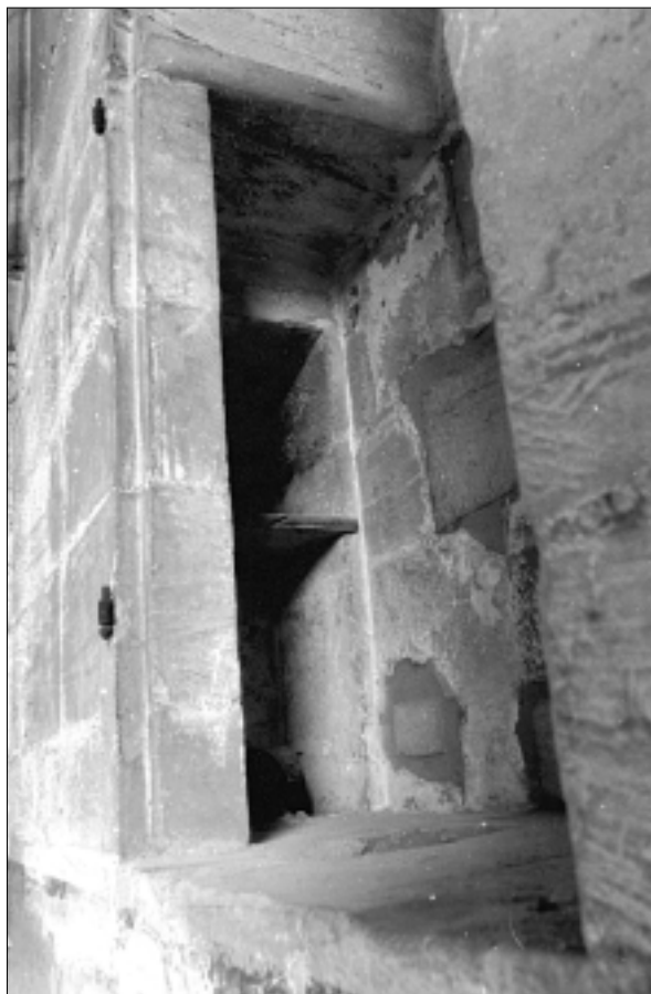
Fig. 30. PLACARD AVEC CACHE LATÉRALE au premier étage de la tour du Viguier à Figeac (XIV e siècle). Cliché A.-L. Napoléone.
