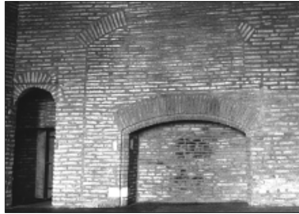
Fig. 7. CHEMINÉE INTÉGRÉE au premier étage de la tour Maurand à Toulouse (XIV e siècle). Cliché A.-L. Napoléone.
