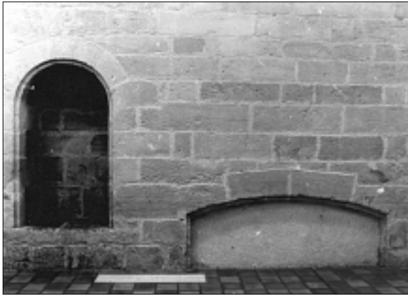
Fig. 6. CHEMINÉE INTÉGRÉE au rez-de-chaussée du Palais de Balène à Figeac (XIV e siècle). Cliché A.-L. Napoléone.
