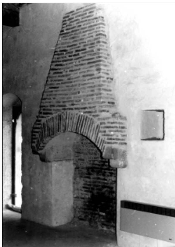
Fig. 8. CHEMINÉE NON DÉCORÉE de la maison Fontpeyrouse à Cordes (XIII e siècle). Cliché M. Scellès.
