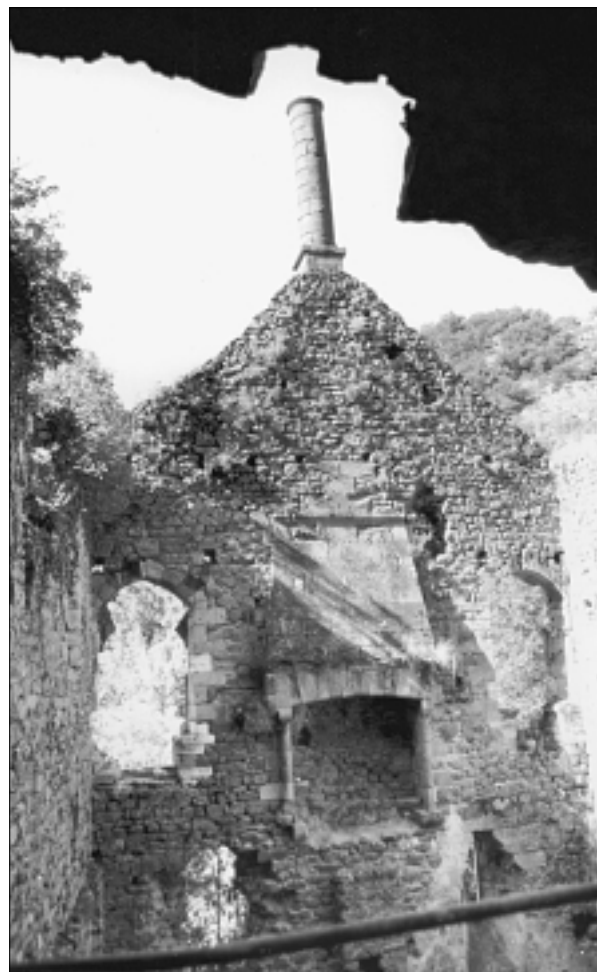
Fig. 18. CHEMINÉE ET SON CONDUIT à « l'Hôpital » de Peyrusse-le-Roc (XIII e siècle). Cliché A.-L. Napoléone.
