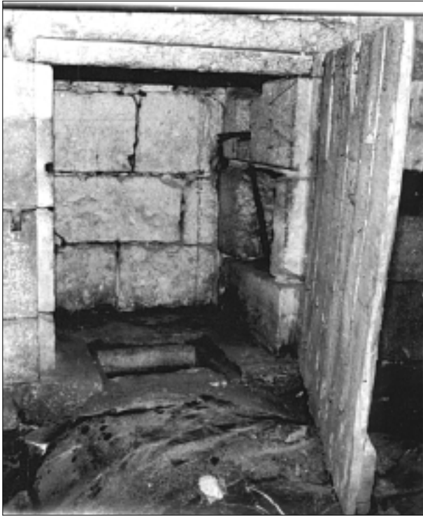
Fig. 31. PLACARD AVEC CACHE DANS LE FOND au rez-de-chaussée d'une maison de la rue Droite à Martel. Cliché A.-L. Napoléone.
