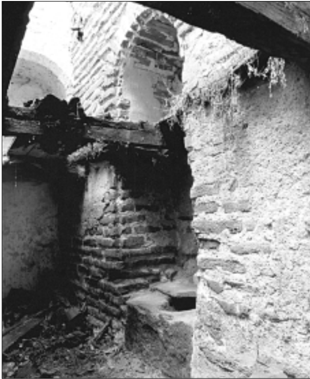
Fig. 22. LATRINES dans la cour de l'hôtel de la rue de la Daurade à Cahors (XIII e siècle). Cliché Inventaire Général, J.-F. Peiré.
