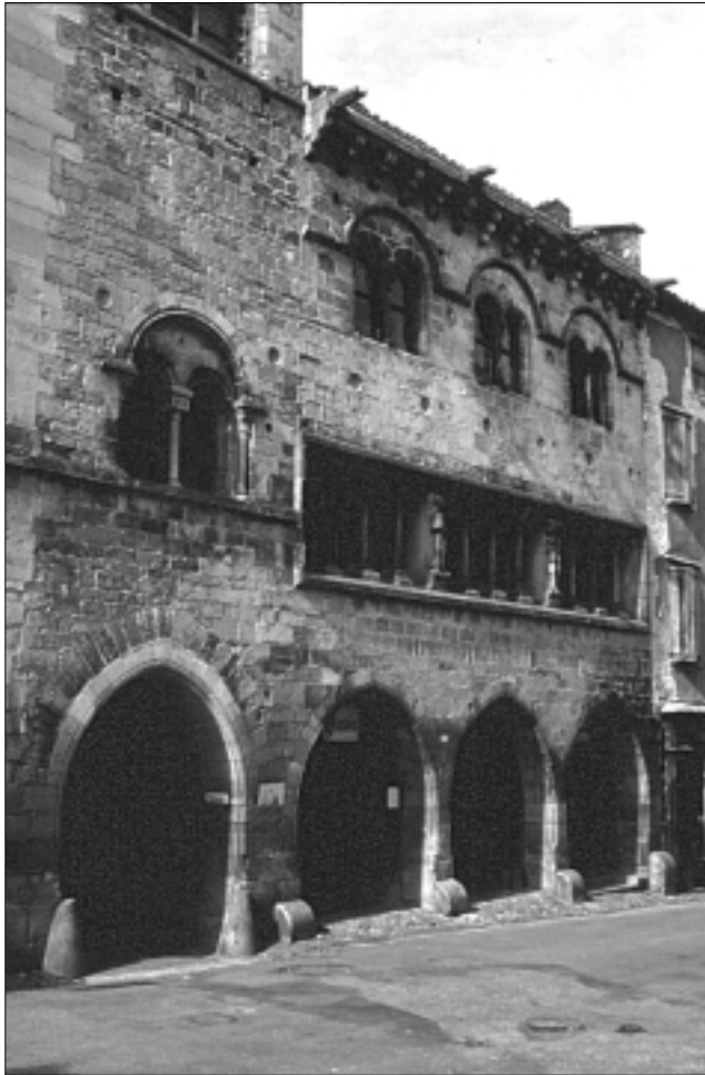
FIG. 21. SAINT-ANTONIN-NOBLE-VAL (TARN-ET-GARONNE) : HÔTEL PATRICIEN DU MILIEU DU XII e S., « à tour et salle » ; le rez-de-chaussée est ouvert d'arcades qui ont servi de boutiques. Cliché P. Garrigou Grandchamp.
