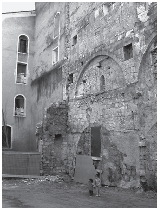
FIG. 4. BÉZIERS (HÉRAULT), MAISON DÉTRUITE DANS « L'ÎLOT DE MAÎTRE GERVAIS » : maçonnerie avec arcs superposés, XIII e -XIV e siècles. Cliché Fr. Mazeran.
