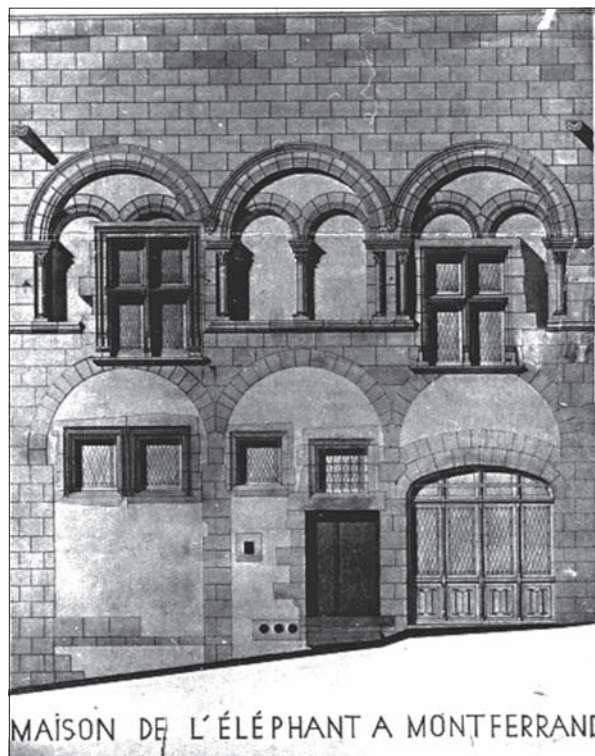
FIG. 1. CLERMONT-MONTFERRAND (PUY-DE-DÔME), MAISON DE L'ÉLÉPHANT, À MONTFERRAND: mur écran, vers 1200; façade sur rue avant travaux. Anonyme, s.d.; reproduction Inventaire Général , A.D.A.G.P., cliché Choplain-Maston.
