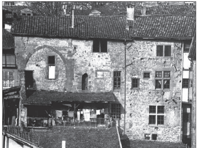
FIG. 9. SAINT-ANTOINE-EN-VIENNOIS (ISÈRE), MAISON : arcs en façade arrière, vestiges de structures à pans de bois en encorbellement, XIV e siècle. Photographie dans Boubert & Mocellin-Spicuzza 1999.
