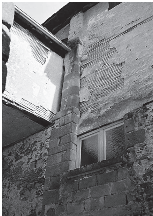
FIG. 26. DONZENAC (CORRÈZE), MAISON 6, RUE DES PÉNITENTS, XIV e siècle: piliers superposés sur trois niveaux, autrefois en arrière d'une façade en pans de bois. Cliché P. Garrigou Grandchamp.
