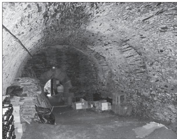
FIG. 18. DONZENAC (CORRÈZE), 13 rue Roger Ténèze, cave couverte d'une voûte en berceau avec pénétrations pour les soupiraux. Cliché A. Marin.
