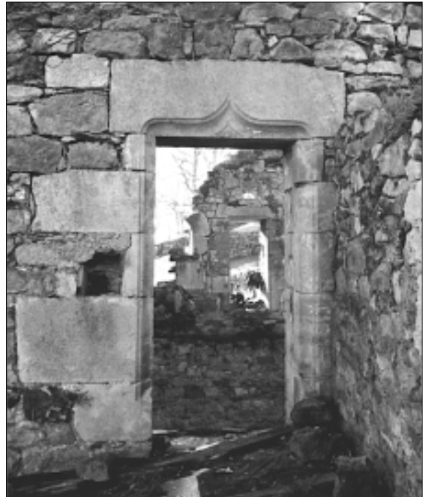
FIG. 9. MAISON DES XV e -XVI e SIÈCLES, FAÇADE EST. Détail sur la porte d'entrée. La niche de l'évier en pierre et la porte des latrines disposées sur l'élévation ouest apparaissent par l'ouverture. Cliché Valérie Rousset.
