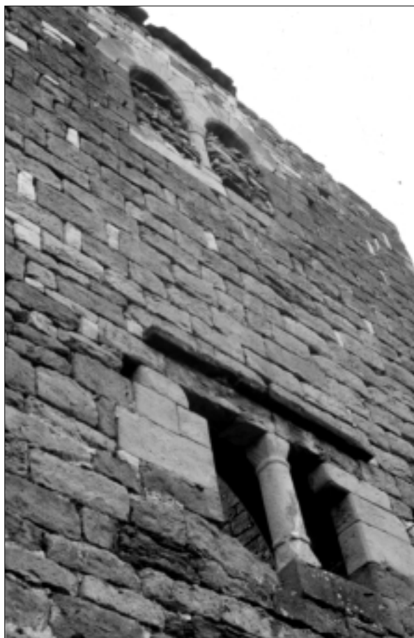
FIG. 4. MAISON DU XIII e SIÈCLE, FAÇADE SUD (DÉTAIL). Les chapiteaux sont ornés de feuilles d'eau sommairement sculptées. Cliché Valérie Rousset.
