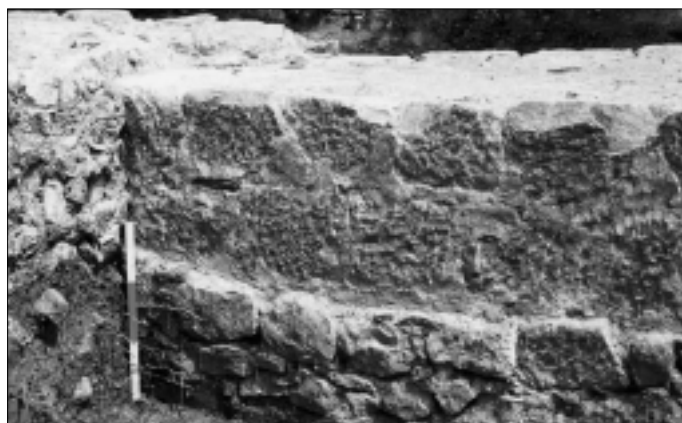
FIG. 11. DÉTAIL DE L'APPAREIL DU REMPART, fondation et élévation. Cliché Jean Catalo.
