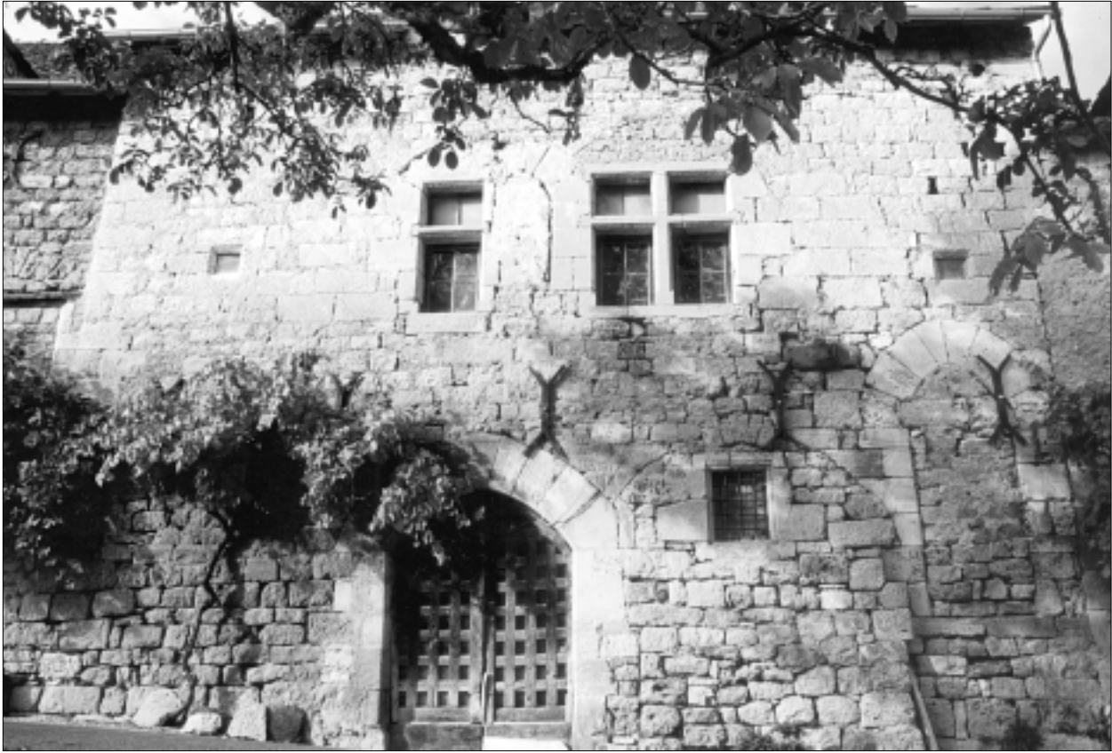
FIG. 25. MAISONS JUMELLES À SAINT-AUSTREMOINE, COMMUNE DE SALLES-LA-SOURCE (AVEYRON). Vue de la façade principale. Cliché V. Rousset, 2001.
