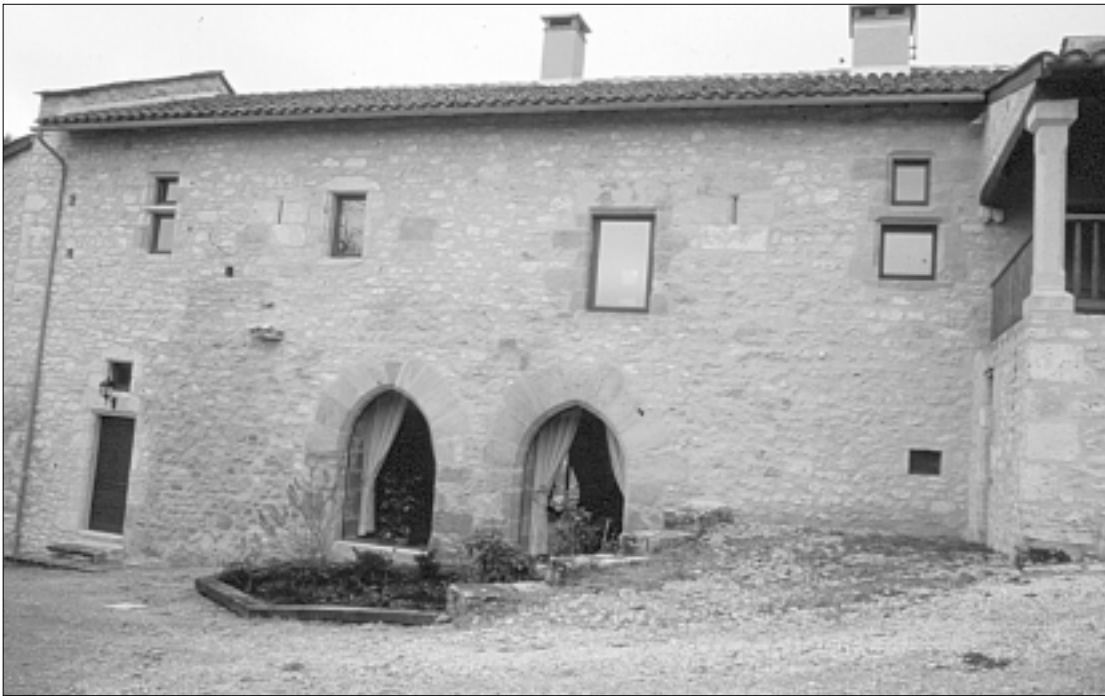
FIG. 20. MAISONS JUMELLES DE TOUREL, À SAINT-JEAN-LESPINASSE (LOT), XIV e siècle. Les arcades et les jours des niches d'évier sont répartis symétriquement sur la façade principale. Cliché V. Rousset, 2001.
