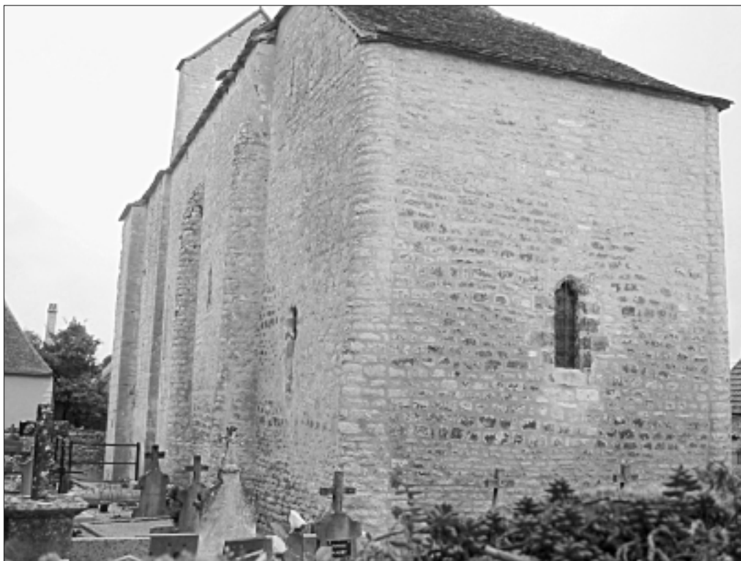
FIG. 2. L'ÉGLISE PRIEURALE SAINT-MARTIN À MAYRIGNAC-LE-FRANCAL vue depuis l'est. Cliché V. Rousset, 2001.
