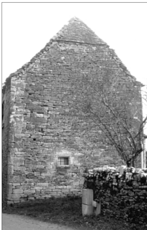
FIG. 10. MAISONS JUMELLES N° 1. Le pignon sud conserve au niveau de l'étage un jour d'éclairage du XIII e siècle (sur la gauche). Cliché V. Rousset, 2001.
