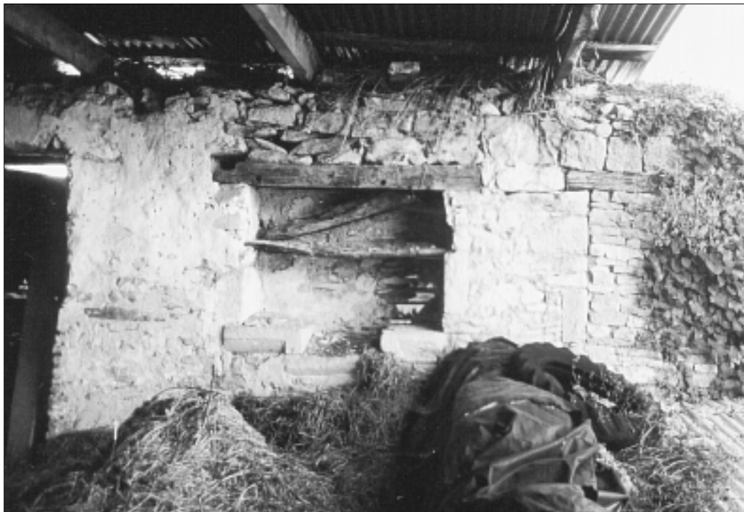
FIG. 18. MAISONS N° 4 À MAYRINHAC-LE-FRANCAL. Les vestiges de deux niches d'évier juxtaposées implantées dans le mur arrière évoquent le parti gémeilaire de cette construction médiévale. Cliché V. Rousset, 2001.
