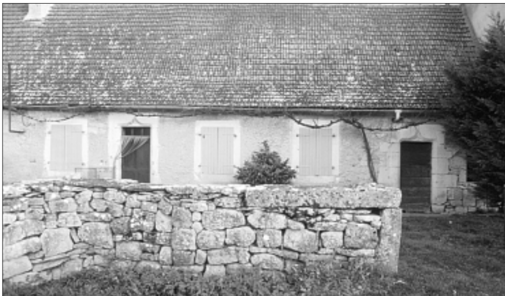
FIG. 22. MAISONS JUMELLES (A) AU CORNOUILLER, COMMUNE DE DURBANS (LOT), XV e -XVI e SIÈCLES. Cliché V. Rousset, 2001.
