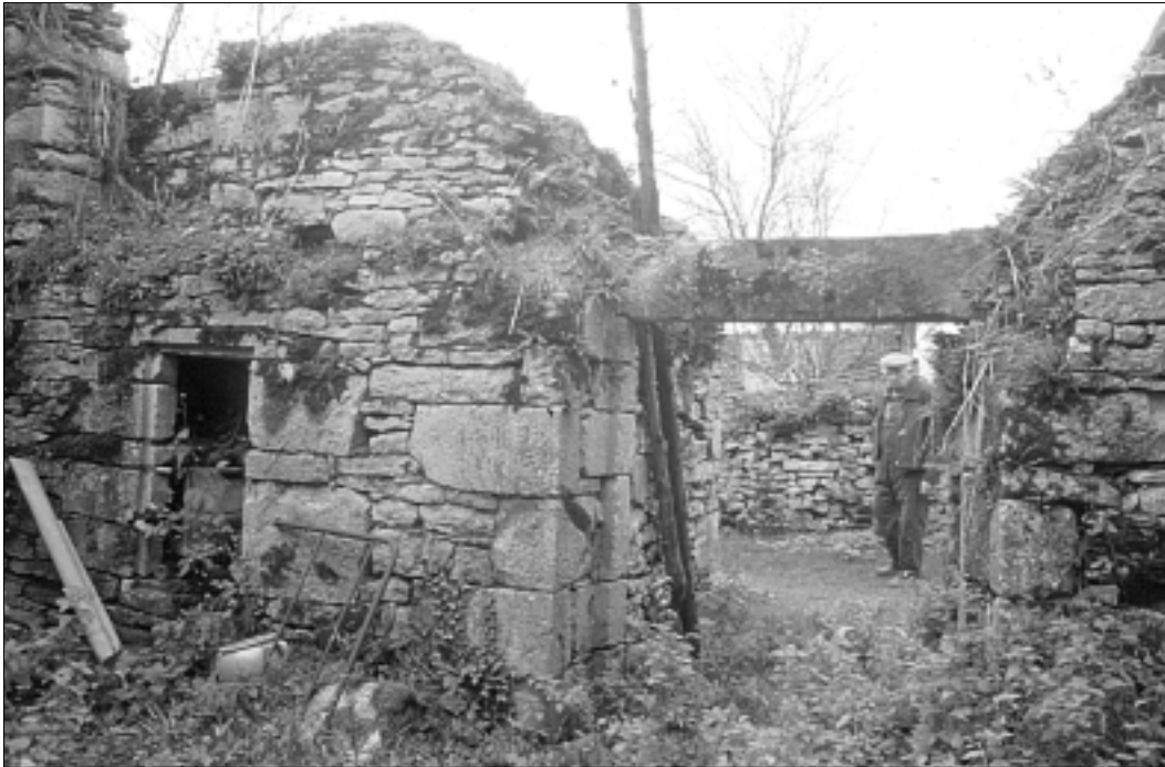
FIG. 17. MAISONS N° 2 À MAYRINHAC-LE-FRANCAL. Vue du revers de la façade nord (ruinée) doté d'une porte à encadrement à arêtes vives et trou barrier, ainsi que d'un placard à niches latérales. Cliché V. Rousset, 2001.
