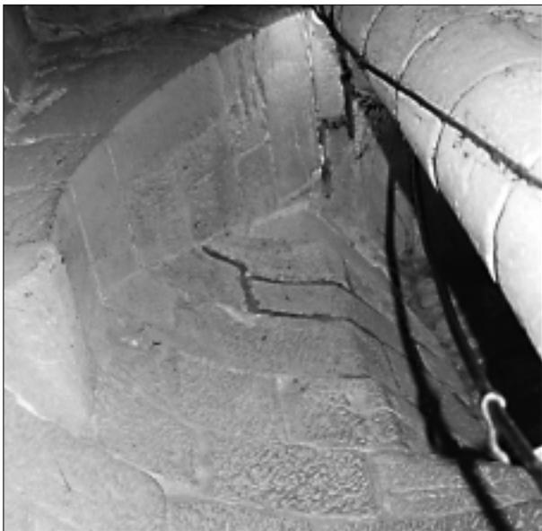
FIG. 6. ÉGLISE NOTRE-DAME DE L'ASSOMPTION DE FANJEAUX. Vue de l'arc de renfort de l'escalier en vis soutenant le passage à l'étage campanaire. Cliché Adeline Béa.
