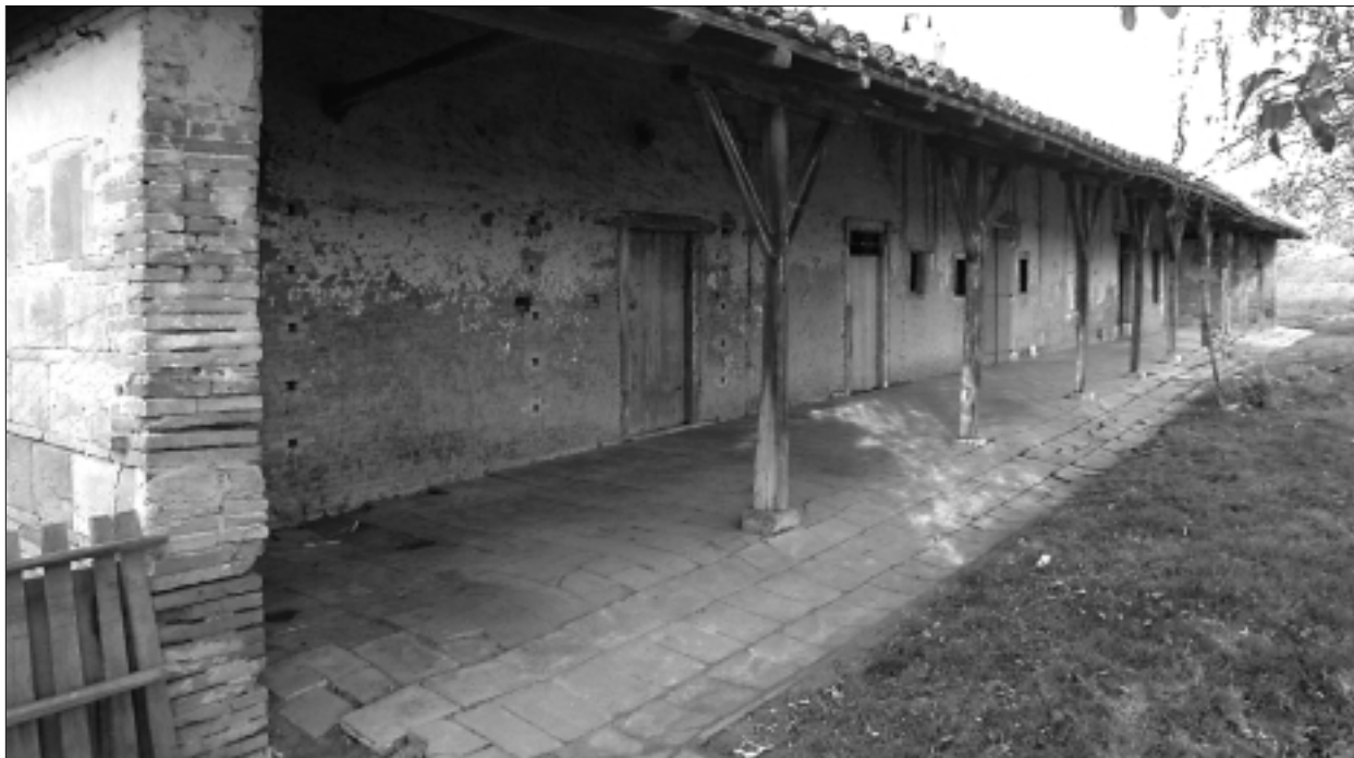
FIG. 17. COX. ATELIER LAFFONT, galerie sud. Vue prise du sud-ouest. Cliché H. Améglio.
