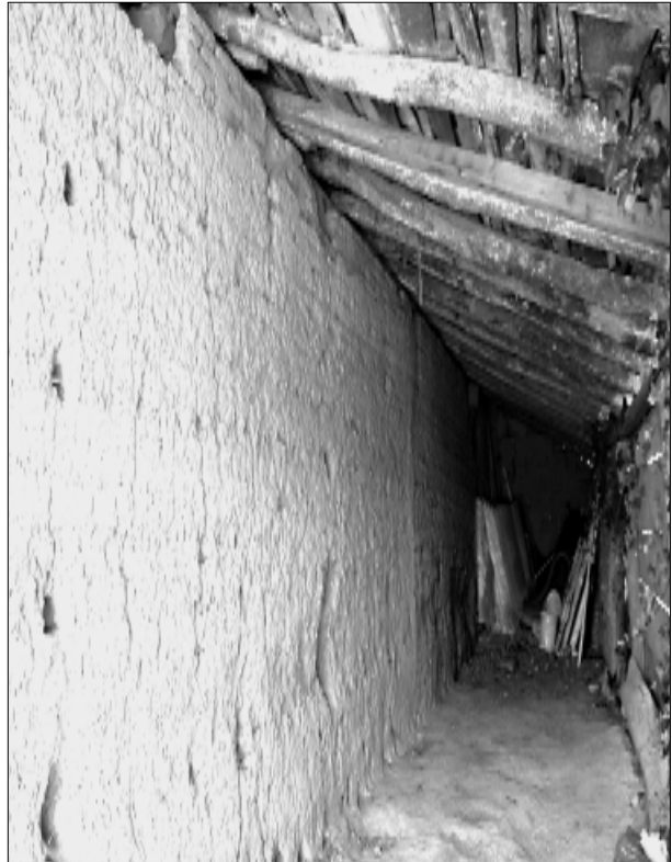
FIG. 28. COX. ATELIER LAFFONT, galerie nord, mur en terre banchée. Vue prise du nord-est. Cliché H. Améglio.
