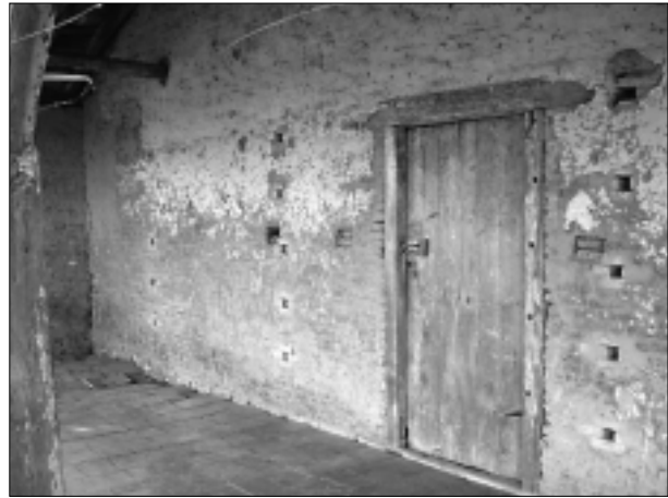
FIG. 23. COX. ATELIER LAFFONT, porte de la pièce du four et trous pour l'encastrement des supports des planches de séchage. Vue prise du sud-est. Cliché H. Améglio.
