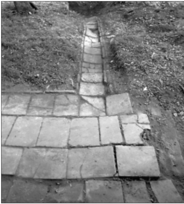
FIG. 22. COX. ATELIER LAFFONT, rigole conduisant l'eau du toit vers la mare (aujourd'hui comblée). Vue prise du nord. Cliché H. Améglio.
