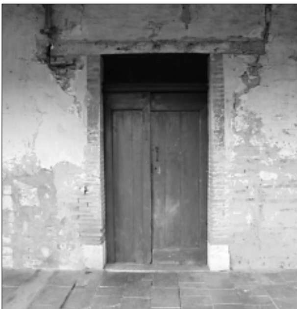
FIG. 7. COX. ATELIER LAFFONT, entrée de la partie habitation. Cliché H. Améglio.
