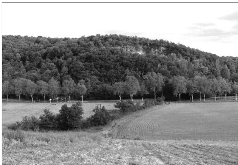
COLLINE DU BOIS DE LA HAGE depuis l'ouest, et front de taille de l'ancienne carrière Dufau d'où repartirait l'exploitation prévue.
