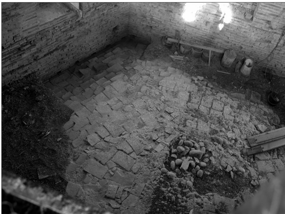
FIG. 13. COUVERTURE DE BRIQUES sur l'extrados de la voûte de l'abside.
