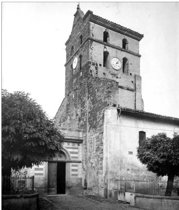
FIG. 24. CLICHÉ DU DÉBUT DU XX<sup>e</sup> SIÈCLE montrant l'état de l'édifice entièrement enduit et le porche néo-classique avant sa destruction.
