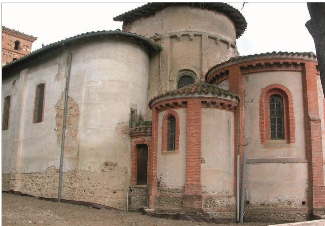
FIG. 13. PARTIE SUD DU CHEVET. Le vestige de décor en damier a été observé au droit de l'extrémité de la corniche à modillons romans juste au-dessus de la toiture de l'absidiole. *Cl. A. Bossoutrot.*
