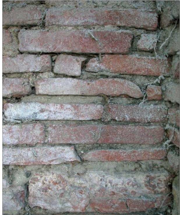
FIG. 15. DÉTAIL DU PAREMENT DU MUR NORD de l'église avec un fragment de tuile gallo-romaine et un élément de mortier romain en réemploi. Cl. A. Bossoutrot.
