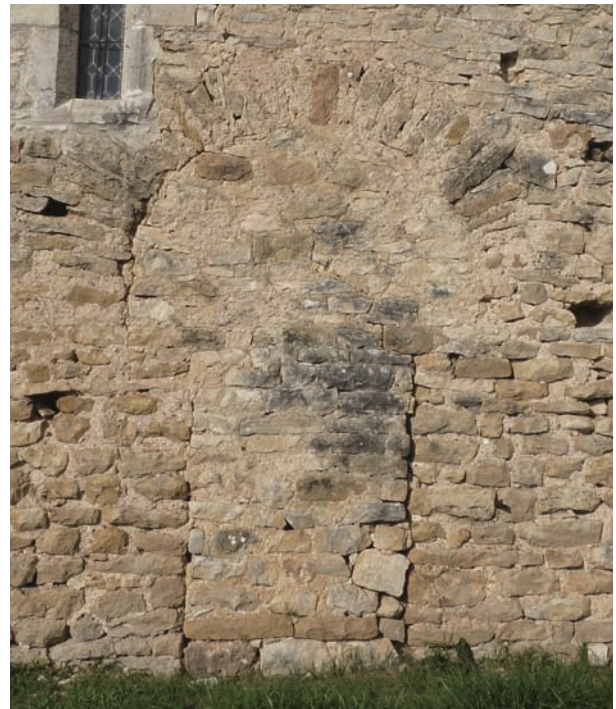
FIG. 6. ÉGLISE DE TOULONGERGUES, porte sud murée, avec son arc rayonnant « en gouttière ». Cliché R. Laurière.
