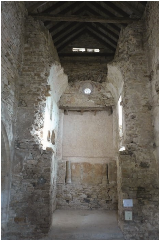
FIG. 5. ÉGLISE DE TOULONGERGUES, vue intérieure en direction du chœur. On remarque la grande élévation, les bases de l'arc triomphal et la voûte du chœur. Cliché R. Laurière.
