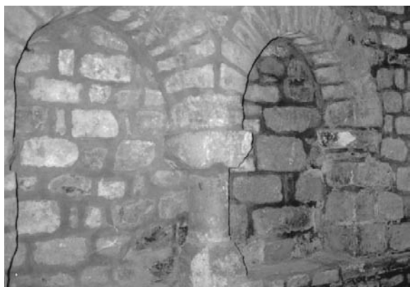
FIG. 9. ÉGLISE DE CAS, les arcatures du chœur. Cliché R. Laurière.
