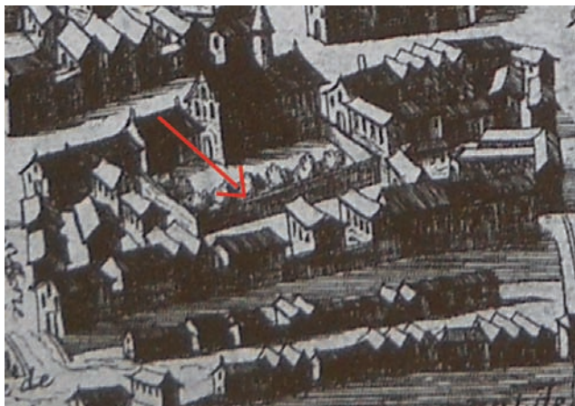
FIG. 4. VUE D'UNE SECTION DE LA MURAILLE DE GARONNE à l'arrière de l'hospice de la Magdelaine, détail du plan de 1663, eau-forte, THOLOSE, à Paris, chez Nicolas Bery. Musée Paul-Dupuy (50-6-1).
