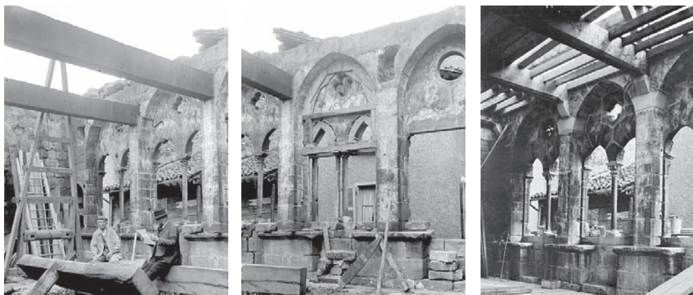
FIG. 7. « MAISON DE LA MONNAIE », intérieur de la salle sud en cours de travaux, avant et après la réfection du plafond. Clichés Chaine n° 36756, 36760 et 36773, Bibliothèque de l'architecture et du patrimoine.
