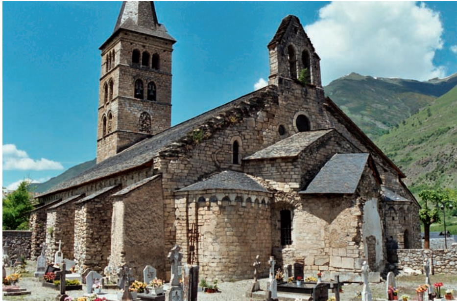
FIG. 4. ARTIES, ÉGLISE SANTA MARIA. Aspect en 2005, avant restauration. Cliché E. Garland.
