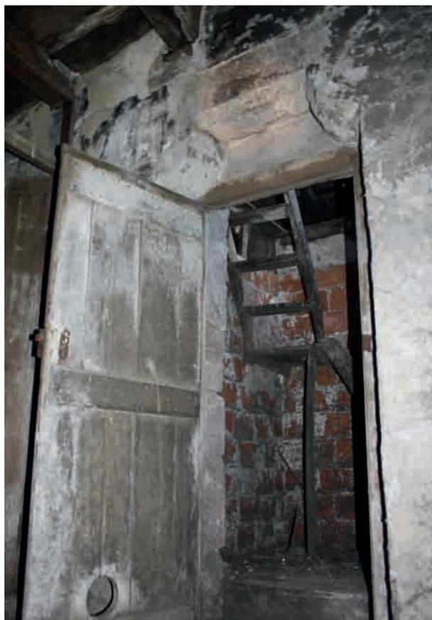
FIG. 38 : COMPLEXE DE « LA TOUR DU BOULANGER » : porte à linteau sur coussinets du corps de bâtiment avant ouvrant sur la cour.
