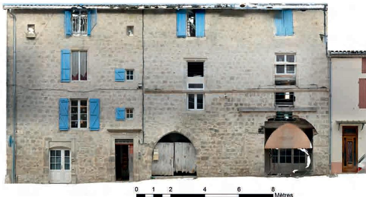
FIG. 55 : CASTELSAGRAT, maisons 1 et 3-5, rue Alphonse de Poitiers, façades sud : le cordon régissant sépare le très haut rez-de-chaussée de l'étage, lui-même haut dans oeuvre sous un plafond (cf. fig. 47). Deux arcades ouvraient au rez-de-chaussée du n° 3-5 et une (entre les deux portes) au n° 1. Les deux fenêtres géminées de l'étage du n° 3-5 ont été reprises au XV<sup>e</sup> siècle et récemment mutilées, lors de l'insertion de la dalle de béton qui recoupe l'étage. *Orthophoto. B. Lefebvre.*
