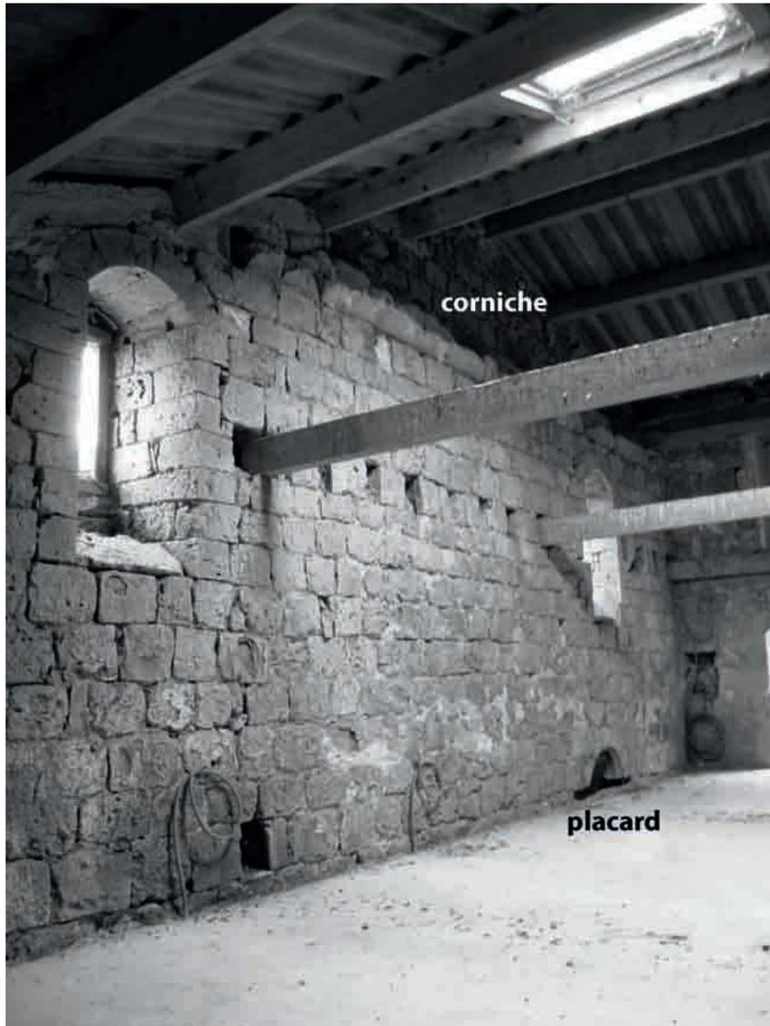
FIG. 47 : CASTELSAGRAT, maison 3-5, rue Alphonse de Poitiers, pièce est, recoupée par une dalle de béton : dans le pignon sud, à gauche, arc d'un placard mural, deux fenêtres hautes et corniche du plafond originel. Cl. Kl. Freckmann.
