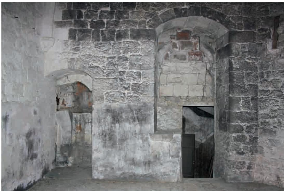
FIG. 35 : VUE DE LA PORTE ET DES VESTIGES DE LA FENÊTRE RECTANGULAIRE À REMPLAGES sur le mur est de la salle du premier étage de la tour. Cl. A-L. Napoléone.
