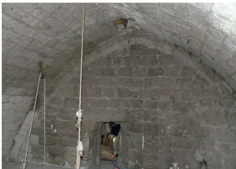
FIG. 31 : VUE DU BERCEAU BRISÉ DE LA SALLE DU REZ-DE-CHAUSSÉE de la tour. Cl. A-L. Napoléone.
