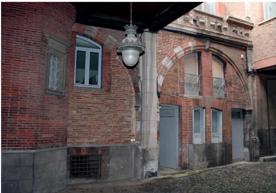
FIG. 5. TOULOUSE, DÉTAIL DU CORPS DE BÂTIMENT SUR COUR DE L'HÔTEL MOLINIER. Au rez-de-chaussée, les deux arcades du portique permettent encore d'imaginer la disposition originelle de ce bâtiment fortement remanié depuis son édification. Cliché Jean-Claude Lepert.
