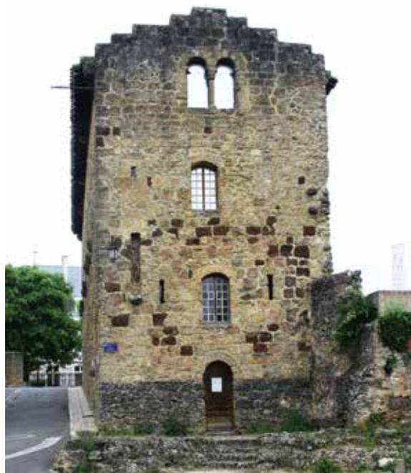
FIG. 38. MONT-DE-MARSAN, 5, RUE GASTON PHOEBUS – MUSÉE DUBALEN : façade sud, comportant un niveau supplémentaire (cave partiellement enterrée du côté nord). À droite, saillie du socle de la maison mitoyenne disparue. Au premier étage, à gauche de la baie, logette de latrines. Cl. P. Garrigou Grandchamp 2015.
