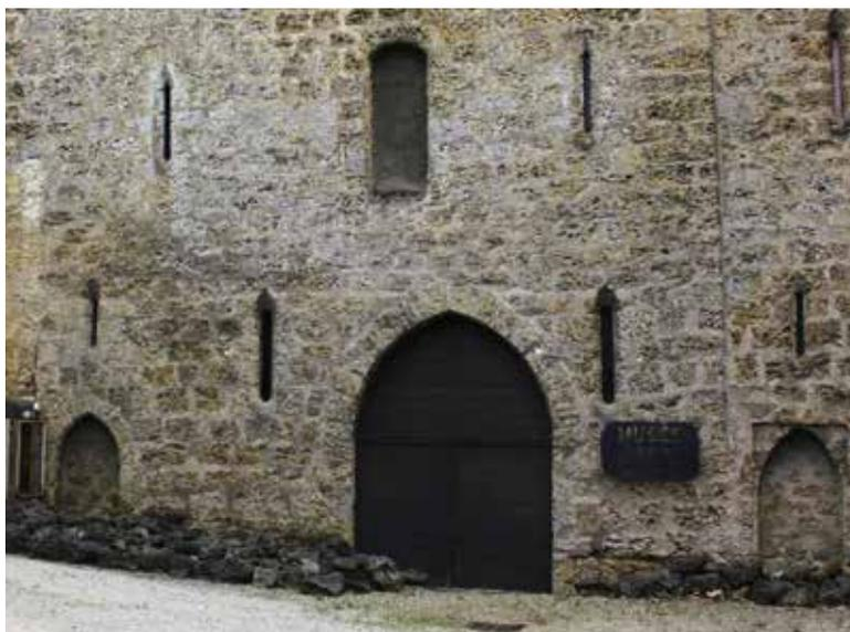
FIG. 43. MONT-DE-MARSAN, LACATAYE : façade nord du corps est ; rez-de-chaussée et premier étage. Arcade et portes reconstruites. Noter le type particulier des fentes et le linteau monolithe de la porte de l'étage. Cl. P. Garrigou Grandchamp 2015.
