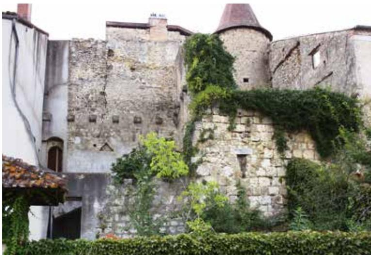
FIG. 56. ROQUEFORT-DE-MARSAN (40), 27, RUE ALPHONSE CASTAING (CAD.124, PARTIE SUD) : au premier plan, le mur arrière / est de la maison formait l'enceinte ; éventré, il laisse apparaître au fond un mur de refend parallèle ; à droite, un mur perpendiculaire à l'enceinte, qui est mitoyen entre deux maisons. Cl. P. Garrigou Grandchamp 2013.
