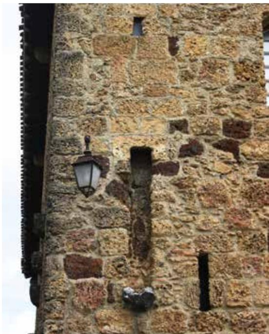
FIG. 39. MONT-DE-MARSAN, 5, RUE GASTON PHOEBUS – MUSÉE DUBALEN : façade sud, logette de latrines intramurale (dalles sur chant), avec fente d'éclairage et conduit d'évacuation. Cl. P. Garrigou Grandchamp 2015.
