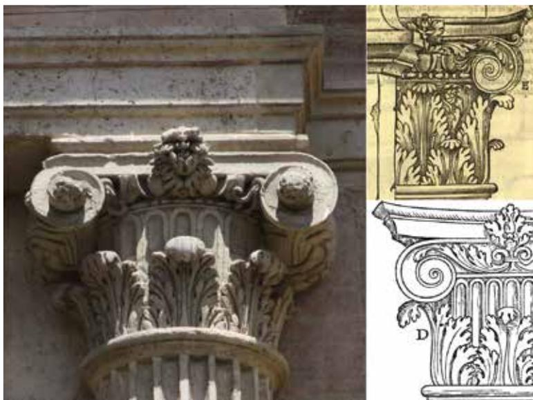
FIG. 8. TOULOUSE, L'ORDRE IONIQUE DE LA FAÇADE DE L'HÔTEL D'ASSÉZAT EST UNE COMBINAISON DE PLUSIEURS MODÈLES ANTIQUES COMPOSITES, aile droite de la demeure. *Cliché de l'auteur.*
