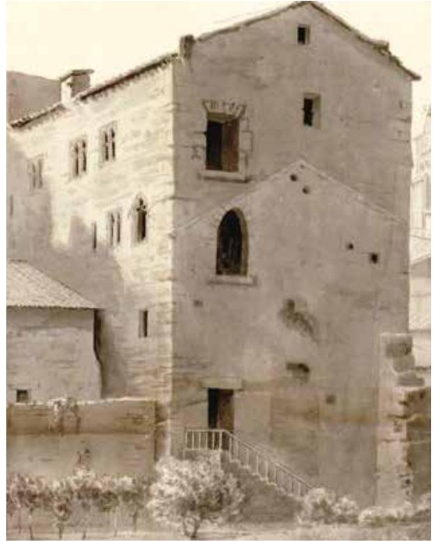
FIG. 63. MONT-DE-MARSAN, GRANDE DEMEURE (DÉTRUITE), AUTREFOIS 13, RUE LACATAYE : le détail montre les diverses formes des fenêtres géminées ou à réseau dans un arc brisé ; XIV<sup>e</sup> siècle. A.N. F-2, Landes 4.
