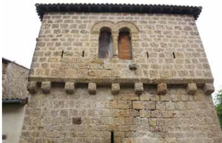
FIG. 9. MONT-DE-MARSAN, MAISON 6, RUE MAUBEC : façade sud, étage ; noter l'encorbellement et les quatre fentes qui encadrent la fenêtre.
