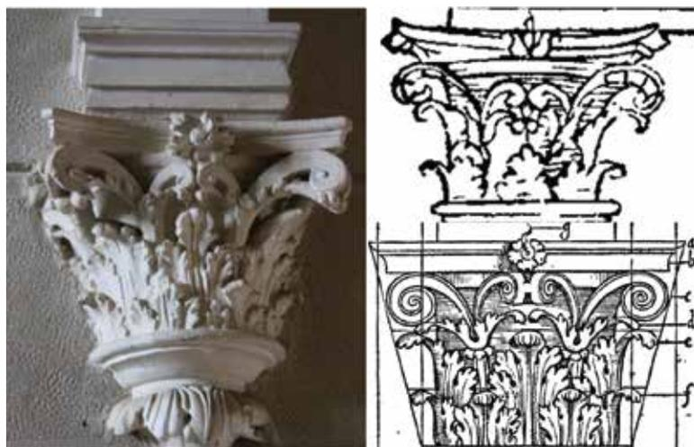
FIG. 3. CASTELNAU-D'ESTRÉTEFONDS, LA CAGE D'ESCALIER DU CHÂTEAU (1539-1546) A CONSERVÉ DES CHAPITEAUX CORINTHIENS DONT LE DESSIN PEUT ÊTRE RAPPROCHÉ DU SAGREDO FRANÇAIS (V. 1536, EN HAUT À DROITE) ET NON DES *REGOLE* DE SERLIO (1537, EN BAS À DROITE), VUE DEPUIS LE PALIER DU REZ-DE-CHAUSSÉE. *Cliché de l'auteur.*
