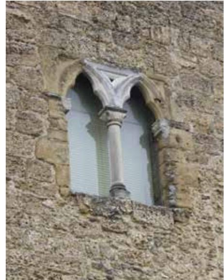
FIG. 47. MONT-DE-MARSAN, LACATAYE : façade sud du corps est. Fenêtre géminée du deuxième étage : les parties blanches sont des restaurations.
