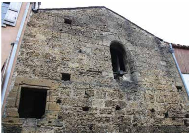
FIG. 26. MONT-DE-MARSAN, MAISON 24BIS, RUE MAUBEC : façade sud, étage ; quatre logements de poutres encadrent la porte en plein cintre, à encadrement chanfreiné. La baie à gauche, en calcaire gréseux jaune, a pris la place de la fente d'éclairage d'une armoire murale. *Cl. P. Garrigou Grandchamp 2015.*
