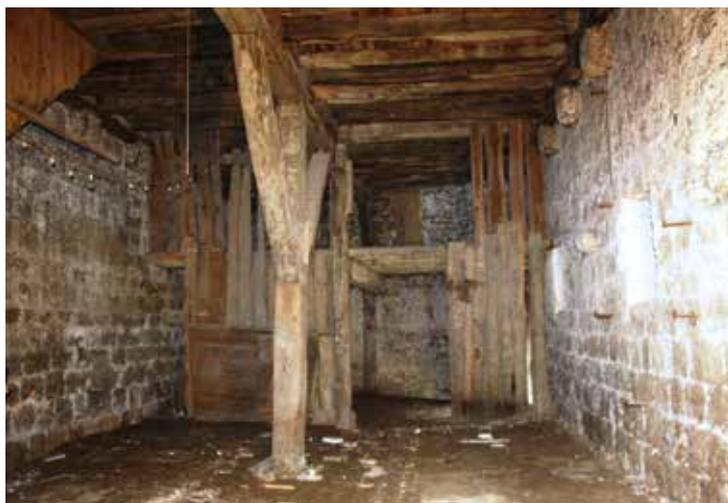
FIG. 17. MONT-DE-MARSAN, MAISON 6, RUE MAUBEC : intérieur, rez-de-chaussée, pièce arrière. Plafond sur poteaux, avec poutres posées sur des liernes portées par des corbeaux. Noter l'appareil régulier des faces internes des goutterots.
