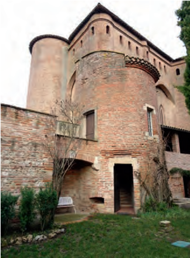
FIG. 25. TOUR, MUR M3. Face sud-ouest armée d'une canonnrière, Ca1 (USC 128). Cl. V. Rousset, 2020.
