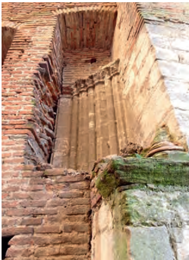
FIG. 14. MUR M1. Les vestiges du portail nord, P1. Cl. V. Rousset, 2020.
