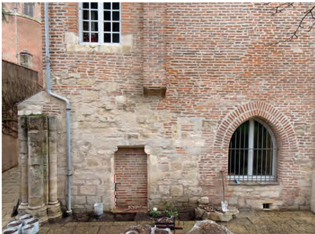
FIG. 22. MUR MM1. Vestiges des deux piles sud, Pi2, Pi3. Portes P5, P6. Cl. V. Rousset, 2020.
