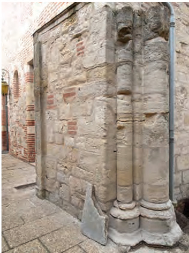
FIG. 23. MUR MM1. Vestiges du portail sud, P7, et de la pile sud, Pi2, de l'ancienne nef. Cl. V. Rousset, 2020.
