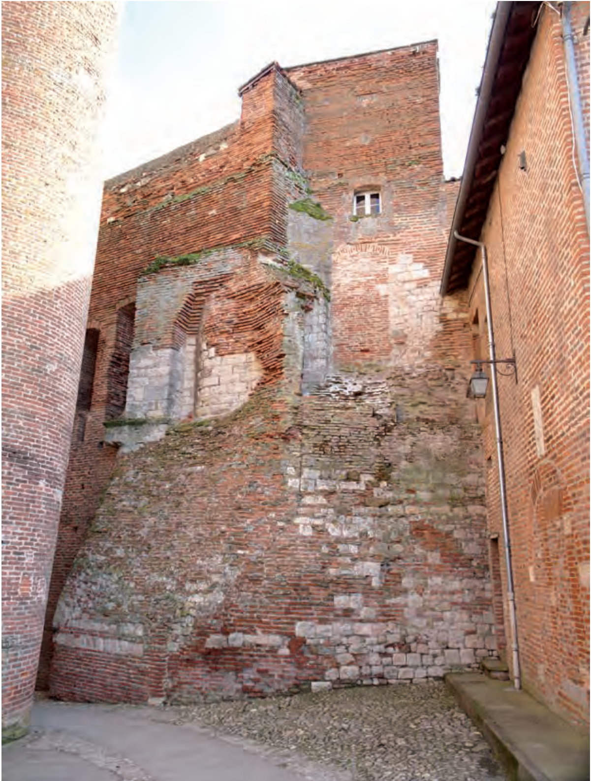
FIG. 4. L'ANCIEN MUR GOUTTEREAU NORD DE LA CATHÉDRALE. Murs M1 et M2 vus depuis le palais de la Berbie. Cl. V. Rousset, 2020.
