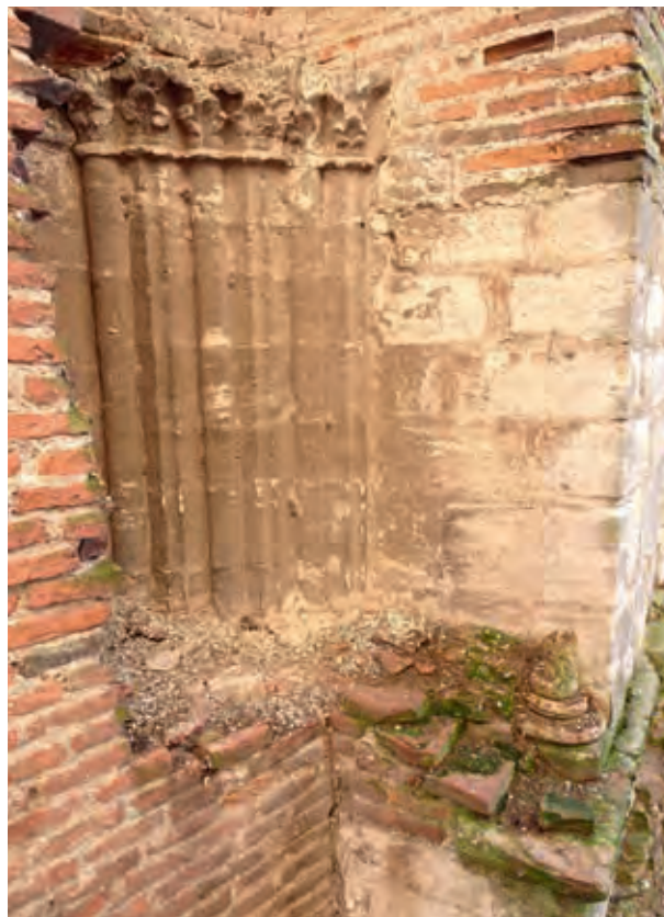
FIG. 15. MUR M1. Les vestiges du portail nord, P1. Cl. V. Rousset, 2020.
