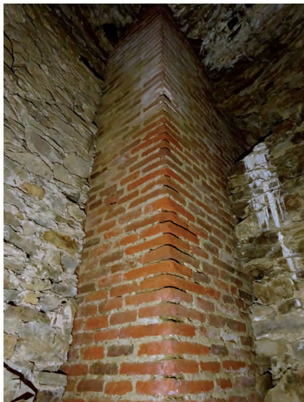
FIG. 13. LA TOUR, MUR M5. L'angle du bâtiment roman en brique à joints beurrés (murs 1 et 2). Cliché V. Rousset, 2019.
