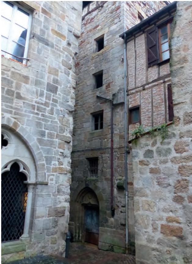
FIG. 5. VESTIGES DU MUR MITOYEN ENTRE LE 10, RUE SÉGUIER ET LE 2, IMPASSE BONHOMME, porte au rez-de-chaussée et piédroit de fenêtre au-dessus. Cl. C. Viers.
