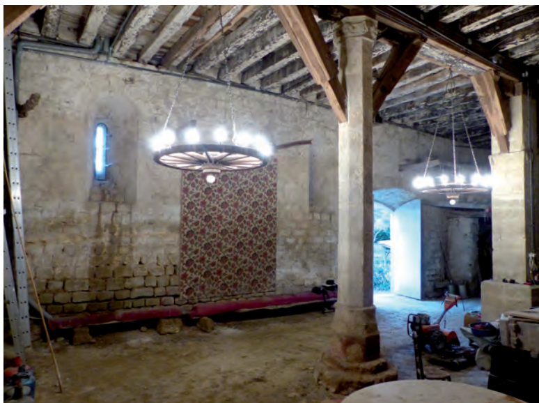
FIG. 9. VUE INTÉRIEURE DU REZ-DE-CHAUSSÉE, mur ouest : jours d'éclairément et piliers. Cliché C. Viers.
