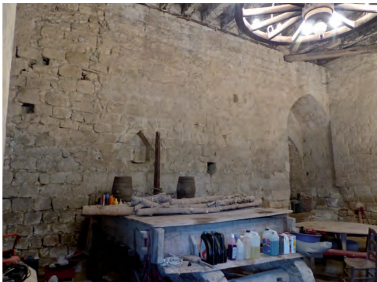
FIG. 8. VUE DU MUR OUEST DU REZ-DE-CHAUSSÉE : la porte au fond, le trou d'accès à la barre de fermeture, la niche à lumineaire. Cliché C. Viers
