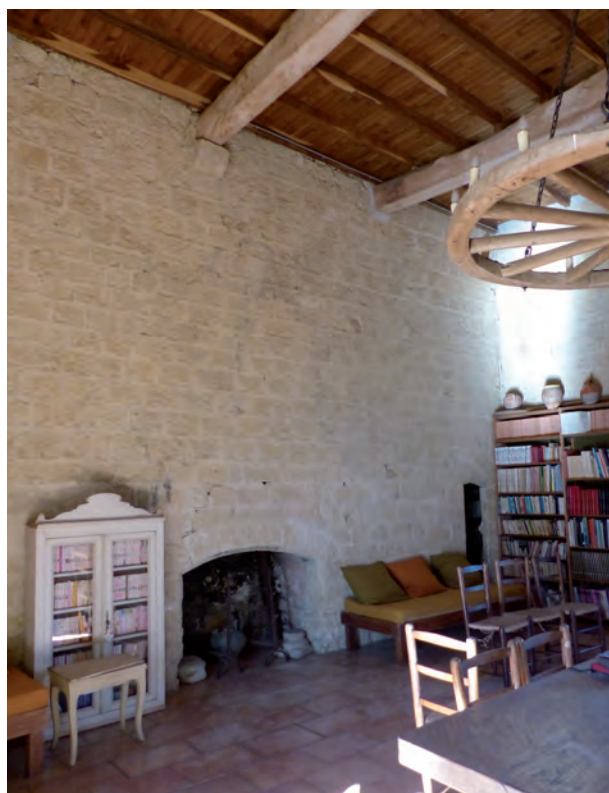
FIG. 20. MUR NORD DU 2 e ÉTAGE DE LA TOUR MAÎTRESSE, cheminée intégrée, porte de latrines et corbeau du plancher. Cliché C. Viers.
