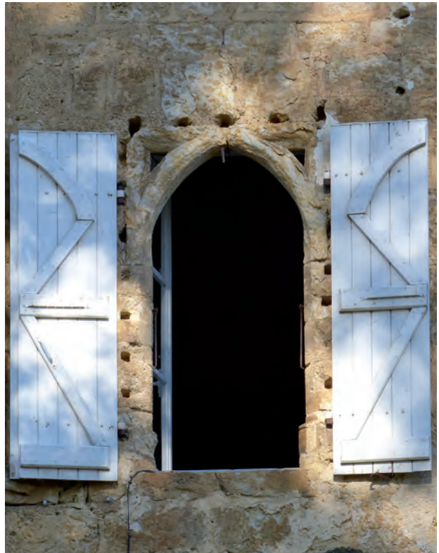
FIG. 5. FENÊTRE DU 1 ER ÉTAGE DE LA PETITE TOUR, façade sud-est. Cliché C. Viers.
