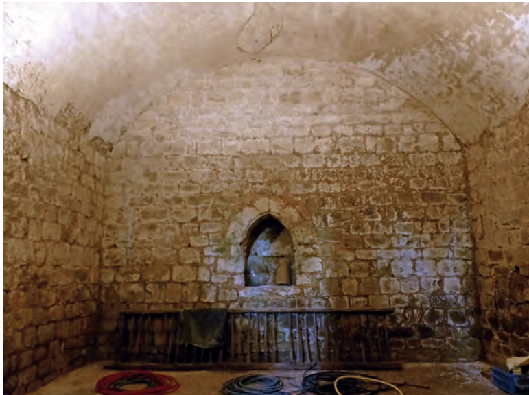
FIG. 12. MUR EST DU REZ-DE-CHAUSSÉE DE LA TOUR MAÎTRESSE, placard et couvremnt. Cliché C. Viers.
