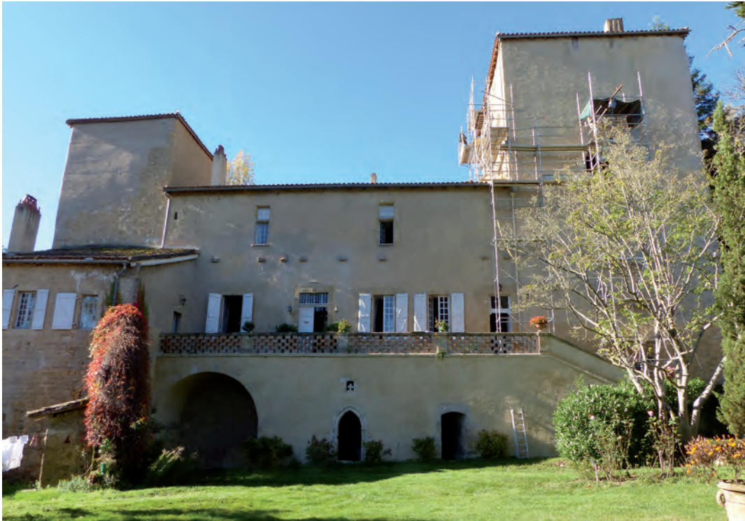
FIG. 16. FAÇADE EST, annexe en pierre et ligne de corbeaux de la charpente au-dessus de la terrasse construite en 1815. Cliché C. Viers.
