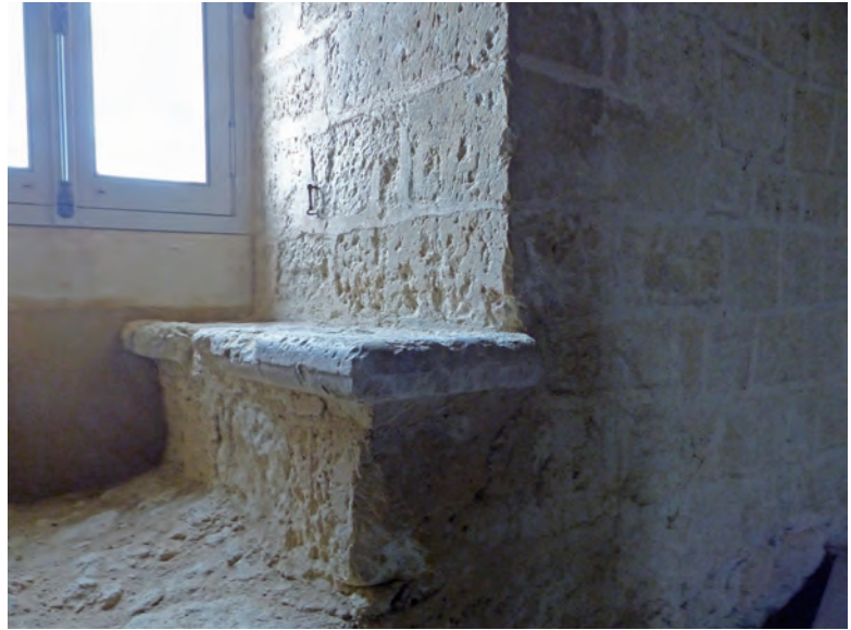
FIG. 6. DÉTAIL D'UN COUSSIÈGE, au dernier étage de la tour maîtresse. Cliché C. Viers.
