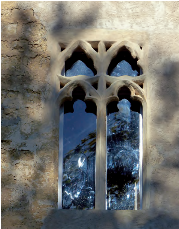
FIG. 4. FENÊTRE DU 2 E ÉTAGE DE LA PETITE TOUR, façade sud-est. Cliché C. Viers.
