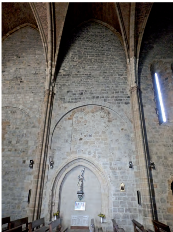
FIG. 19. GOUTTEREAU NORD. Arcade de décharge de la deuxième travée. Le segment de maçonnerie contenu sous l'arcade est le remploi d'une construction antérieure ainsi que la fenêtre géminée murée. La porte murée, pratiquée à la fin du XIV e siècle, donnait accès à une chapelle funéraire. Cliché B. Sournia.
