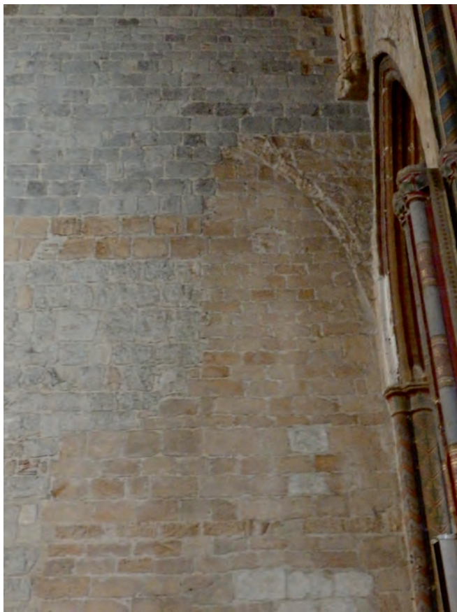
FIG. 9. BRANCHE DE L'ARC FORMERET de la dernière travée du collatéral nord, bûchée après abandon du parti à trois vaisseaux. Cliché B. Sournia.
