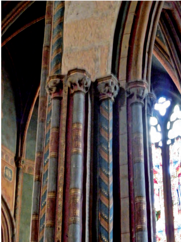
FIG. 12. PILE ÉPARGNÉE de la nef à triple vaisseau : on discerne, au-dessus des chapiteaux, deux assises de sommiers, en grès ocre, arasées. Cliché B. Sournia.
