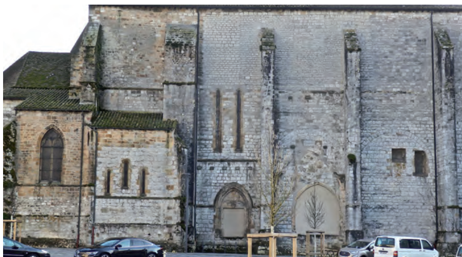
FIG. 19. GOUTTEREAU NORD. Arcade de décharge de la deuxième travée. Le segment de maçonnerie contenu sous l'arcade est le remploi d'une construction antérieure ainsi que la fenêtre géminée murée. La porte murée, pratiquée à la fin du XIV e siècle, donnait accès à une chapelle funéraire. Cliché B. Sournia.
