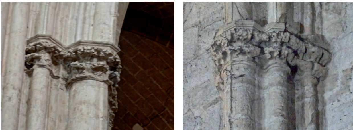
FIG. 31. CHAPITEAUX COMPARÉS de Bayonne, à gauche, et d'Orthez, à droite (pile, face méridionale, à la limite des deuxième et troisième travées). Clichés B. Sournia.
