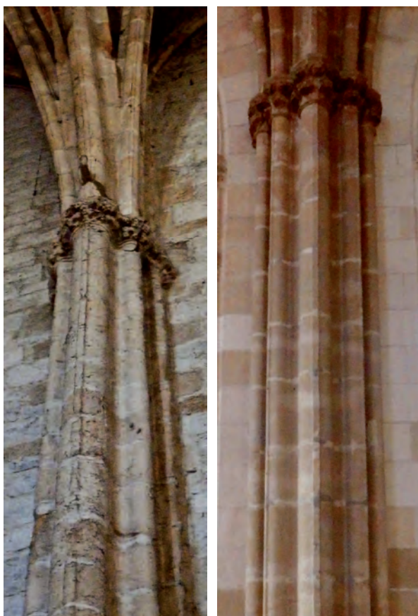
FIG. 15 ET 16. ORTHEZ, une pile du gouttereau méridional. À droite, BAYONNE CATHÉDRALE, une pile du collatéral méridional.
