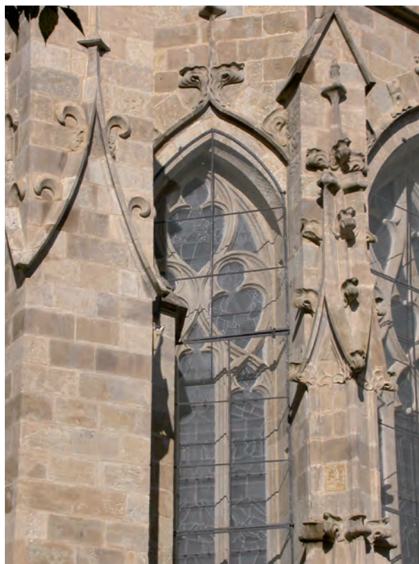
FIG. 12. AUCH, CATHÉDRALE NOTRE-DAME, partie supérieure du remplage biais du pan sud-ouest de la première chapelle sud du déambulatoire. Cliché J. Dubois.
