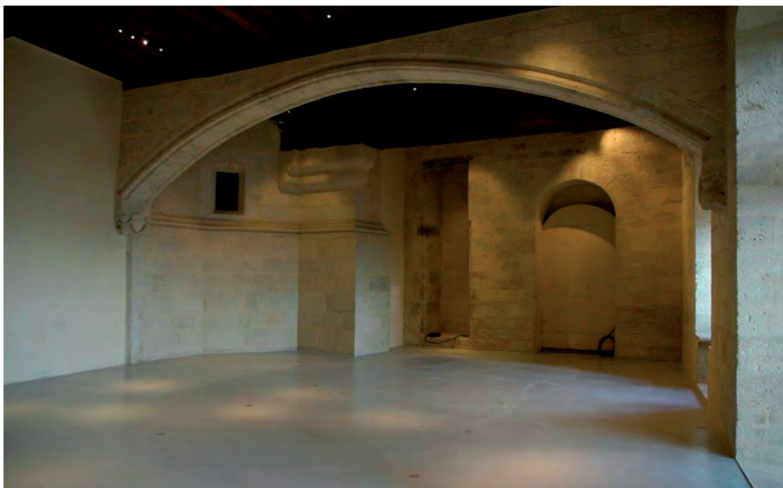
FIG. 5. AUCH, REZ-DE-CHAUSSÉE DE LA CHANOINIE, mur ouest. Cliché P. Arnaud.
