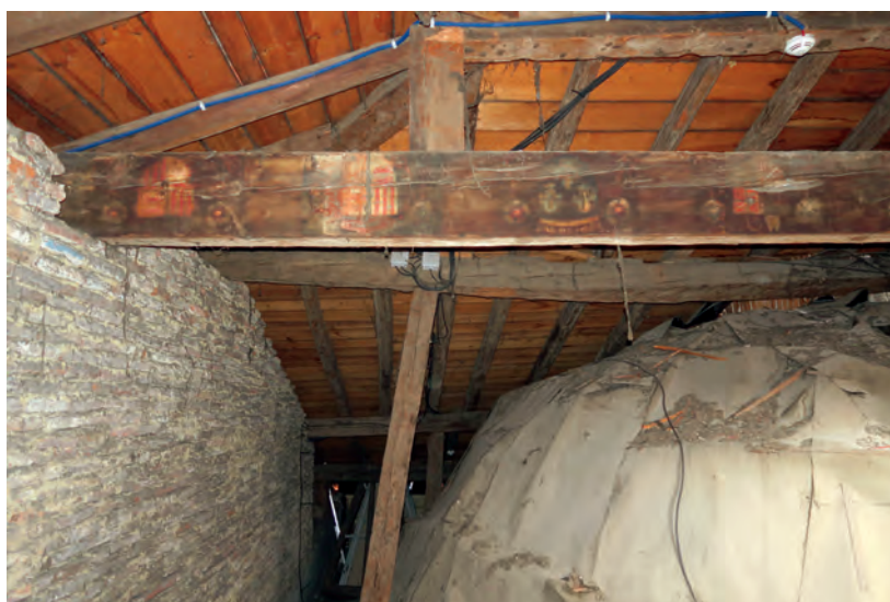
TOULOUSE, COLLÈGE DE FOIX. Poutre peinte employée dans la charpente. Cl. V. Dumoulin.
