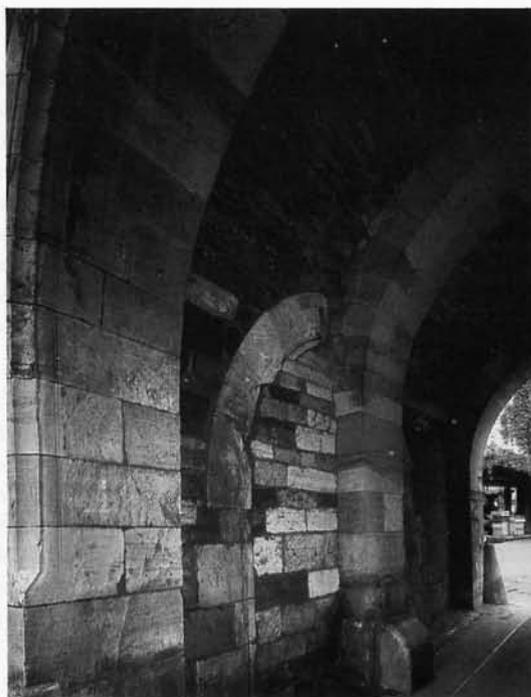
FIG. 12 - PORTE MUREE AU REZ-DE-CHAUSSEE DE LA TOUR, SOUS LE PASSAGE (Cl. C. Soula, Inventaire Général).
