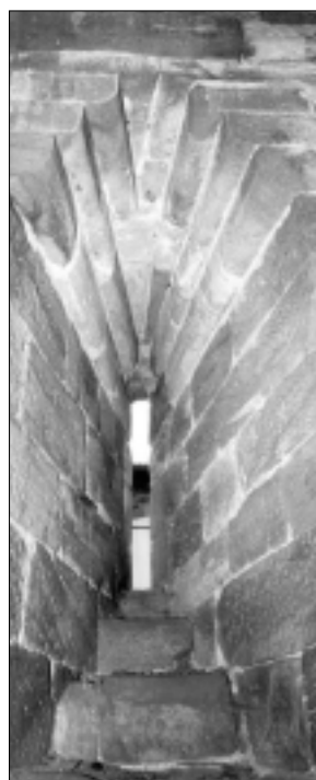
FIG. 13. ARRIÈRE-VOUSSURES À RESSAUTS DE COUSSINETS. CARDAILLAC, tour de l'Horloge, fente de jour (prem. tiers XIII e ?). CHÂTEAU DE CASTELNAUD-LA-CHAPELLE (Dordogne), fente de tir attribuée à Bertrand de Cardaillac (1259-1261).
