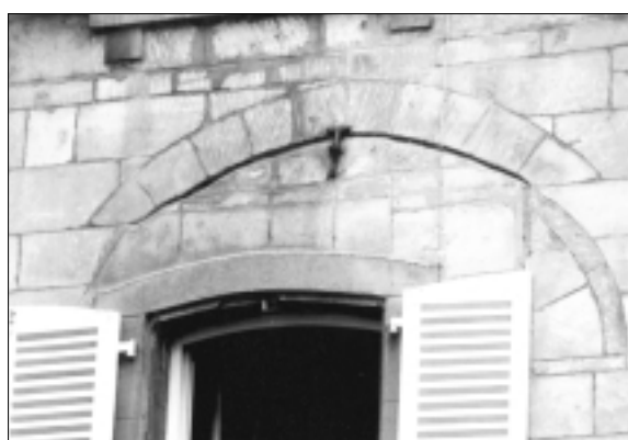
FIG. 28. FIGEAC : FENÊTRES À COUVERMENTS D'EMBRASURE TRAVERSANTS (seconde moitié du XIII e siècle ?). 17, RUE DE CLERMONT : fenêtre à remplage sur linteau. RUE DELZENS : fenêtre à colonnette prismatique. PLACE CARNOT : fenêtre clavée, doublement surmontée d'un larmier décoratif (vestiges bûchés) et d'un arc de décharge solidaire du couvrement d'embrasure.
