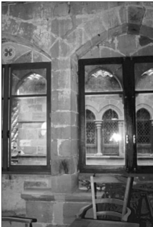
FIG. 54. CORDES, MAISON DU PRESBYTÈRE, vestiges du décor peint des embrasures. La trace verticale sur l'angle gauche du trumeau indique l'emplacement d'une ancienne cloison.
