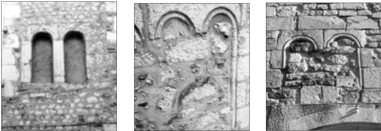
FIG. 23. FENÊTRES ROMANES ARCHAÏQUES EN AQUITAINE. Baies à cintres monolithes et meneaux, dépourvues de cordons d'imposte. AGEN, rue du Puits du Saumon, fenêtre (triple ?), percée dans une élévation de petit appareil cubique (XI e -début XII e siècle ?). PÉRIGUEUX, hôtel d'Abzac, rue Aubergerie (cliché P. Garrigou Grandchamp). CADOUIN, logis abbatial (peu après 1125).
