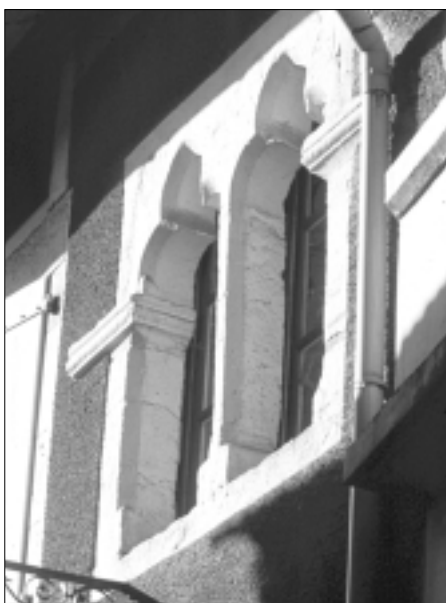
FIG. 40. LUZECH (Lot), maison du « barri », dans le quartier neuf fondé vers 1270. Fenêtre géminée à meneau, dépourvue de chapiteau, mais avec persistance du cordon d'imposte.
