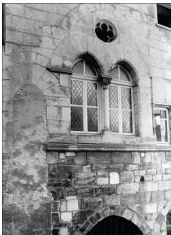
FIG. 55. FIGEAC RUE DU CONSULAT. Ancienne élévation sur cour caractérisée par l'association d'une fenêtre et d'une porte (murée).
