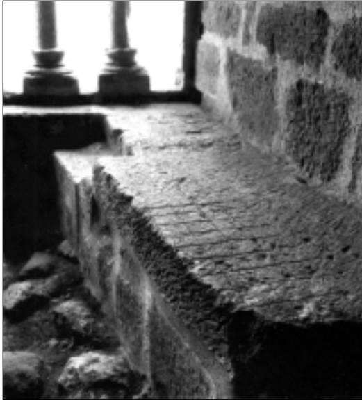
FIG. 1. COMARQUE (Dordogne). La grande fenêtre « romane » (fin XII e et milieu XIII e siècle?). L'échiquier gravé dans l'ancien appui plein de la fenêtre a été sectionné par la raitelle tardive de coussièges au XIV e siècle.
