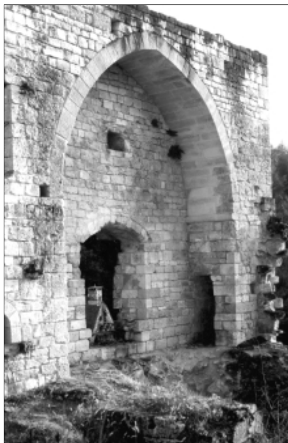
FIG. 22. SAINT-AMAND-DE-COLY (Dordogne), ruines du logis abbatial. Fenêtre sans allège à double embrasure, inscrite dans une niche ou une arcade intérieure destinée à en faciliter l'accès (première moitié du XIII e s.).
