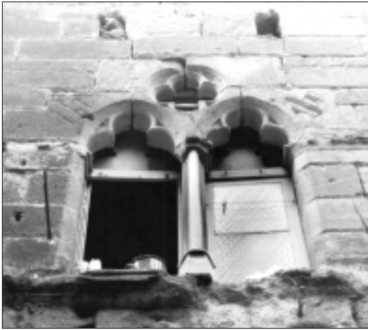
FIG. 29. RODEZ. FENÊTRE GÉMINÉE À REMPLAGE EN TAS DE CHARGE. Couvrement composé de cinq éléments en quinconce, équilibrés en bascule (XIV e siècle ?). Meneau-colonnette.
