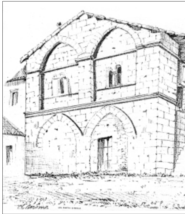
FIG. 56. ARCADES D'ÉTAGES. LAUZERTE: arcade d'étage murée. BRANTÔME: arcades aveugles servant de décharge à des parois allégées, percées par des fenêtres géminées (début XIII e siècle ?). Dessin de F. de Verneilh, XIX e siècle.
