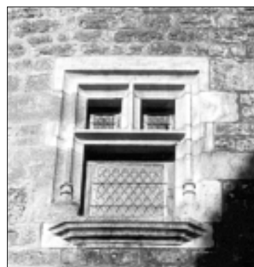
FIG. 51. CHÂTEAU DE VAILLAC (Lot). Croisée « quercinoise », dépourvue de meneau en partie basse (deuxième moitié XV e siècle ?)
