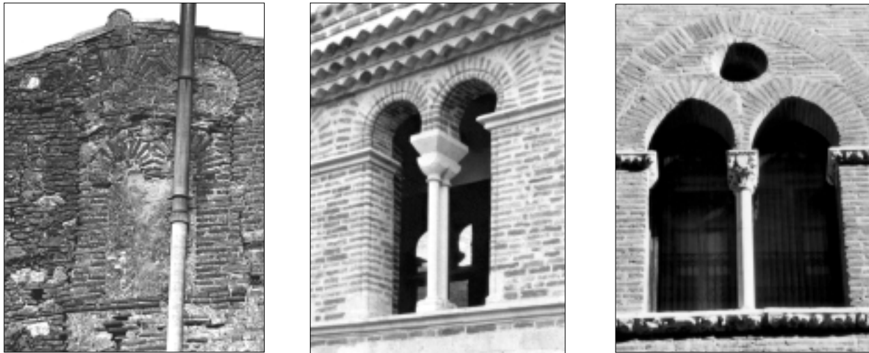
FIG. 16. LE MODÈLE TOULOUSAIN : fenêtres géminées en briques inscrites dans des archivoltes, avec persistance de l'arc outrepassé reposant directement sur le tailloir sans l'intermédiaire d'un sommier de pierre.
