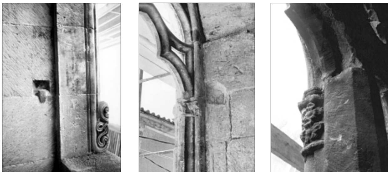
FIG. 59. LA FEUILLURE INTERNE DE LA FENÊTRE.
