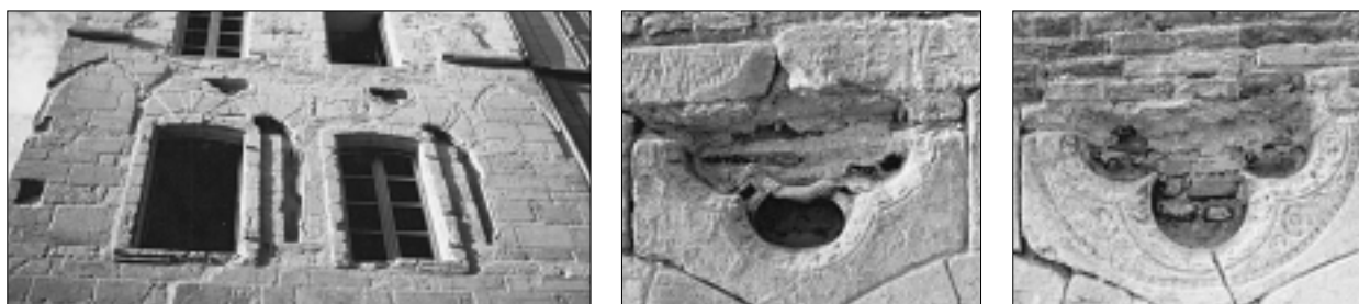
FIG. 34. FIGEAC, MAISON URBAINE, rue d'Aujou (vers 1230 ?). Composition de façade inscrite dans un cordon festonné formant larmier. À droite, détail des oculi d'écoinçon.
