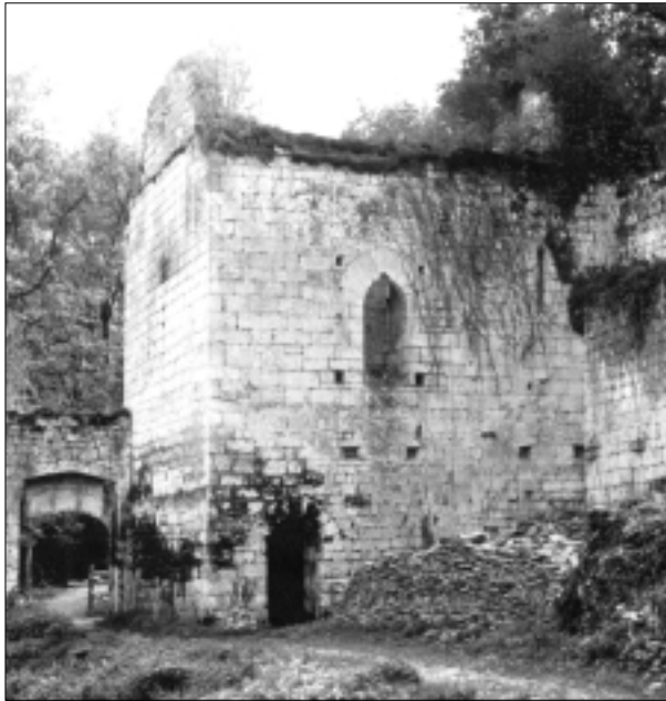
FIG. 8. COMARQUE (Dordogne). L'absence de fenêtre à l'étage unique de cet édifice résidentiel éclairé par de simples fentes de jour induit l'hypothèse d'un second étage (de charpente ?), disparu ou non réalisé.
