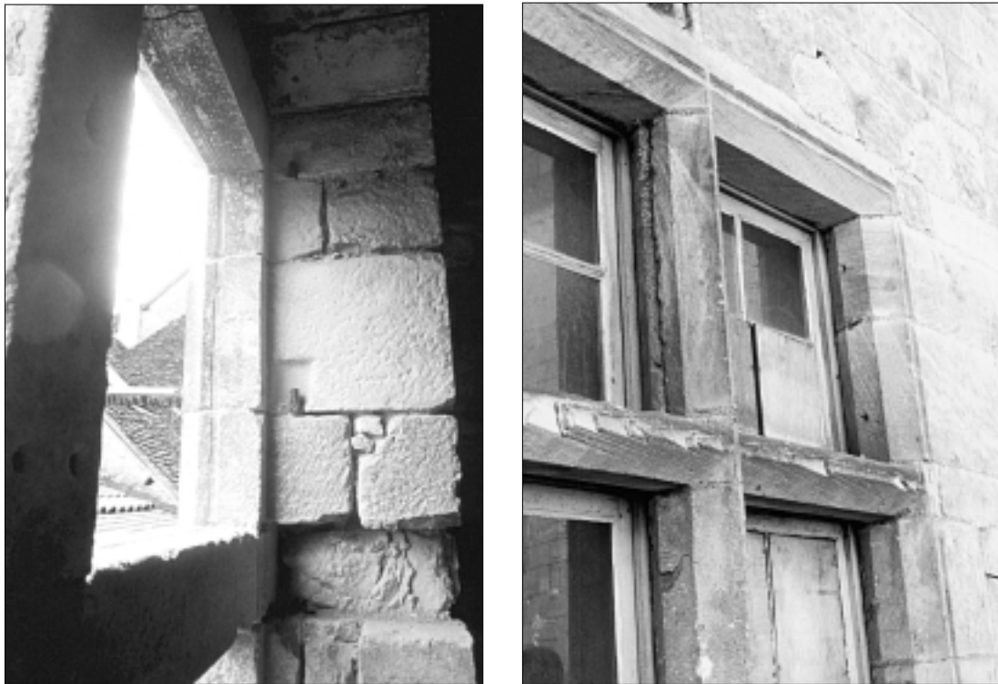
FIG. 64. FEUILLURES DANS LES CROISILLONS SUPÉRIEURS DES CROISÉES. ROCAMADOUR : feuillure régulière et soignée ménagée lors de la réalisation de l'ouvrage de pierre. FIGEAC (hôtel de Balène), feuillures et trous d'encastrement en vis-à-vis, maladroitement retaillées après coup.
