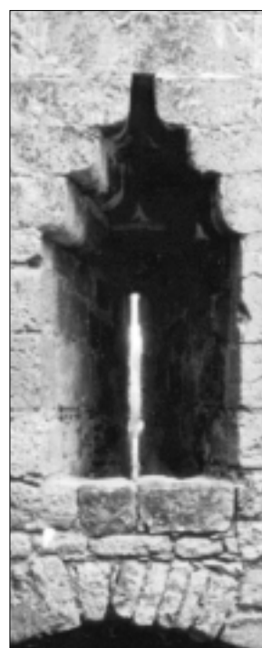
FIG. 13. ARRIÈRE-VOUSSURES À RESSAUTS DE COUSSINETS. CARDAILLAC, tour de l'Horloge, fente de jour (prem. tiers XIII e ?). CHÂTEAU DE CASTELNAUD-LA-CHAPELLE (Dordogne), fente de tir attribuée à Bertrand de Cardaillac (1259-1261).
