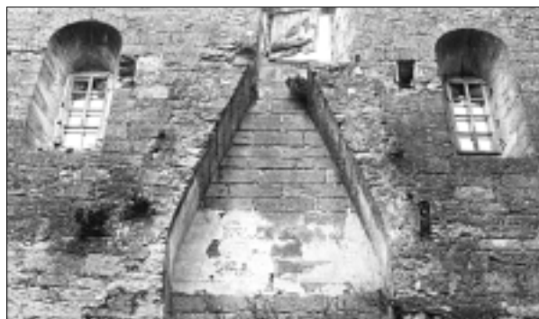
FIG. 57. SAINT-FÉLIX-DE-LAURAGAIS : fenêtres hautes inaccessibles encadrant symétriquement la hotte de cheminée d'une salle.
