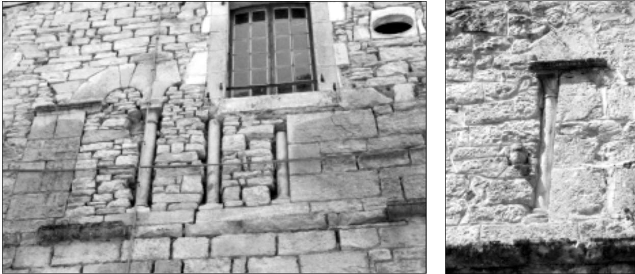
FIG. 9. LE MODÈLE AMADOURIEN (1 er quart XIII e siècle). Fenêtres géminées ou multiples accostées de colonnettes latérales sous moulure d'imposte. MARTEL, rue Droite : fenêtre triple condamnée (la colonnette de gauche est manquante). ROCAMADOUR, maison dite de la Pommette, colonnette latérale en place, provenant d'une ancienne fenêtre condamnée.
