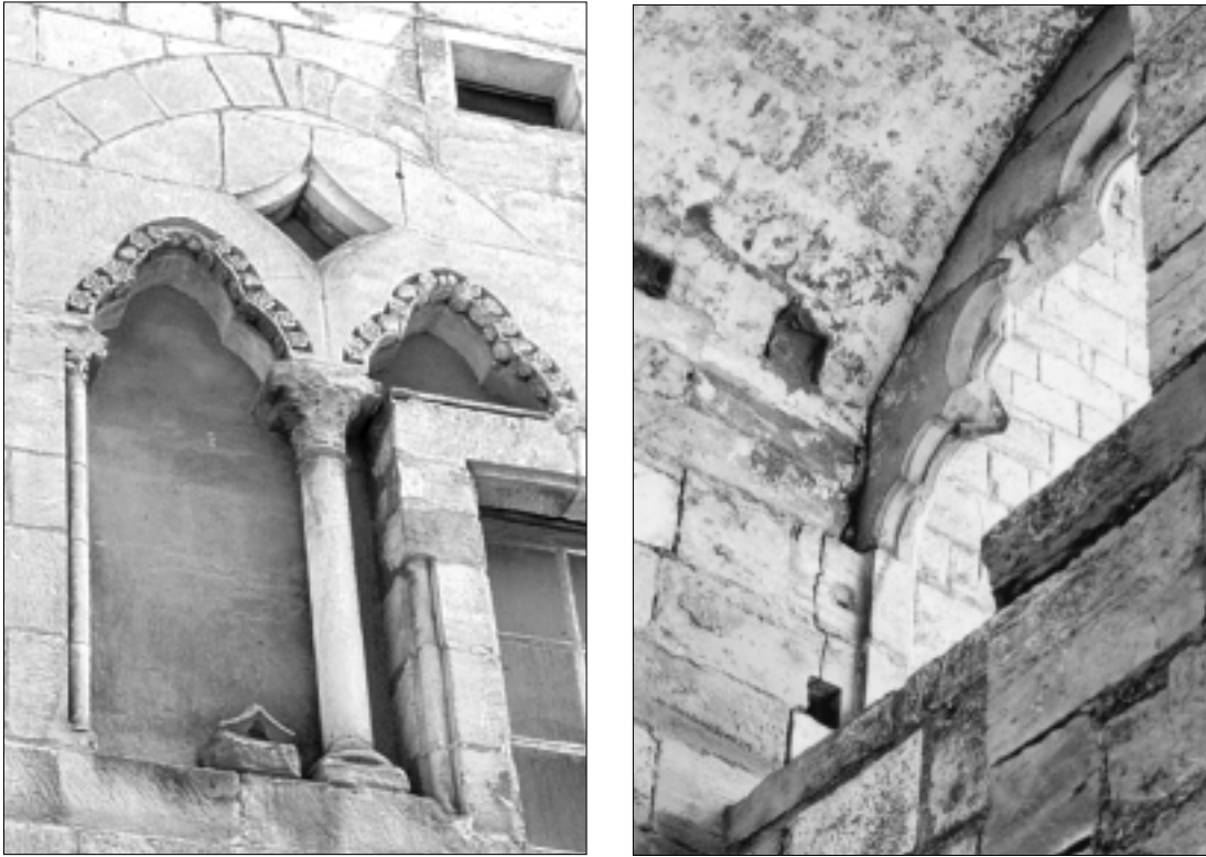
FIG. 62. FEUILLURES DE VITRAGES FIXES.
