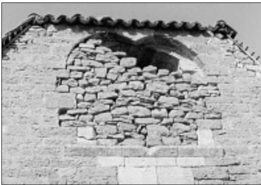
FIG. 35. FANTÔMES DE FENÊTRES À SARLAT ET À CAMBOULIT (Lot) : la disparition des formes externes des baies démontre leur affranchissement de tout rôle porteur. La stabilité du parement est assurée tantôt par une amélioration structurelle (larmier porteur à Sarlat), tantôt par l'amélioration de la qualité des mortiers (effet de tas de charge à Camboulit).
