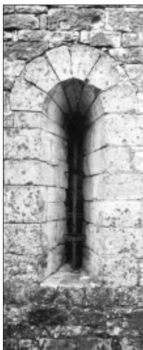
FIG. 12. FENÊTRES DE CAVES MULTIFONCTIONNELLES À DOUBLE ÉBRASEMENT (fentes de jour et de tir?). EXCIDEUIL, maisons fortes : distinction formelle à signification emblématique (chaque édifice se signale par une forme particulière).
