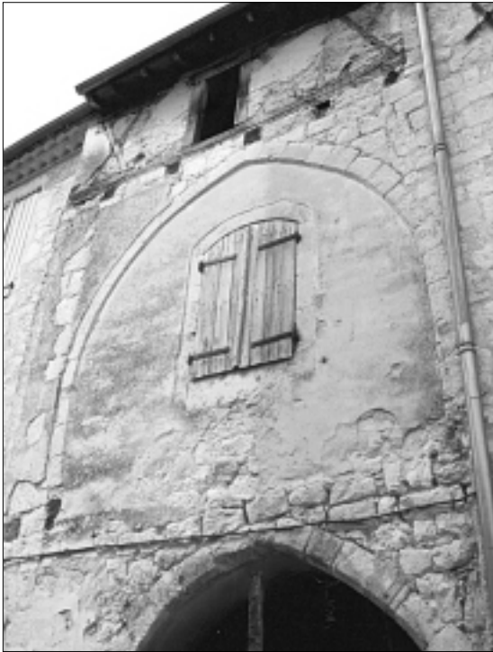
FIG. 56. ARCADES D'ÉTAGES. LAUZERTE: arcade d'étage murée. BRANTÔME: arcades aveugles servant de décharge à des parois allégées, percées par des fenêtres géminées (début XIII e siècle ?). Dessin de F. de Verneilh, XIX e siècle.
