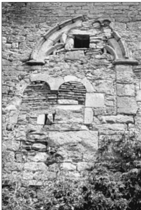
FIG. 5. LA PERSISTANCE DES FORMES ROMANES À L'ÉPOQUE MODERNE. BORIE DE SAVANAC (Lamagdelaine, Lot) : fenêtre géminée reperçée au XV e -XVII e siècle dans une ancienne baie médiévale réticulée.
