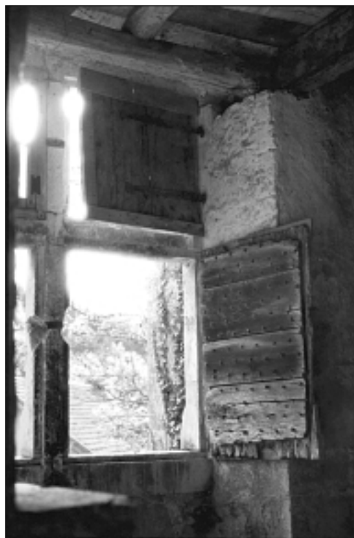
FIG. 61. BOUZIÈS (LOT), REPAIRE DE CONDAT. Croisée du XVII e siècle de type médiéval avec gâches métalliques engagées dans le meneau et volets pleins de planches cloutées.
