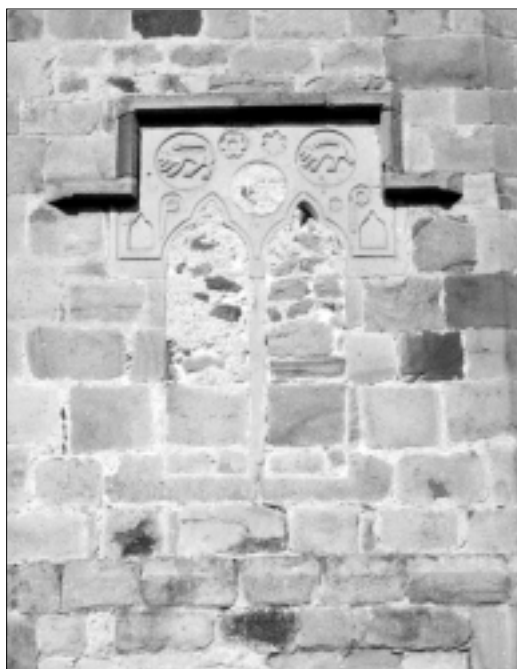
FIG. 31. ÉGLISE DE SAINT-ANGEL (Corrèze): remplage monolithique encadré par un larmier rectangulaire avec oculus d'écoinçon fictif (XV e siècle).
