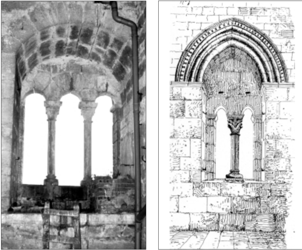
FIG. 21. FENÊTRES À APPUIS PLEINS DE LA PREMIÈRE MOITIÉ DU XIII e SIÈCLE (embrasures intérieures). BÉDUEUR (Lot), fenêtre haute du donjon. LA RÉOLE (Gironde), ancien hôtel de ville ( d'après Drouÿn, La Guyenne militaire, pl. 48 ).
