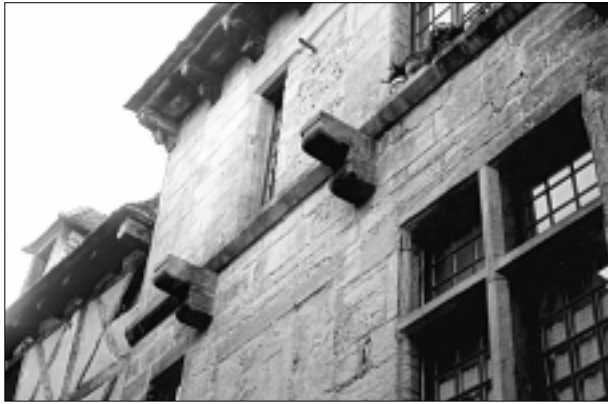
FIG. 66. LES ACCESSOIRES DE LA FENÊTRE. SARLAT, alignement de corbeaux de pierre sous la ligne d'appui des fenêtres (croisées, XIV e siècle).
