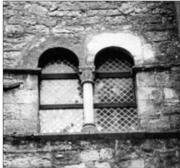
FIG. 10. SAINT-ANTONIN-NOBLE-VAL, ANCIEN HÔTEL DE VILLE. Fenêtre géminée couverte par des arcs monolithes en plein cintre extradossé (l'arc de droite résulte d'une réfection fautive).
