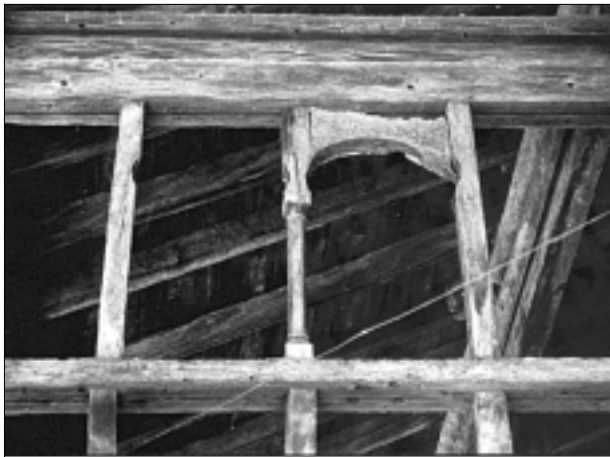
FIG. 47. BLESLE (HAUTE-LOIRE), MAISON DÉTRUITE. Exemple exceptionnel d'une fenêtre réticulée, réalisée en bois, et insérée dans une élévation maçonnée de moellons (Photo R. Choplain et R. Maston, © Inventaire général, ADAGP).
