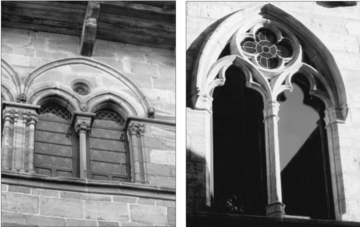
FIG. 33. Évolution du larmier et de l'oculus d'écoinçon : CORDES, maison Prunet, XIII e siècle. SARLAT, impasse des Mirepoises, XIV e siècle.
