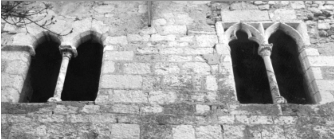
FIG. 26. LA BORDE-DES-PREZ (Montpezat-de-Quercy, Tarn-et-Garonne). Vraisemblablement rapprochées, les deux campagnes de construction de l'édifice sont marquées par l'abandon des arcs clavés au profit d'arcs trilobés inscrits dans un réseau.
