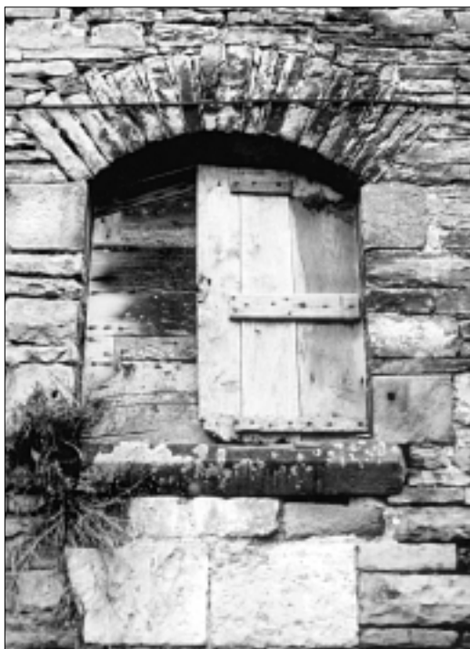
FIG. 42. CORDES. Fenêtre pleine sans meneau (à l'italienne ?), couverte par un cintre segmentaire (XIV e siècle ?).
