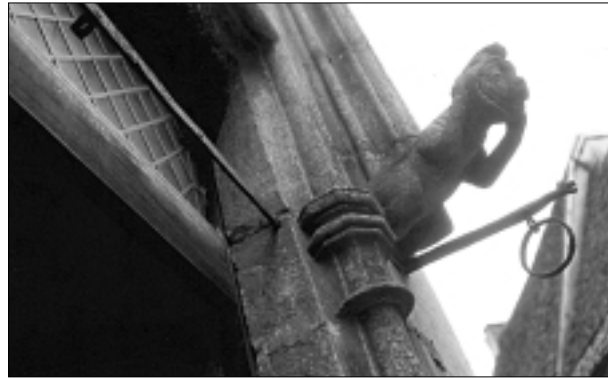
FIG. 63. HÔTEL PLAMONT À SARLAT : croisée réticulée. La barlotière basse, destinée à maintenir le vitrage fixe est en place de même que l'anneau de bannes suspendu à un fer décoré d'une tête animale.
