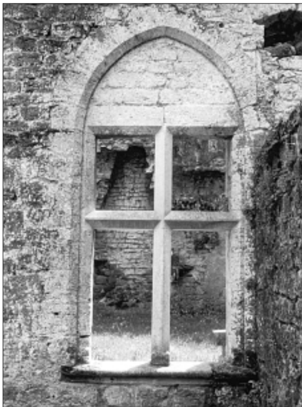
FIG. 44. EXEMPLES PRÉCOCES D'UTILISATION DE LA CROISÉE EN AQUITAINE.
