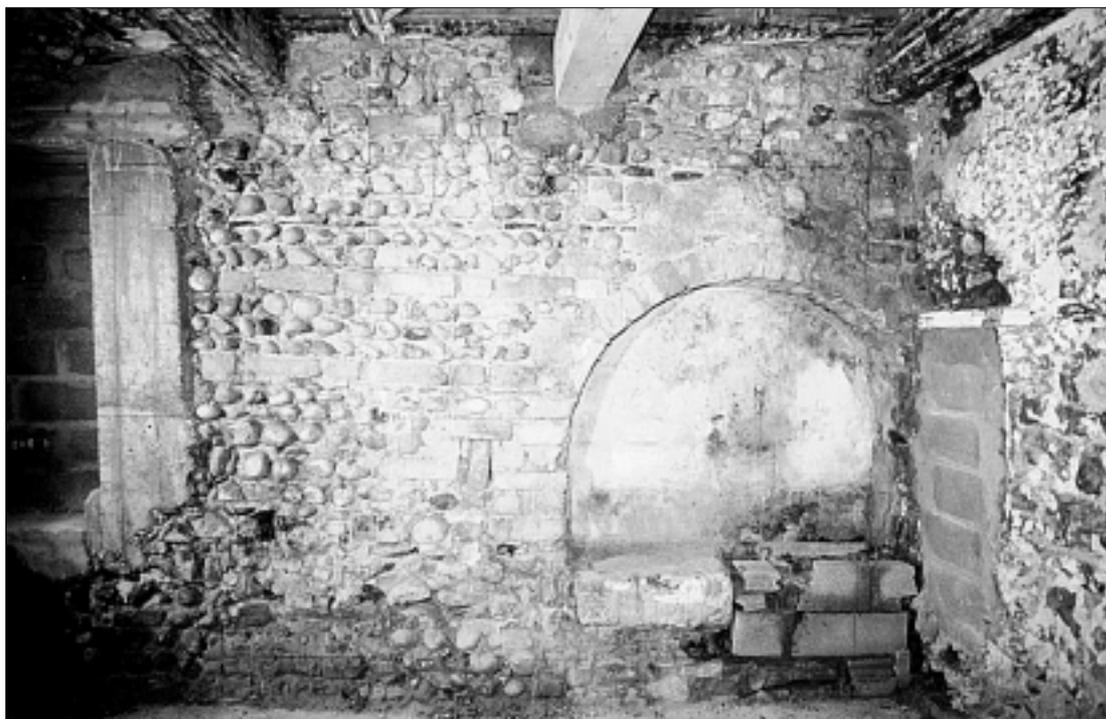
FIG. 17. GRENOBLE (ISÈRE). APPAREIL MIXTE, EN BRIQUES ET GALETS, au n° 20 de la rue Saint-Laurent.
