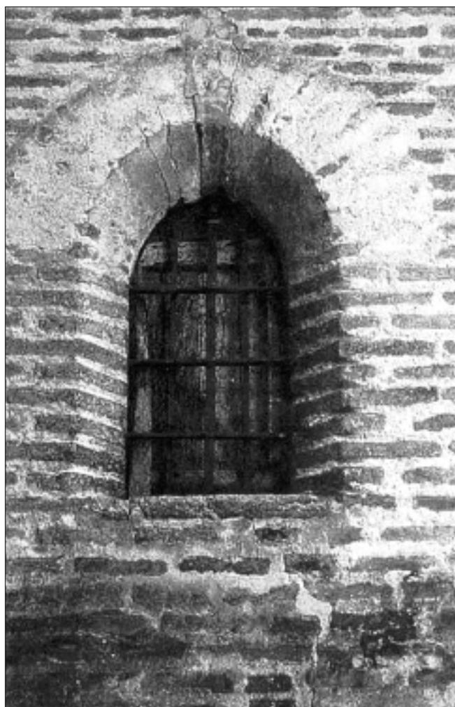
FIG. 14. CAUSSAGE (TARN-ET-GARONNE). BAIE REHAUSSÉE D'UN ENDUIT MINCE IMITANT LA PIERRE. Détail de la tour d'Arles. Cliché M. Scellès, 1991.
