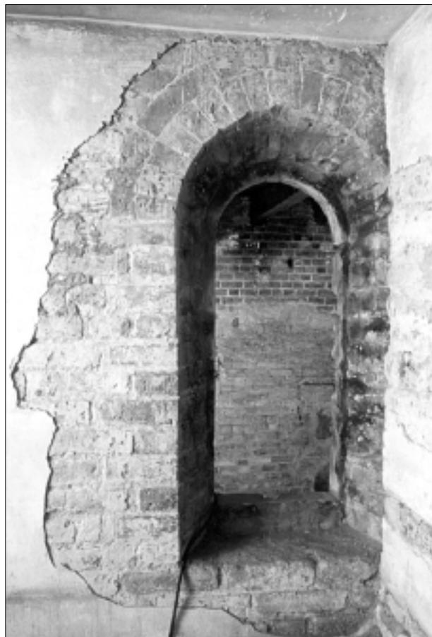
FIG. 19. GRENOBLE (ISÈRE). DÉTAIL D'UNE BAIE (FIN DU XIII<sup>e</sup> S.) DE L'ANCIENNE RÉSIDENCE DES ÉVÊQUES. Remarquer le soin apporté à l'appareillage de la partie cintrée. Cliché CPI, 1989.
