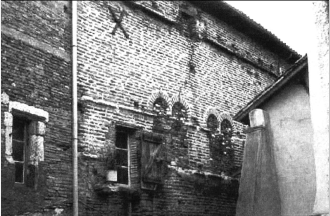
FIG. 10. CAUSSADE (TARN-ET-GARONNE). UN EXEMPLE DE PAREMENT DE BRIQUE, CARACTÉRISTIQUE DU SUD-OUEST DE LA FRANCE :
