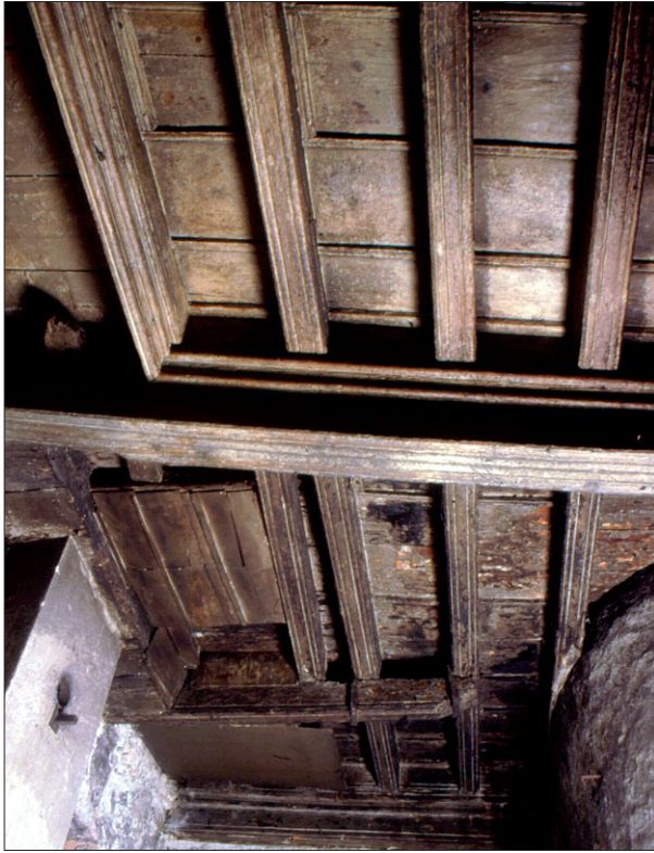
FIG. 15. IMMEUBLE N° 69, RUE SAINT-LAURENT : plafond du 1 er étage de la maison IVb. Cliché S. Petit (C.P.I.).
