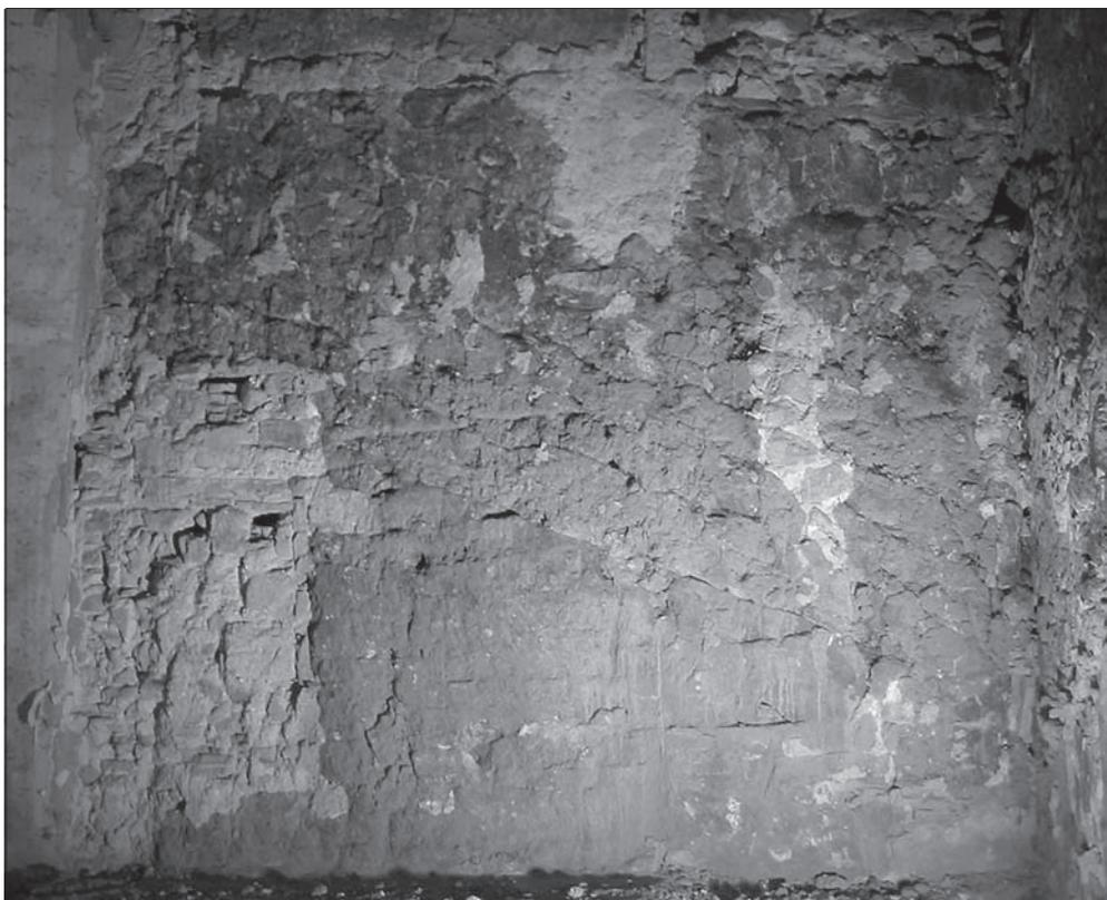
FIG. 8. MUR DE REFEND MONTRANT PLUSIEURS ÉTATS : état primitif en bauge massive indiqué par le pendage du pignon; rattrapage formé par plusieurs rangs de terre séparés par des végétaux; surélévation en terre massive. Montagnac, Hôtel de Rosines (Hérault).
