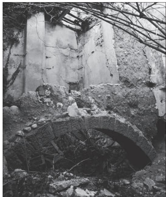
FIG. 21. ARCADE EN PIERRE DE TAILLE placée dans un mur en terre à Carpentras (Vaucluse). Cliché F. Guyonnet.
