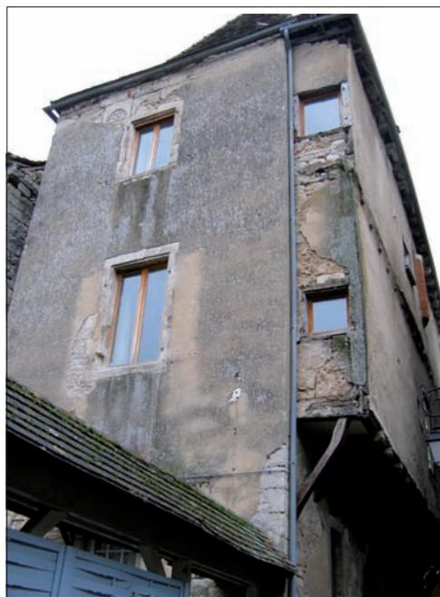
FIG. 9. MAISON DE LA RUE DU PRESSEUR À MARTEL (LOT), vue du mur pignon sud avec les traces d'une fenêtre triple au second étage et le profil de l'encorbellement. Cliché A-L. Napoléone.
