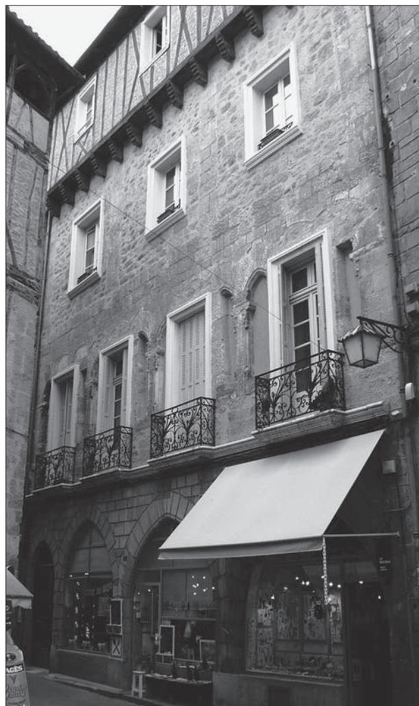
FIG. 7. MAISON N° 4 DE LA RUE SÉGUIER À FIGEAC (LOT), pan de bois non porteur restitué au-dessus du premier étage grâce aux têtes de mur et aux deux piles encore visibles. *Cliché A.-L. Napoléone.*
