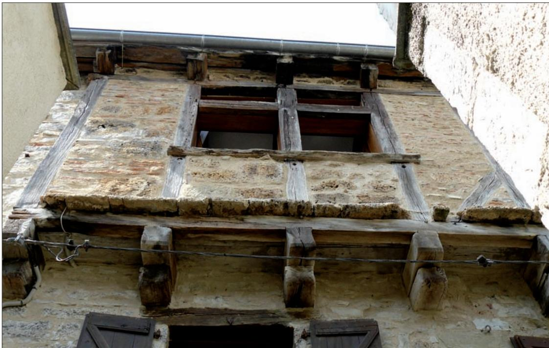
FIG. 24. MAISON RUE DE LA PLUME À CAJARC (LOT) : détail de la fenêtre du second étage. *Cliché A.-L. Napoléone.*
