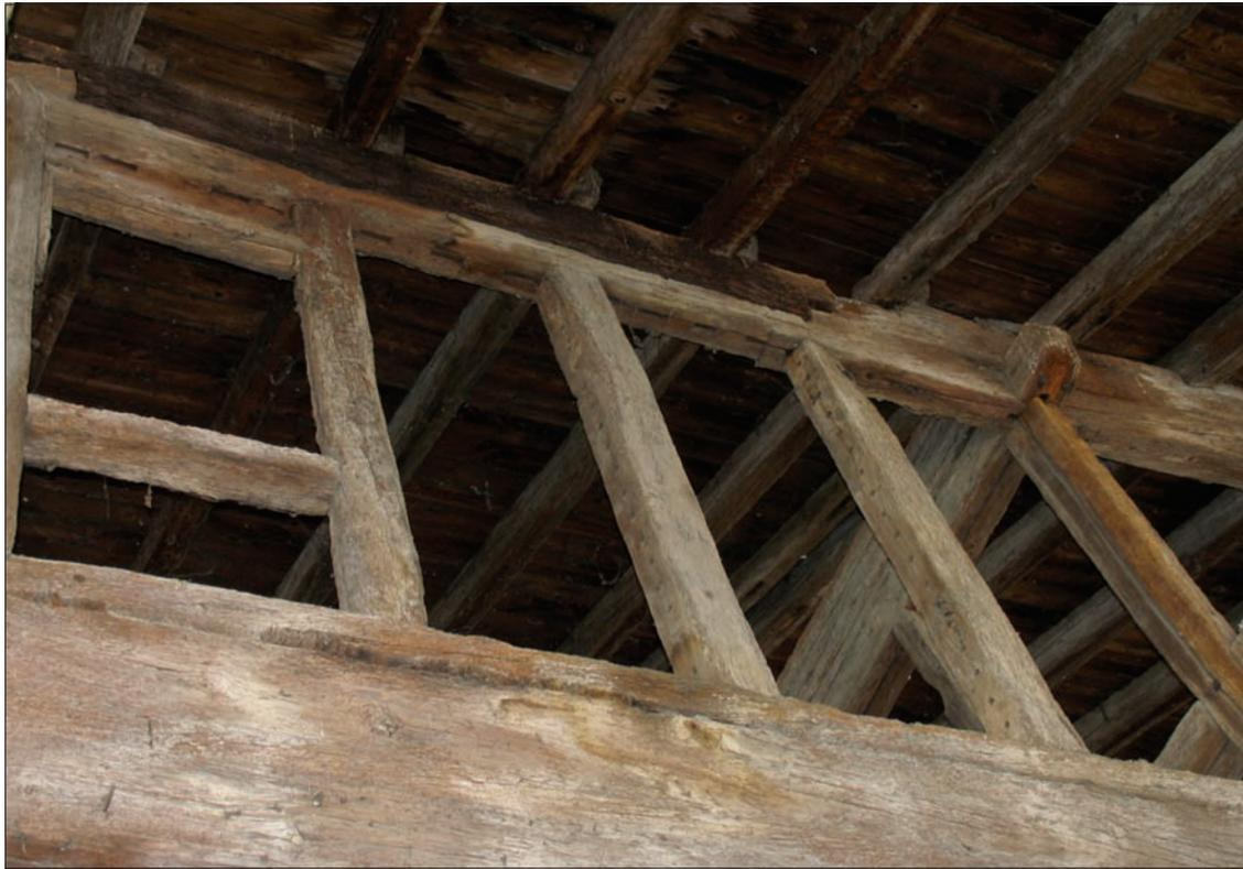
FIG. 35. HALLE DE GRENADE-SUR-GARONNE (HAUTE-GARONNE) : détail de l'ossature de la Maison Commune et traces d'éclisses sur les poteaux. *Cliché A.-L. Napoléone.*
