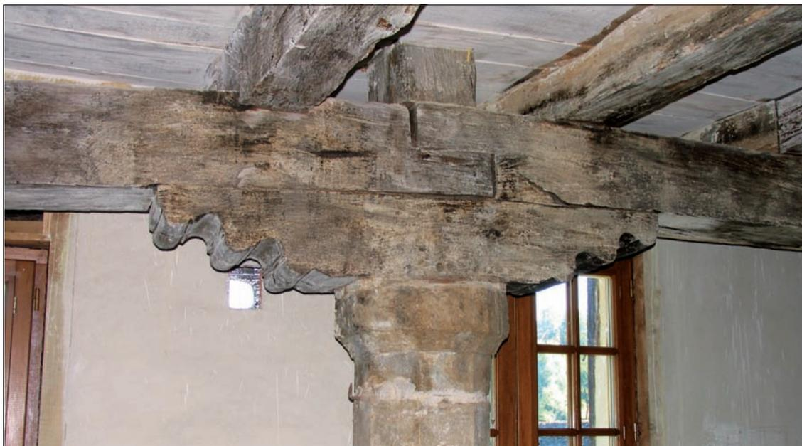
FIG. 36. MAISON DE CALMONT-DU-PLANCAT, PRÈS DE RODEZ (AVEYRON), détail de deux poutres assemblées à mi-bois sur une pile intermédiaire au premier étage. *Cliché M. Scellès.*
