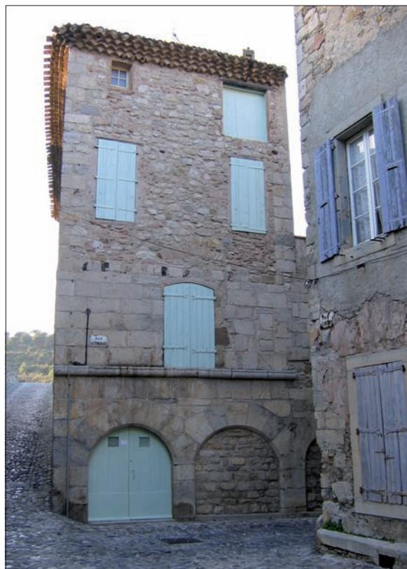
FIG. 12. MAISON DE LA RUE DES TINERIES À LAGRASSE (AUDE), vue de l'élévation principale. Pan de bois non porteur restitué au-dessus du premier étage. Cliché A.-L. Napoléone.
