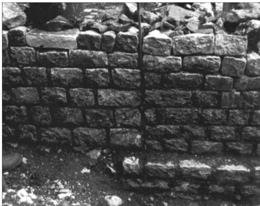
FIG. 7. TEMPLE GALLO-ROMAIN DE BELBÈZE-PÉDÉGAS D'EN HAUT. Le mur extérieur (côté nord) en petit appareil soigné, la reprise est à la limite séparative des deux cellae . Cliché Michel Labrousse.
