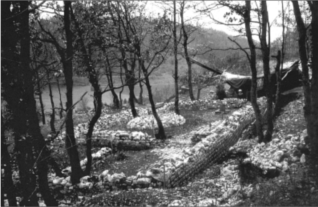
FIG. 4. VUE DU TEMPLE APRÈS LES FOUILLES DE 1965 (FÉV. 1966).
