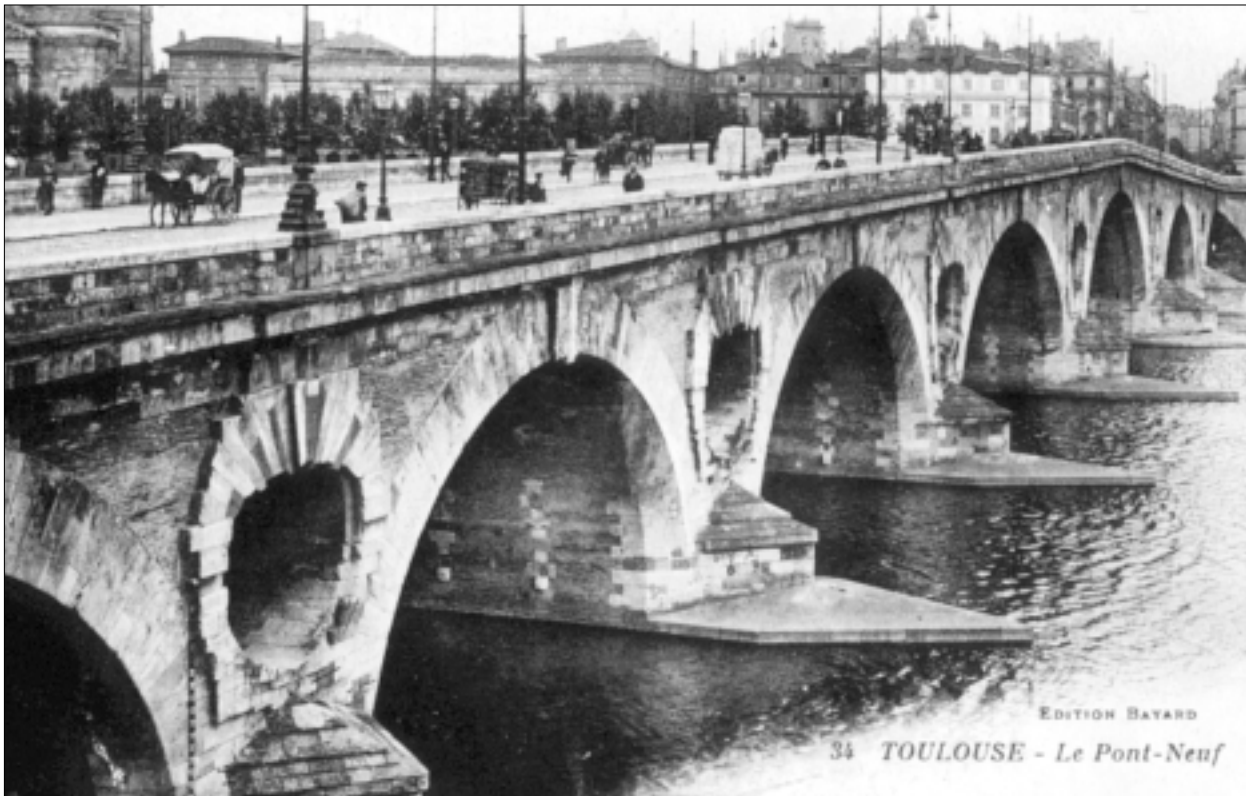
FIG. 3. LE PONT NEUF DE TOULOUSE (face amont). On notera les ouïes dont les pierres sont restées simplement épannelées, les piles avec leurs avant-becs superposés, et le délardement des arches en cornes de vache pour faciliter l'écoulement des eaux.
