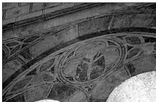
FIG. 18. NEF. Vaisseau central. Baie géminée des tribunes. Faux remplages gothiques.
