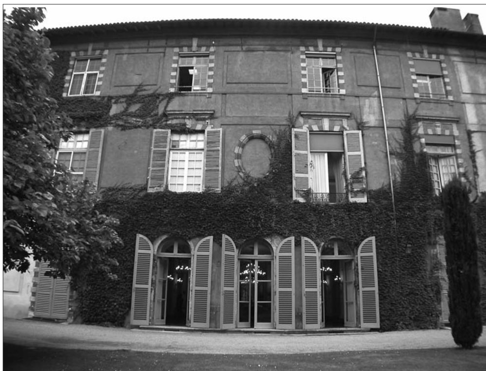
FIG. 11. DÉTAIL DE LA FAÇADE SUR JARDIN de l'aile gauche. Cliché A.M. Toulouse, L.-E. Friquart, L. Krispin.
