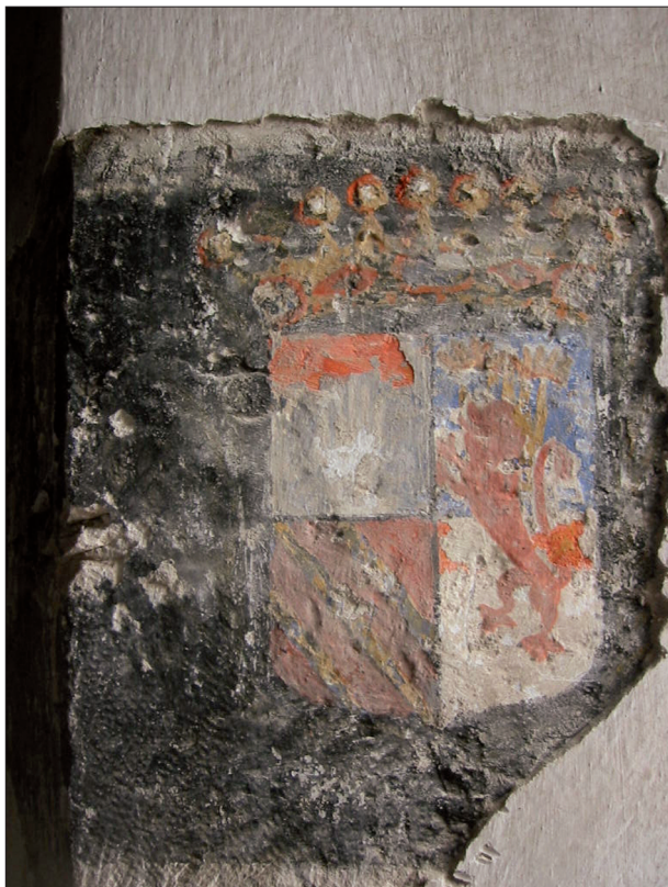
FIG. 12. GLUGES, ÉLEVATION INTÉRIEURE SUD DE LA NEF, LITRE AUX ARMES DES MAYNARD-LESTRADE. Cliché Valérie Rousset, 2007.
