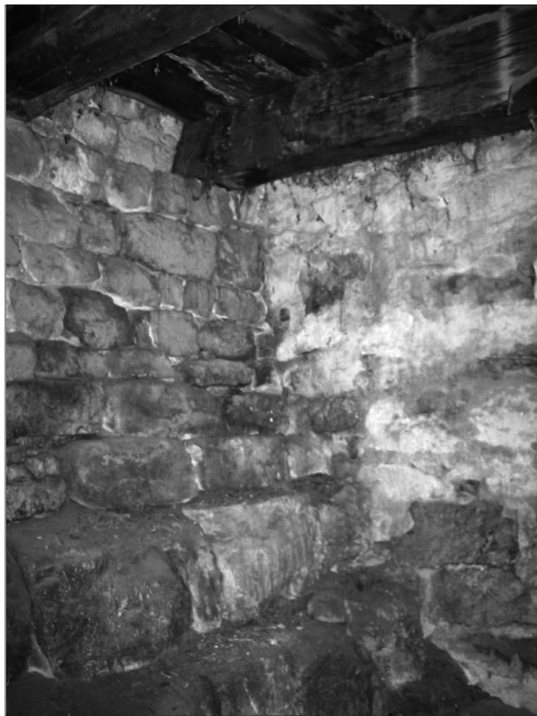
FIG. 17. GLUGES, PRESBYTÈRE, MUR M1, PAREMENT EXTÉRIEUR SUR LEQUEL EST ADOSSÉ LE MUR EST (XVI e - XVI e siècles) DU PRESBYTÈRE. Cliché Valérie Rousset, 2007.
