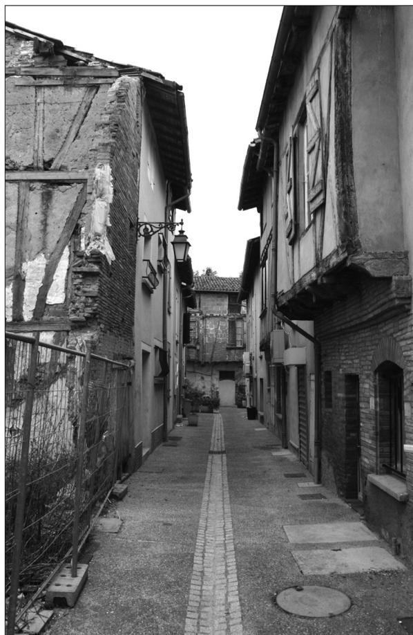
FIG. 20. FRONTON (HAUTE-GARONNE). Vue de la ruelle de l'extension (1371). On remarque de part et d'autres les étages de maisons, constitués d'un colombage-torchis. Cliché: Frédéric Loppe, 2008.
