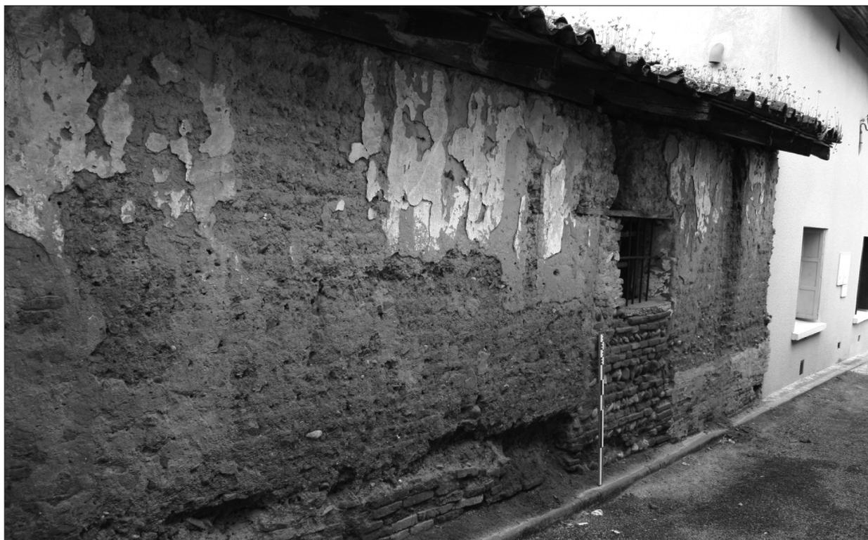
FIG. 19. CASTELGINEST (HAUTE-GARONNE). Vue générale du mur de terre crue massive M1, à l'intérieur du fort.
