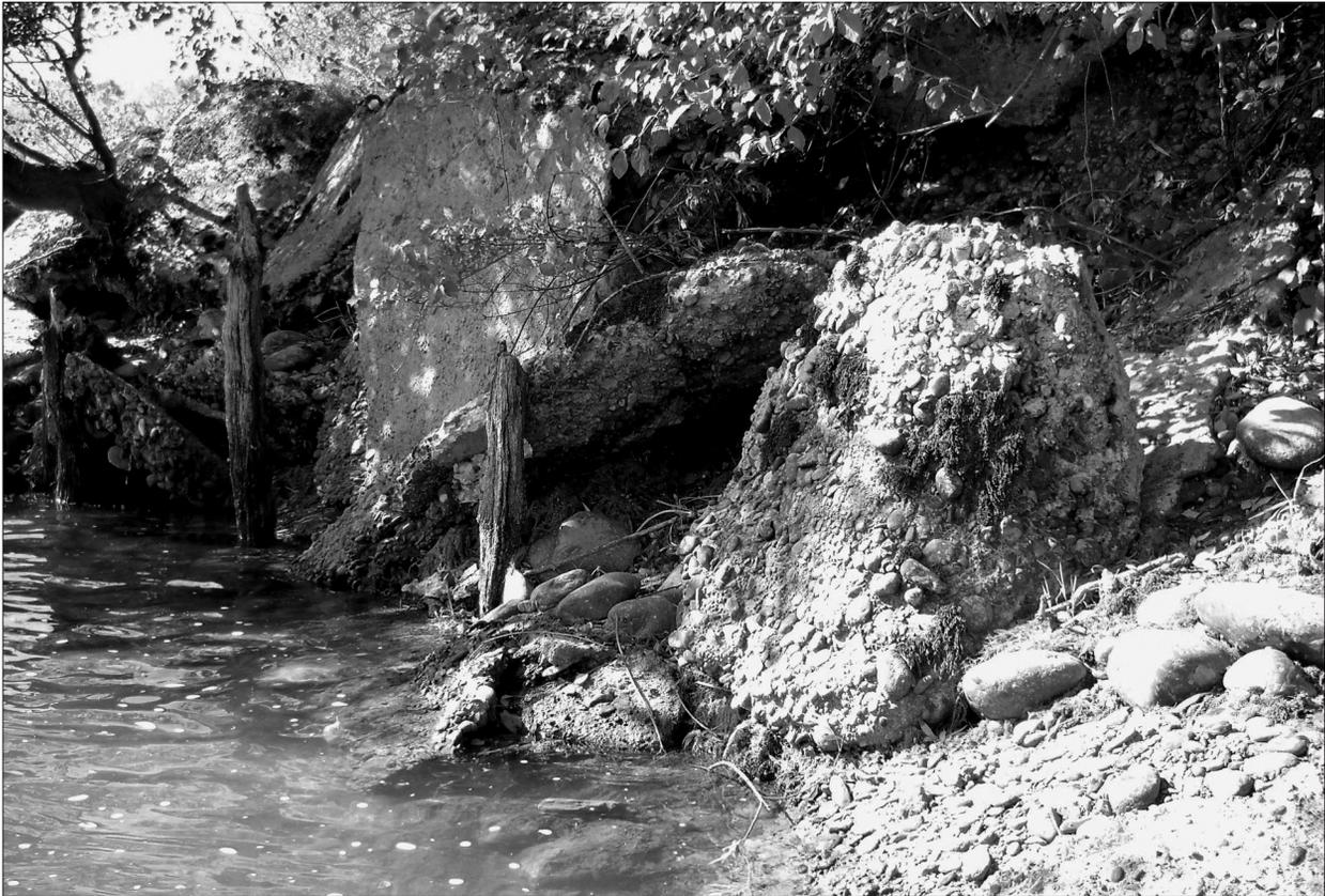
FIG. 19. MARQUEFAVE. Pieux et blocs de béton effondrés.
