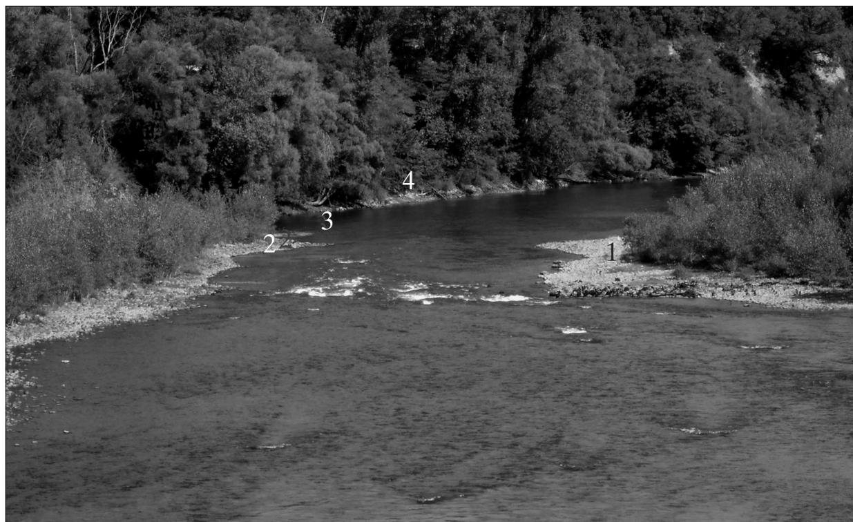
FIG. 5. MARQUEFAVE. DIGUE-BARRAGE DU MOULIN DE SAINT-HYPPOLITE. 1, 2 et 4. Vestiges de la digue-barrage; 3. Débouché du « renard ». Cliché J.-P. Claria.
