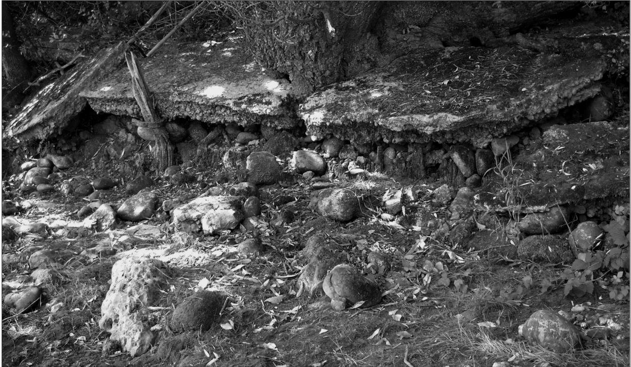
FIG. 17. MARQUEFAVE. Couche de béton traversée par un arbre et surmontant une rangée de planches.
