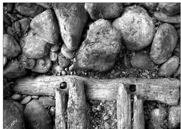
FIG. 13. MARQUEFAVE. DIGUE-BARRAGE DU MOULIN DE SAINT-HYPPOLITE. Mortaise, pieu P 151 et entretoise. *Cliché M.-T. Tinet-Lassure.*
