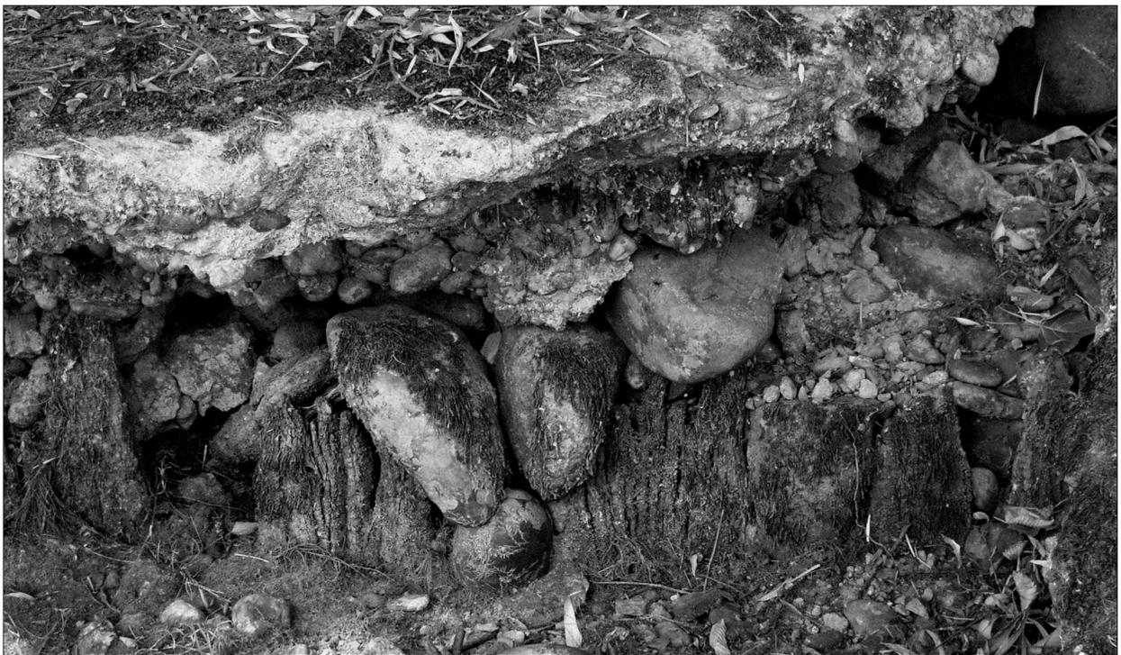
FIG. 18. MARQUEFAVE. Couche de béton surmontant une rangée de planches.
