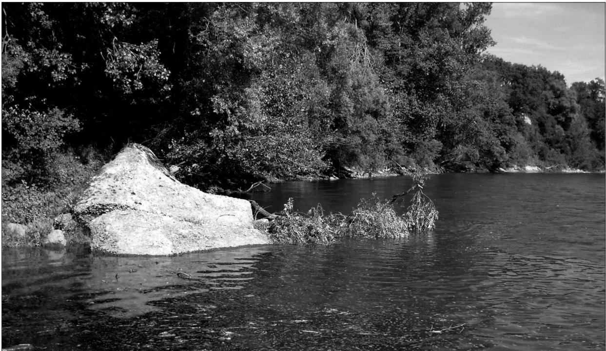
FIG. 16. MARQUEFAVE. Plaques de béton effondrées à la sortie du « renard », côté Nord. *Cliché J.-M. Lassure.*
