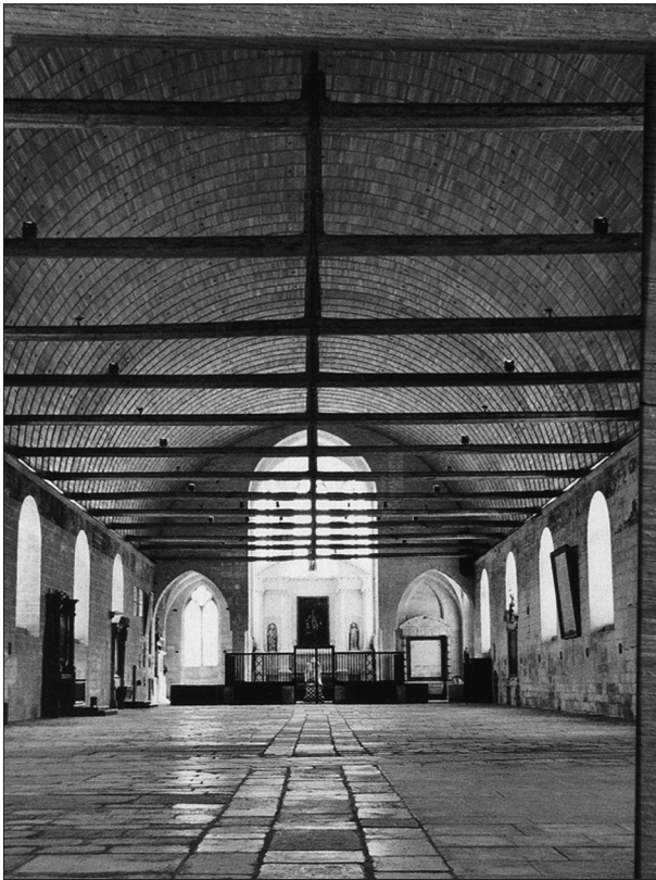
FIG. 9. TONNERRE (YONNE), grande salle des malades (à voûte en carène) de l'ancien hôpital (1295).
