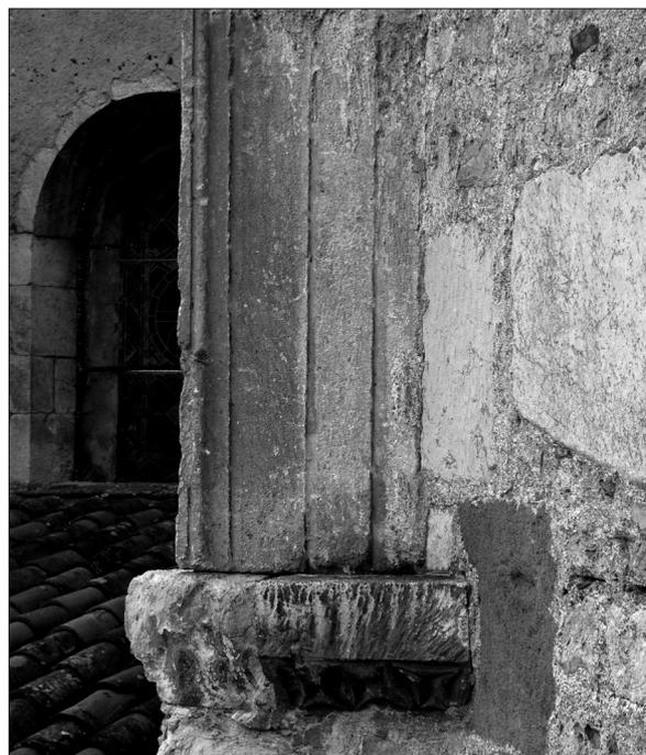
FIG. 5. VUE DU FRAGMENT D'ARCHITRAVE en remploi dans la maçonnerie de l'église basse. Cliché Catherine Viers.
