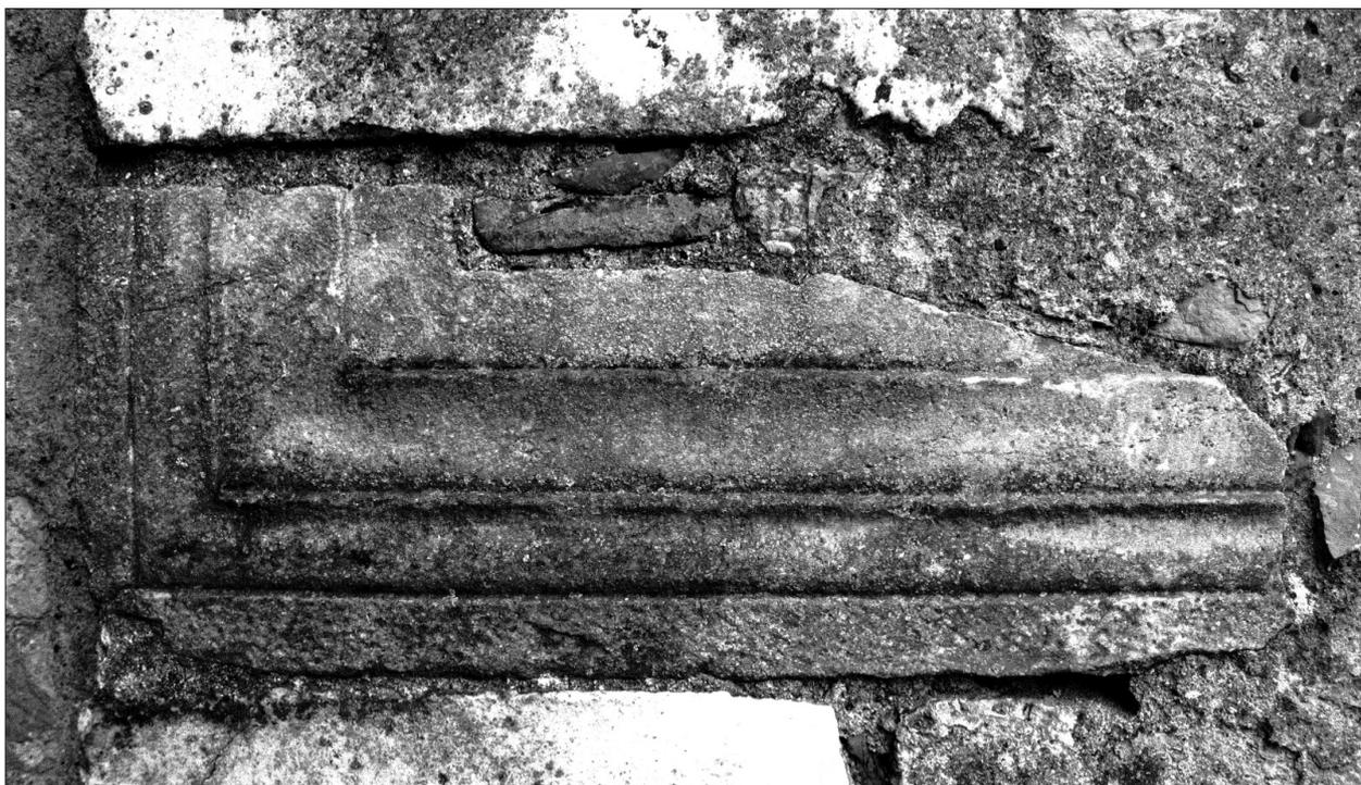
FIG. 4. VUE DU FRAGMENT DE CHAMBRANLE. Celui-ci est en remploi dans un chaînage de Notre-Dame-de-la-Sède. Cliché Catherine Viers.
