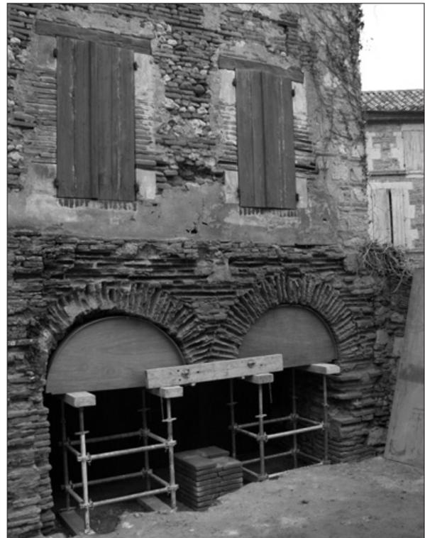
FIG. 8. MAISON DE LA RUE DES NOBLES, élévation ouest : détail des deux arcs du rez-de-chaussée (en cours de restauration).
