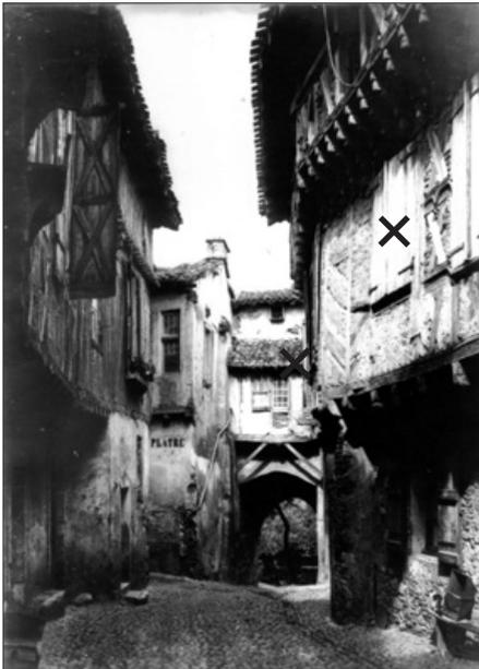
FIG. 5. AUVILLAR : VUE DE LA RUE DES NOBLES, depuis l'est, avant 1922 : au fond, la porte de la Fontaine ; contre elle, à gauche, et de part et d'autre de la rue, maisons médiévales en pans de bois. Seule celle marquée X et sa voisine (masquée) subsistent.
