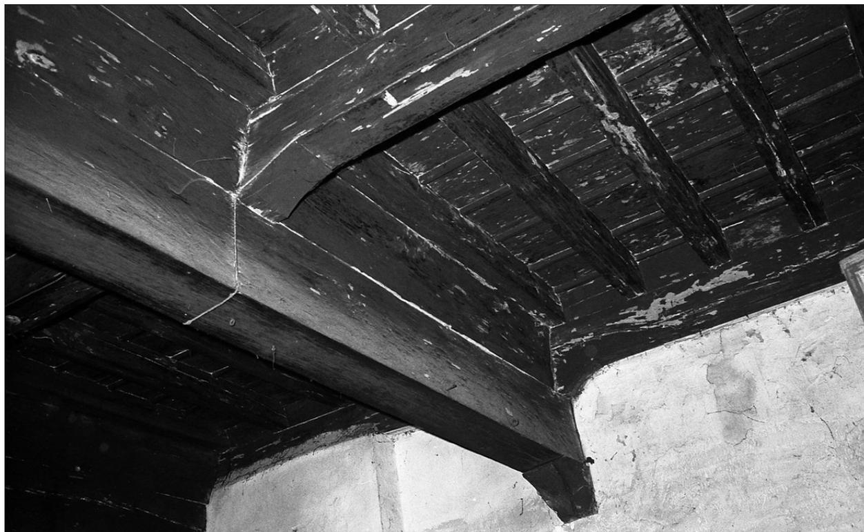
FIG. 17. FIGEAC, HÔTEL DE L'IMPASSE DE LA MONNAIE : détail du plafond de la salle porté sur deux niveaux de poutres. *Cliché Gilles Séraphin.*
