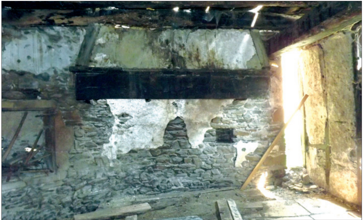
FIG. 21. CHEMINÉE aménagée dans le mur est de la salle. Cliché M. Scellès.
