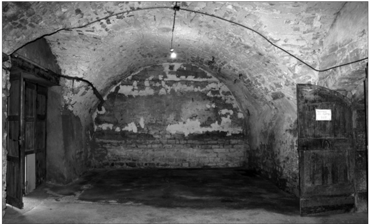
FIG. 9. VUE INTÉRIEURE DE LA SALLE DU REZ-DE-CHAUSSÉE DU CORPS DE BÂTIMENT (D). Cliché Françoise Galés.
