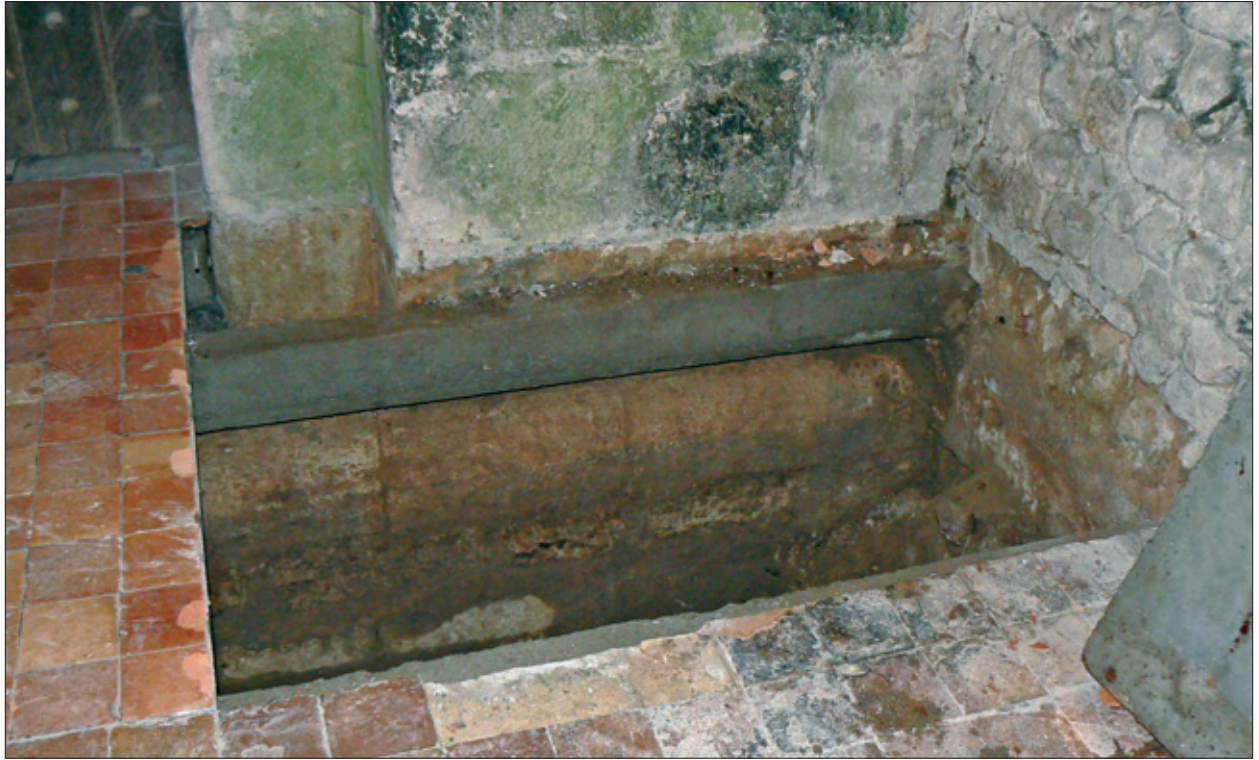
FIG. 13. VUE DU SONDAGE AVEC LA FONDATION DE LA TOUR-PORCHE (le ressaut est masqué par la poutrelle en béton réalisée dans les années 70 pour porter le carrelage refait). Cliché Q. Cazes.
