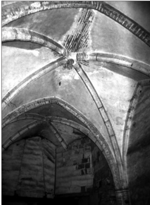
FIG. 6. SACRISTIE, QUATRIÈME TRAVÉE vers l'est, état vers 1992. Cliché Henri Pradalier.
