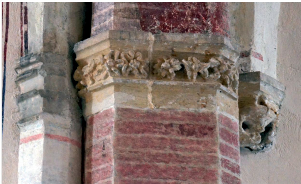
FIG. 33. SACRISTIE, IMPOSTE NORD DE LA QUATRIÈME TRAVÉE. Cliché Guy Ahlsell de Toulza.
