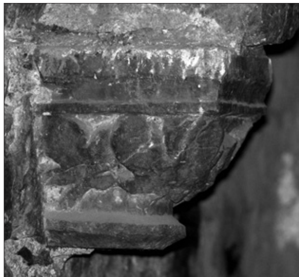
FIG. 20. VUE DE DÉTAIL DU CHAPITEAU, DE LA CHEMINÉE. Cliché Françoise Galés.
