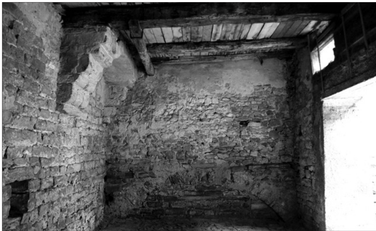
FIG. 21. VUE INTÉRIEURE DU REZ-DE-CHAUSSÉE ORIENTAL DE L'ÉTAGE DU CORPS ARRIÈRE. Cliché Françoise Galès.
