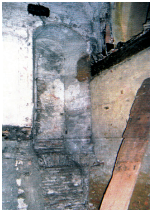
FIG. 26. SACRISTIE, TROISIÈME TRAVÉE mur nord, fenêtre et porte, état 1996. Dossier Belin.
