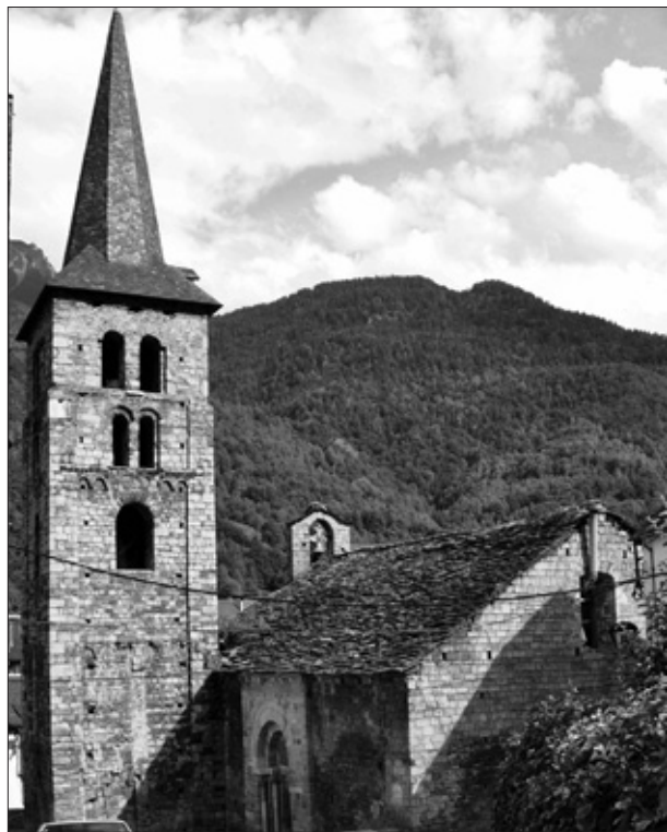
FIG. 7. BOSSÒST. Vue générale de la tour-clocher. Cliché E. Garland.
