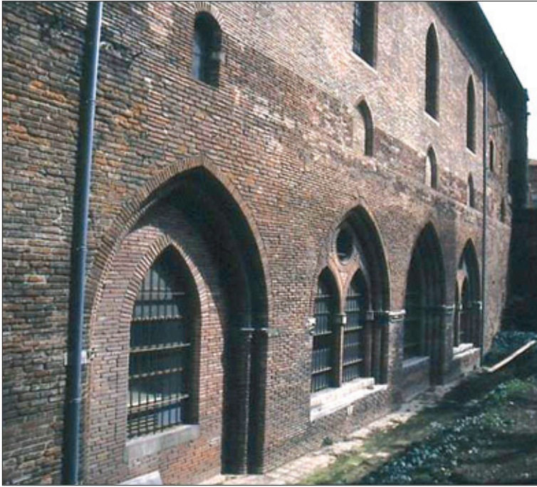
FIG. 17. RÉFECTOIRE, FAÇADE OUEST, état vers 1992, avec les petites fenêtres qui éclairaient la salle capitulaire au dessus de la toiture du cloître. Cliché Henri Pradalier.
