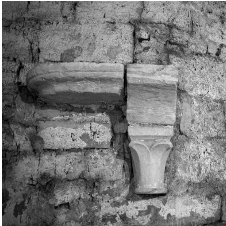
FIG. 15. VUE DE DÉTAIL DU CHAPITEAU, DE LA TABLETTE ET DU CORBEAU DE LA CHEMINÉE. Cliché Françoise Galés.
