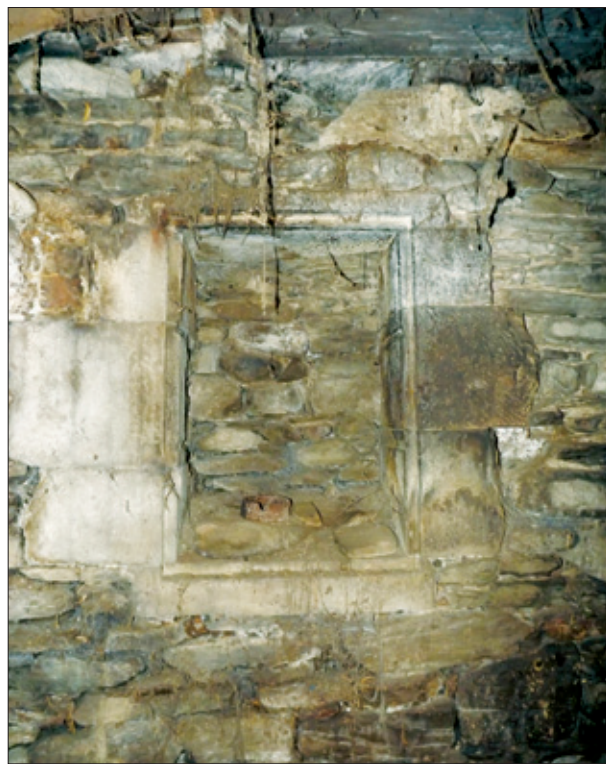
FIG. 11. PLACARD aménagé dans le mur est du rez-de-chaussée. Cliché R. Chabbert.
