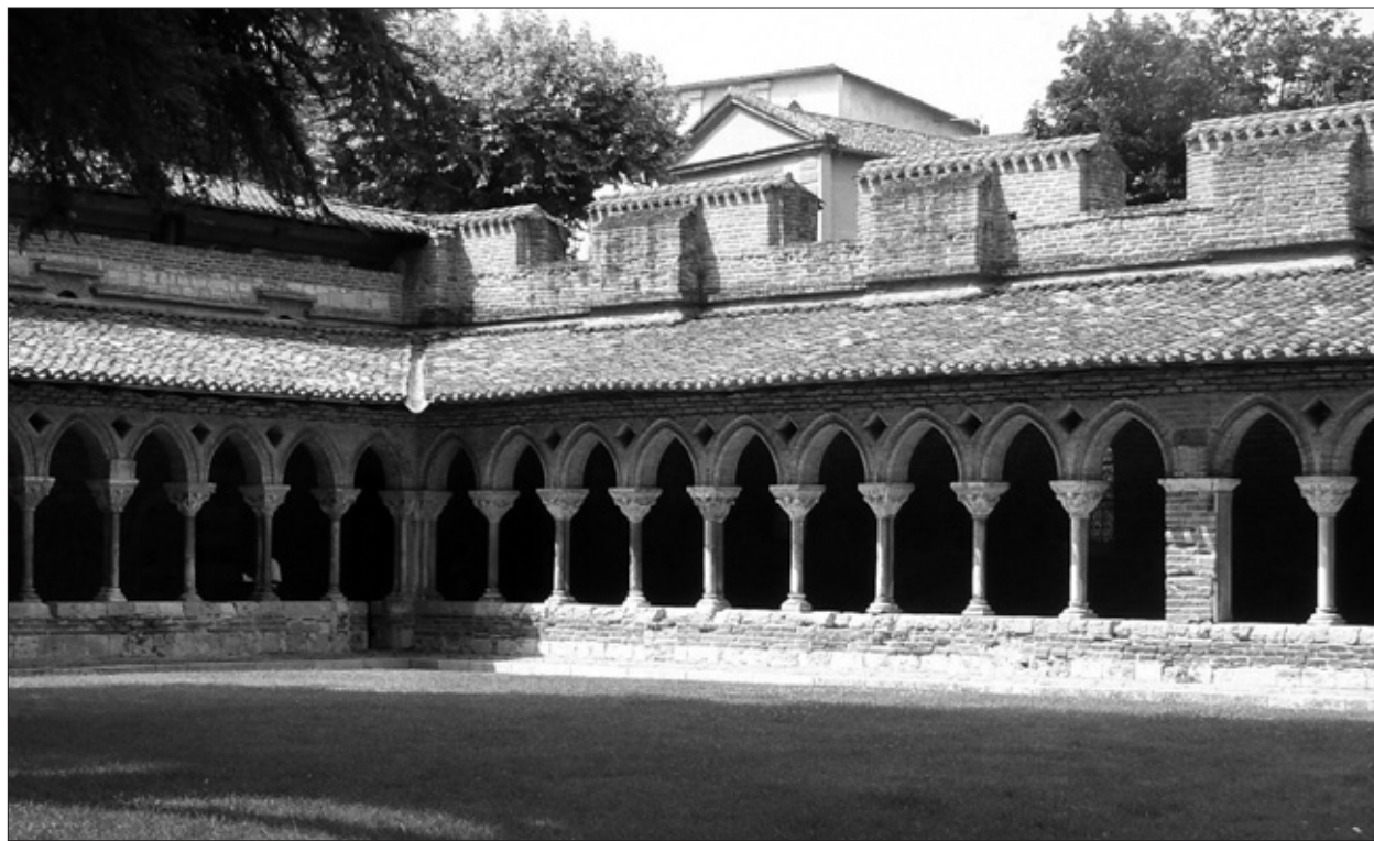
FIG. 3. ARRACHEMENTS DE L'ARCATURE DE LA GALERIE DE LA FONTAINE : à droite, au revers du pilier médian de la galerie nord ; à gauche, au-dessus de la quatrième colonne de la galerie ouest. Cliché Q. Cazes.
