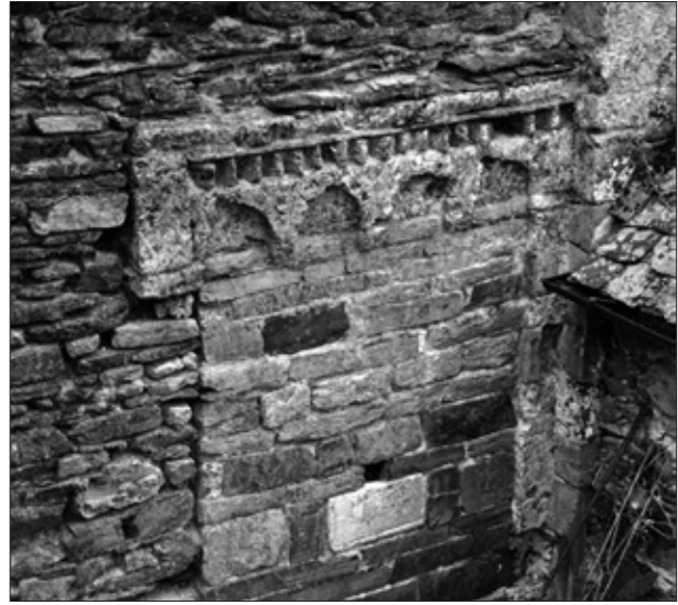
FIG. 4. DÉTAIL DE L'APPAREIL de l'église de Sant Roc de Begòs (mur nord), Cliché E. Garland.
