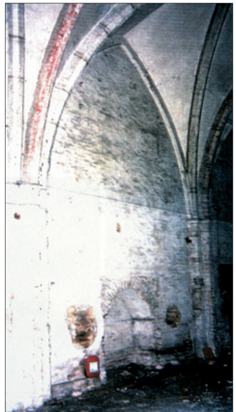
FIG. 20. SACRISTIE, DEUXIÈME TRAVÉE mur nord, niche, état 1996. Dossier Belin.
