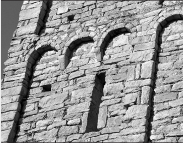
FIG.24. TOUR DE LA CHAPELLE CASTRALE DE LLORDA, détail du décor d'arcature. Cliché E. Garland.
