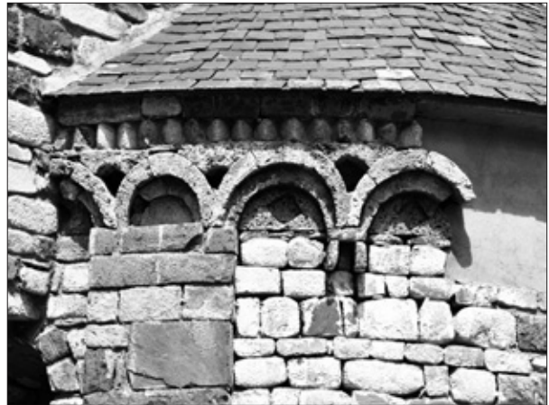
FIG. 9. MIJARAN. Détail de l'abside centrale. Cliché E. Garland.
