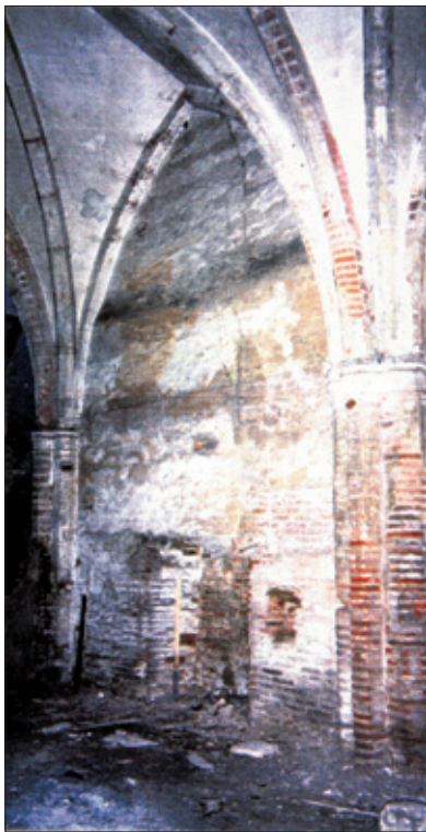
FIG. 22. SACRISTIE, DEUXIÈME TRAVÉE mur sud, placard, état 1996. Dossier Belin.
