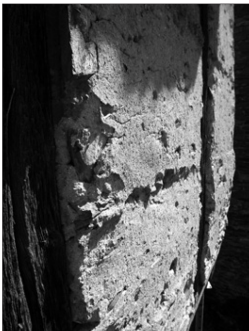
FIG. 6. HOURDIS du second étage et traces du coffrage de planches. Cliché M. Scellès.
