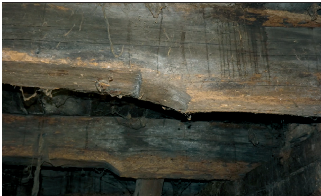
FIG. 12. SOLIVES DU REZ-DE-CHAUSSÉE : épaissement formant corbeau. Cliché R. Chabbert
