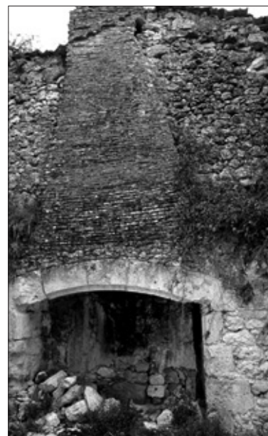
FIG. 10. CHEMINÉE de la pièce 1-2. Cliché Ch. Darles.
