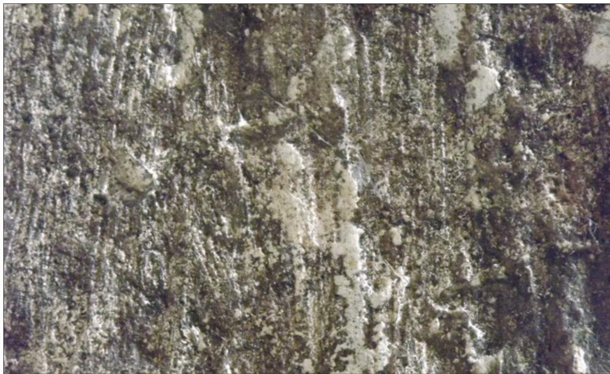
FIG. 24. ENDUIT RECOUVRANT LES PANS DE BOIS à l'intérieur de la salle appliqué à la brosse : détail. Cliché M. Scellès.
