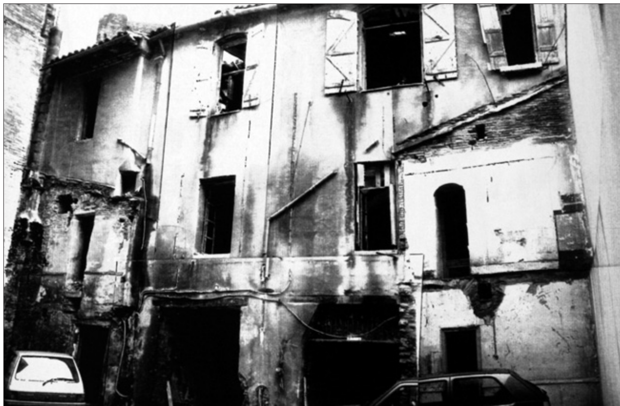
FIG. 4. COUR INTÉRIEURE du 13 rue des Lois, façade est de la sacristie, état 1996. Dossier Belin.
