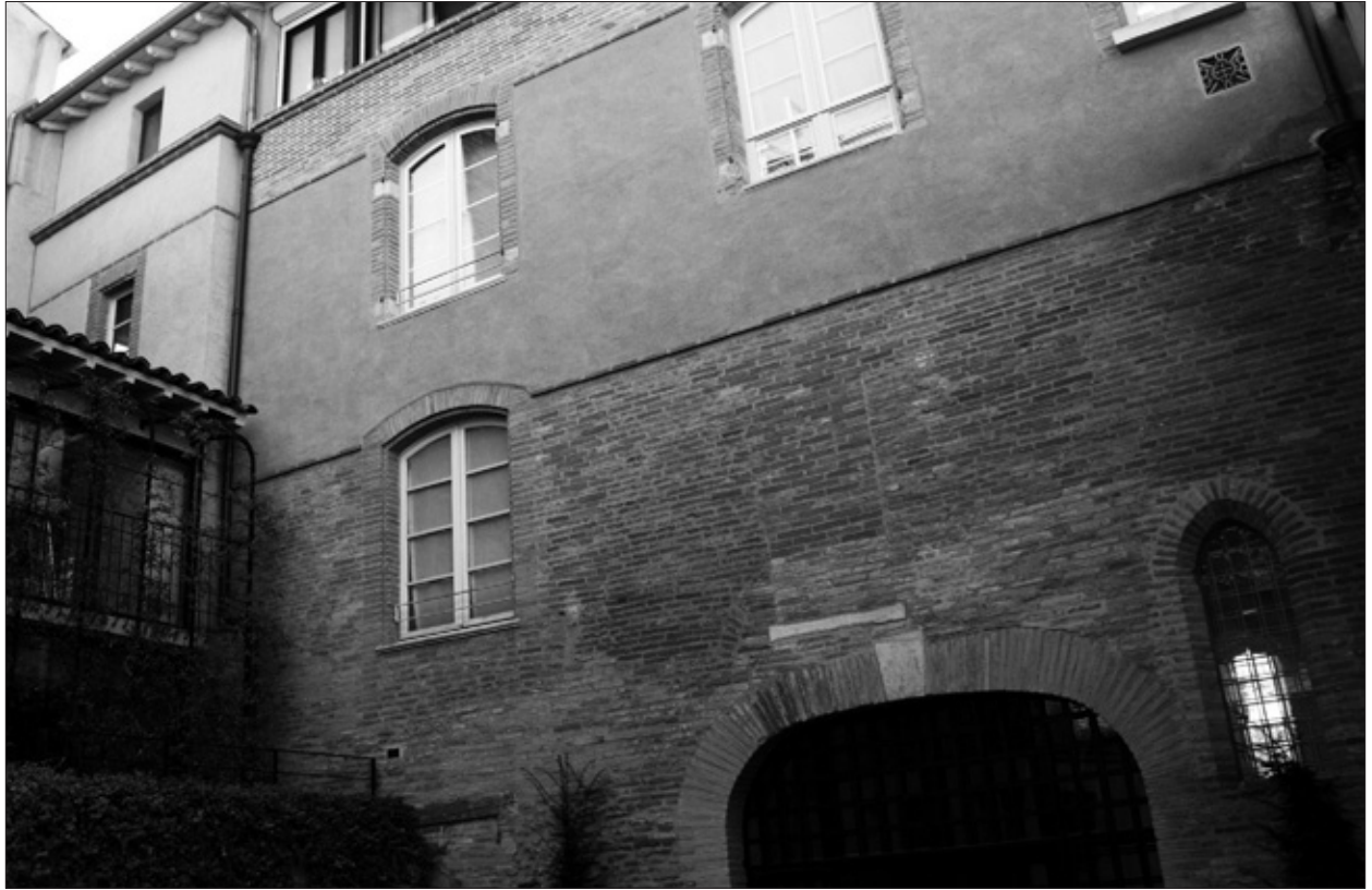
FIG. 5. COUR INTÉRIEURE du 13, rue des Lois, façade est de la sacristie, état 2011. Cliché Guy Ahlsell de Toulza.
