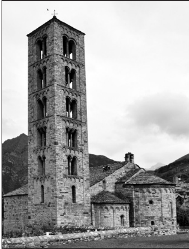
FIG. 22. SAINT-CLÉMENT DE TAÜLL, vue générale. Cliché E. Garland.
