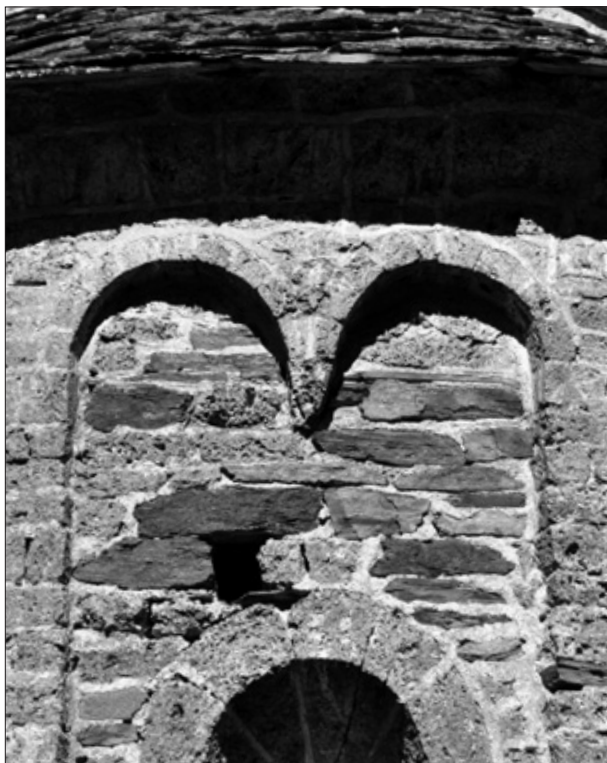
FIG. 26. EL BURGAL, détail de l'abside centrale. Cliché E. Garland.
