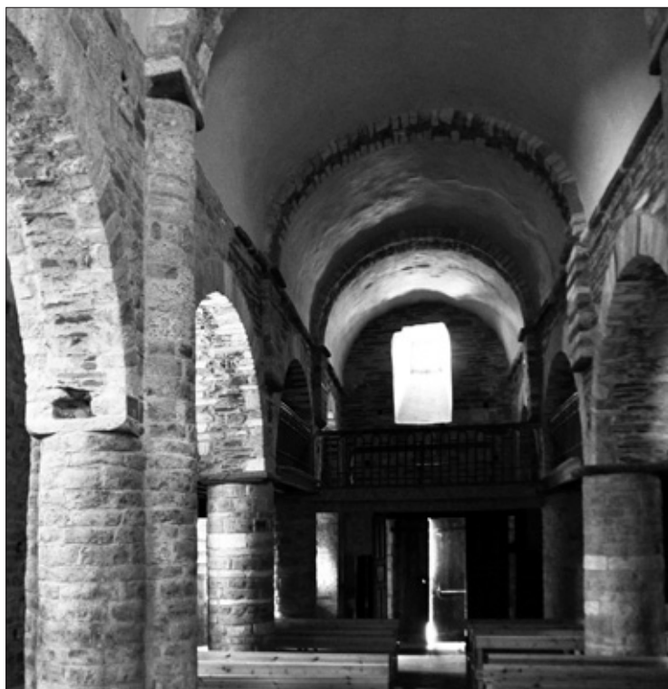
FIG. 17. SANTA MARIA DE VILAMÒS. Vue générale de l'intérieur. Cliché E. Garland.
