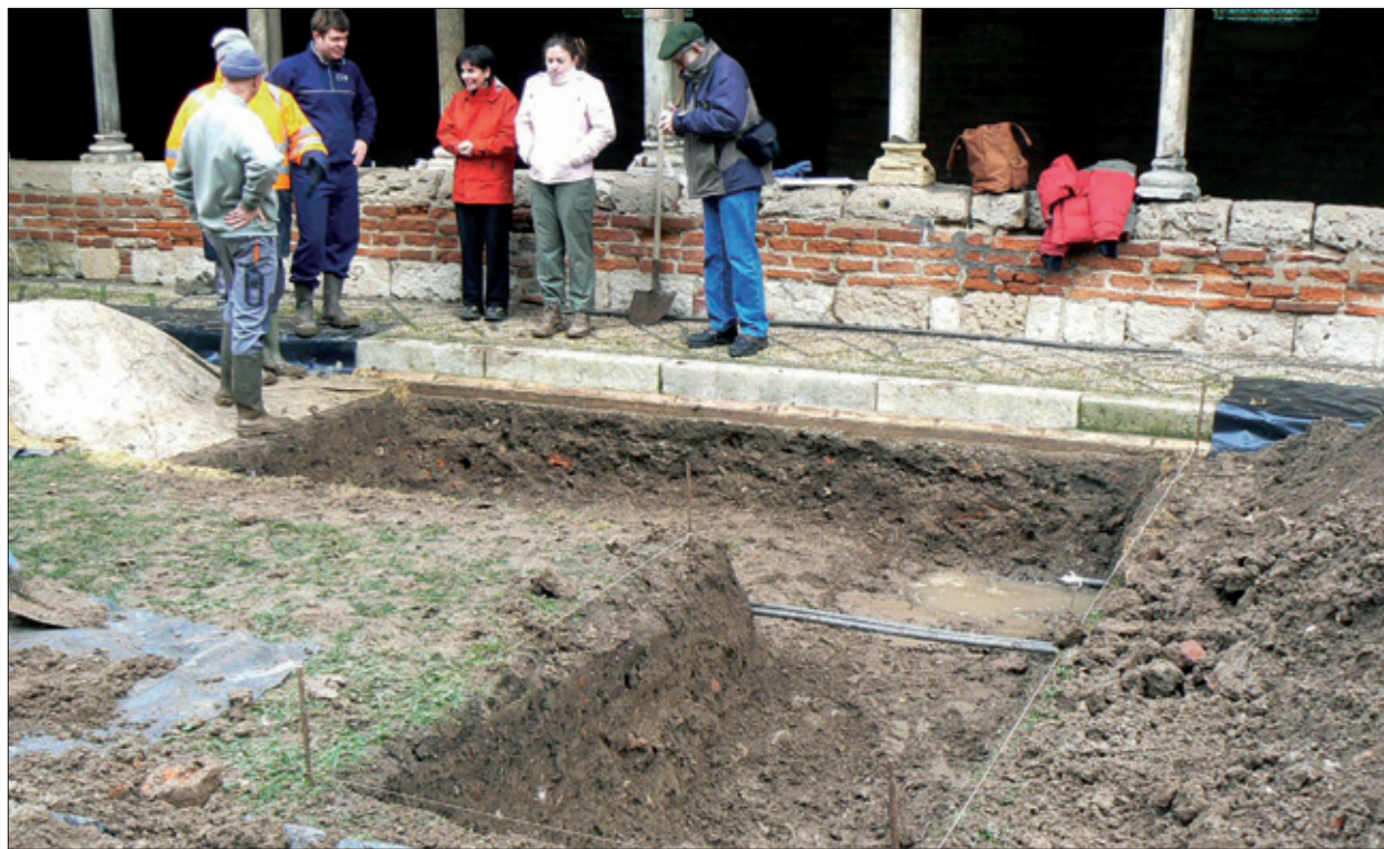
FIG. 9. VUE DE FIN DE FOUILLE à l'emplacement de la fontaine, avec la nappe phréatique et juste avant la pluie... Cliché Q. Cazes.
