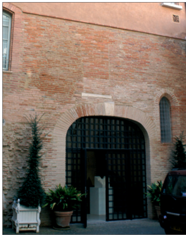
FIG. 29. SACRISTIE, QUATRIÈME TRAVÉE, façade est sur cour, état 2011. Cliché Guy Ahlsell de Toulza.
