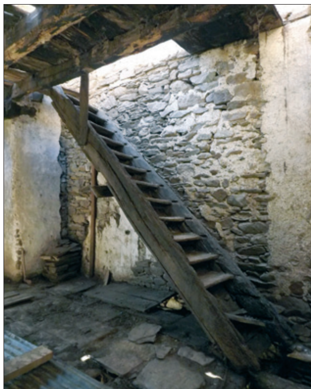
FIG. 25. ESCALIER appuyé sur le mur ouest de la salle. Cliché M. Scellès.
