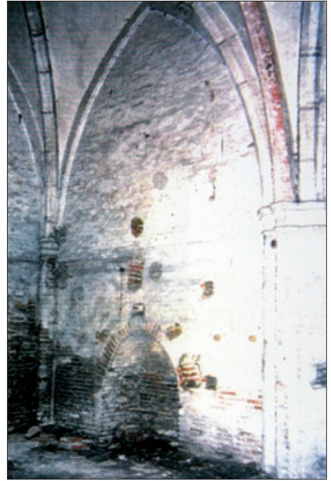
FIG. 18. SACRISTIE, PREMIÈRE TRAVÉE mur nord, niche, état 1996. Dossier Belin.
