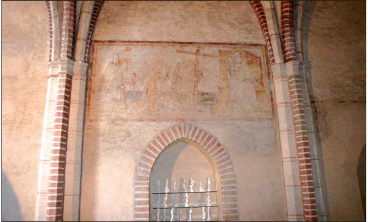
FIG. 21. SACRISTIE, DEUXIÈME TRAVÉE mur nord, niche et peinture de Notre-Dame de la Passion, état 2011. Cliché Guy Ahlsell de Toulza.
