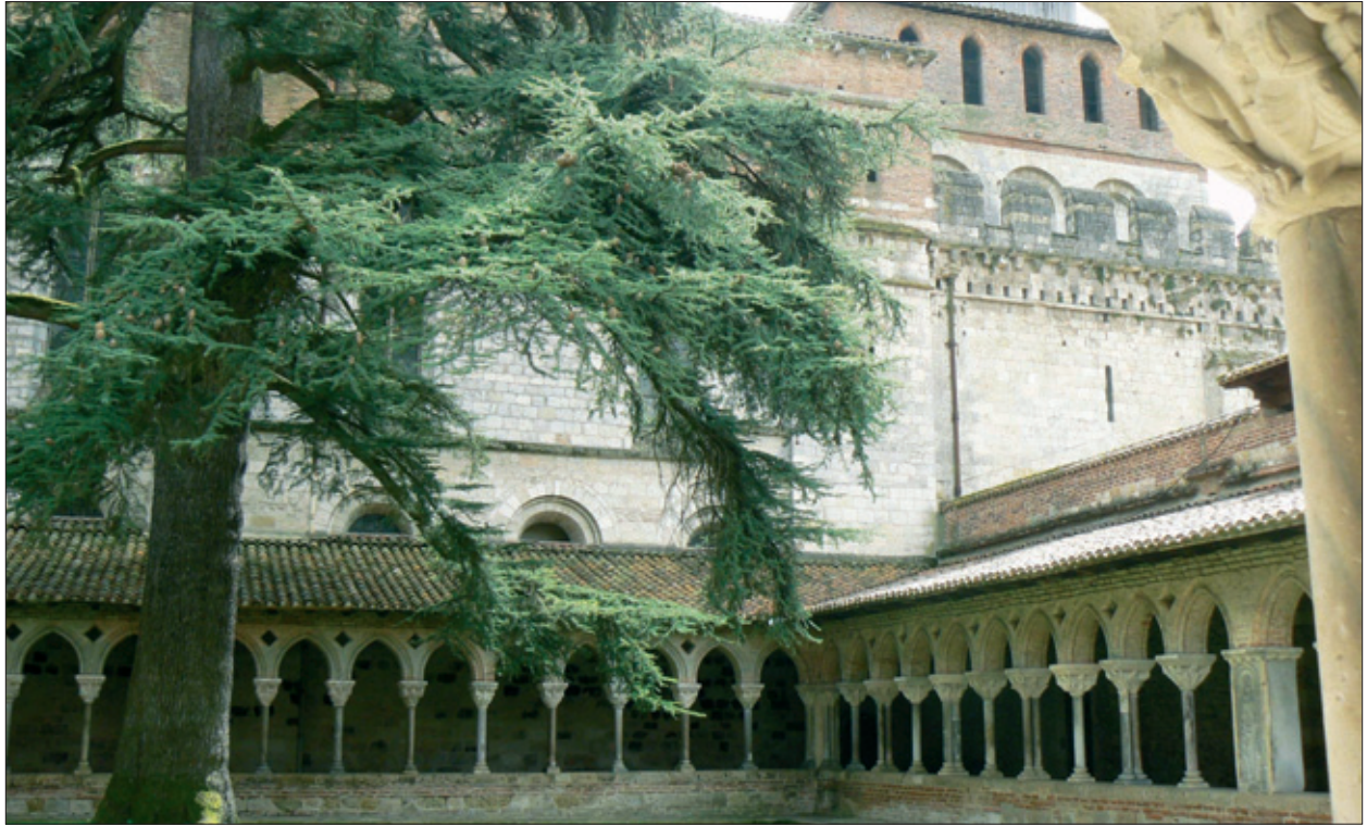
FIG. 10. TOITURE SURÉLEVÉE DE LA GALERIE MÉRIDIONALE DU CLOÎTRE masquant en partie les fenêtres de l'église romane. Cliché Q. Cazes.
