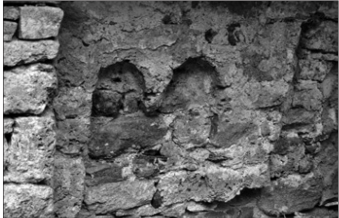
FIG. 12. SANT ESTEVE DE TREDÒS. Détail de l'arcature. Cliché E. Garland.
