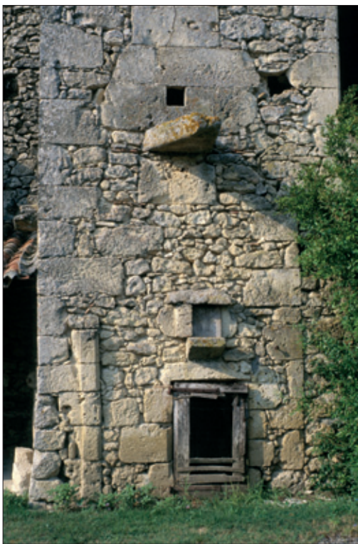
FIG. 14. ÉLÉVATION PARTIELLE DU POULAILLER ET DE LA SOUE, Cliché Ch. Darles
