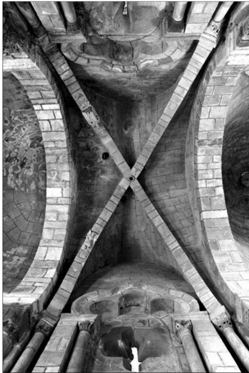
FIG. 15. TRAVÉE DROITE DU CHŒUR, détail de la croisée d'ogives. Cl. N. Blaya.
