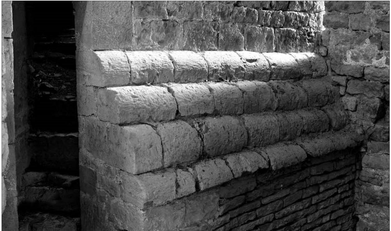
FIG. 24. COMBLES, ÉLEVATION SUD DE LA TRAVÉE DROITE DE CHŒUR, détail des ressauts de quart de rond épaulant la souche du clocher. Cl. N. Blaya.
