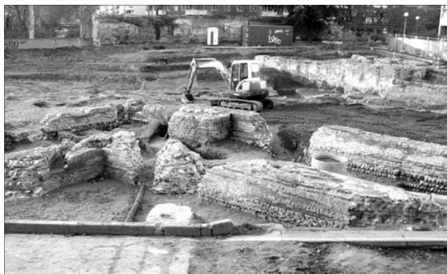
VESTIGES D'UN GRAND BÂTIMENT WISIGOTHIQUE mis au jour sur le site de l'École d'économie de l'Université de Toulouse-I Capitole, avant destruction.
