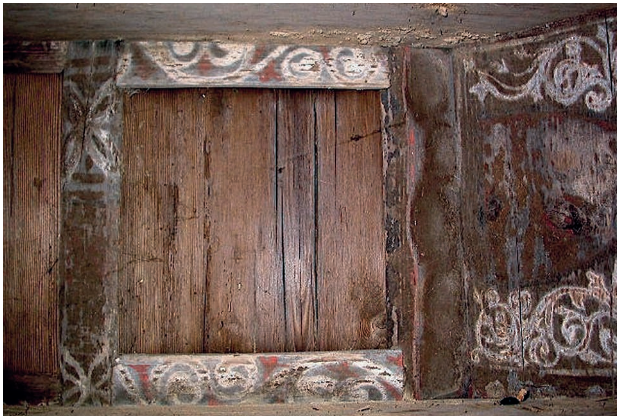
FIG. 8. VUE DE DÉTAIL DU PLAFOND DU VESTIBULE MONTRANT LE PRINCIPE DE RÉPARTITION DES DÉCORS, Cl. J.-L. Rebière.
