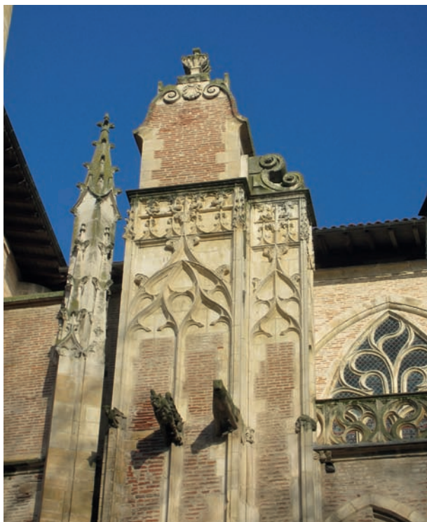
FIG. 18. PARTIE SOMMITALE D'UN CONTREFORT DE L'ÉLEVATION SUD DU CHŒUR, ET SA RICHE ORNEMENTATION. Cl. J.-L. Rebière.
