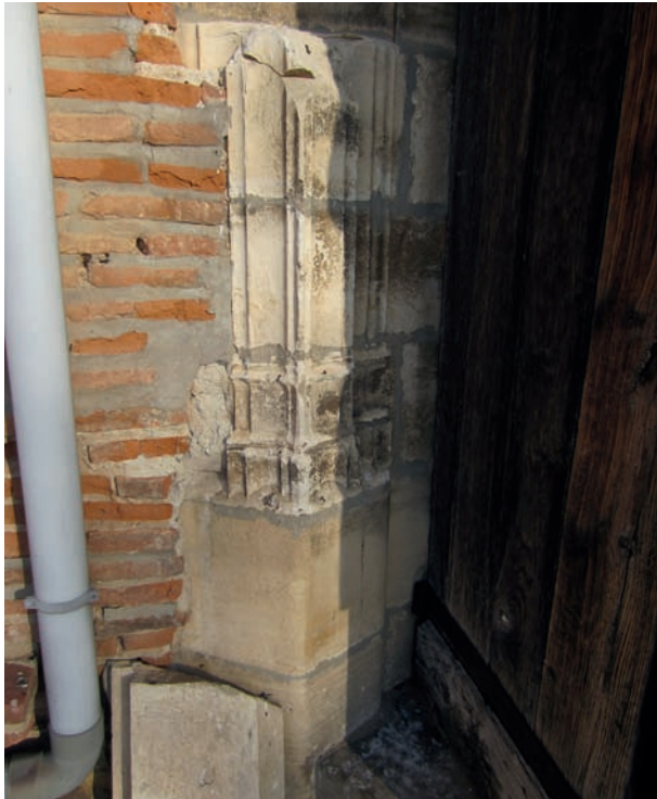
FIG. 26. PIÉDROIT DU TRIFORIUM DE LA TROISIÈME TRAVÉE DU BRAS SUD DU TRANSEPT au débouché de la vis d'Orléans. Cl. J.-L. Rebière.
