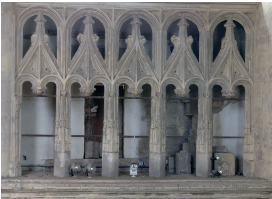
FIG. 17. DÉTAIL DU RÉSEAU DU TRIFORIUM correspondant à l'élévation de la travée sud du chœur édifiée par Jean d'Orléans. Cl. J.-L. Rebière.
