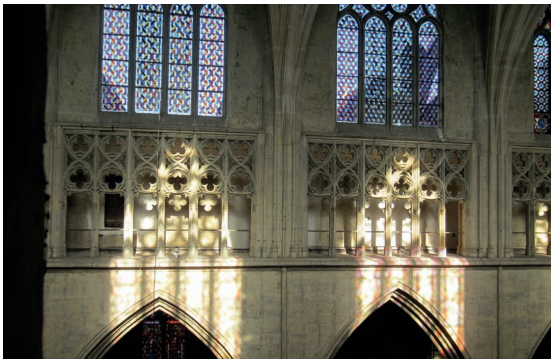
FIG. 6. PILES DU CHŒUR au niveau de la galerie du triforium de l'élévation nord du chœur montrant l'arrêt des modénatures des arcs formerets qui s'interrompent à la naissance du glacis des fenêtres hautes. C'est à ce niveau que fut arrêtée l'élévation du chœur jusqu'à la reprise des travaux de Pierre Levesville. Les entrails de la charpente provisoire du chœur y avaient été établis. Cl. J.-L. Rebière.
