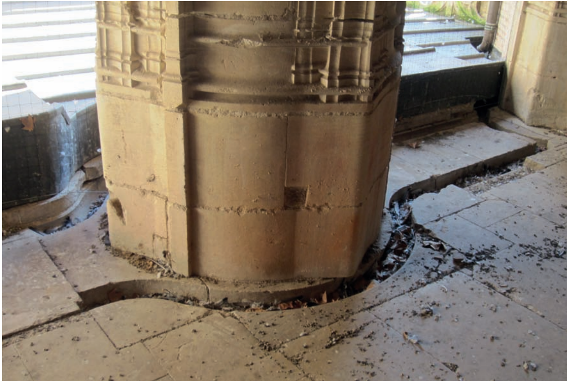
FIG. 19. DALLAGE DE LA PLANÈTE conservé sous l'appentis sud adossé au transept de la cathédrale. Cl. J.-L. Rebière.
