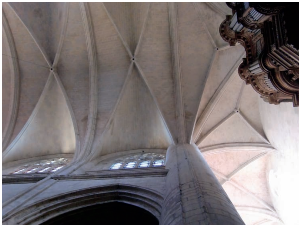
FIG. 12. PILIER D'ORLÉANS, à droite et élévation haute et voûte du chœur, à gauche du cliché. Cl. J.-L. Rebière.
