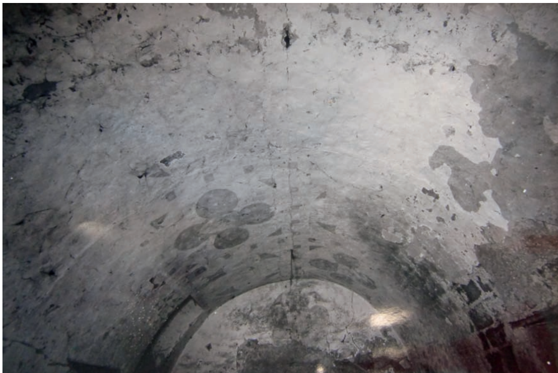
FIG. 2. VUE DE LA VOÛTE DE LA CHAPELLE BASSE de l'abbé Auger avant 1983, date de la destruction des peintures murales qui l'habillent, Cl. M. Durliat.
