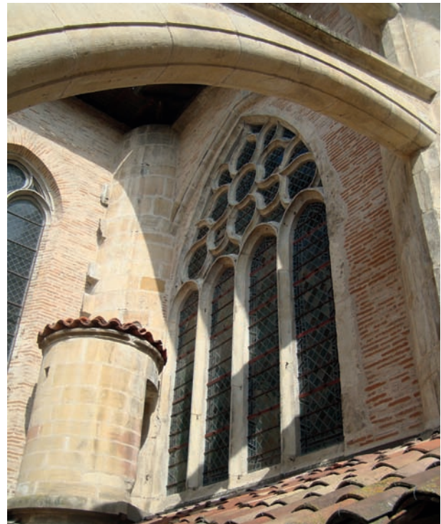
FIG. 21. TOURELLE ADOSSÉE AU PILIER D'ORLÉANS qui devait relier la galerie de triforium du chœur à celle du bras sud du transept. Cl. J.-L. Rebière.
