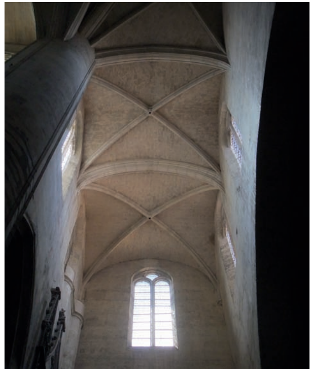
FIG. 29. VOÛTES DU BRAS SUD DU TRANSEPT telles qu'elles ont été réalisées par Pierre Levesville en 1611. Cl. J.-L. Rebière.
