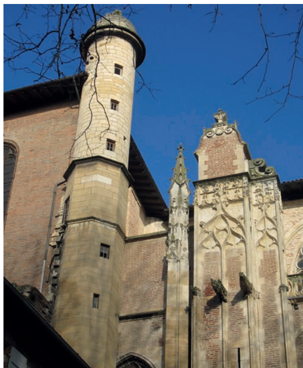
FIG. 24. VUE EXTÉRIEURE D'ENSEMBLE DE LA VIS D'ORLÉANS édifée à l'angle du bras sud du transept. Cl. J.-L. Rebière.
