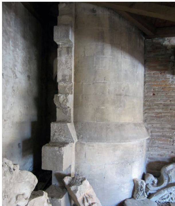
FIG. 22. FÛT DE LA VIS DE LA TOURELLE MONTRANT L'ARRACHEMENT DU MUR EXTÉRIEUR projeté de la galerie du triforium et ressaut en glacis prévu à la base de cette élévation. Cl. J.-L. Rebière.
