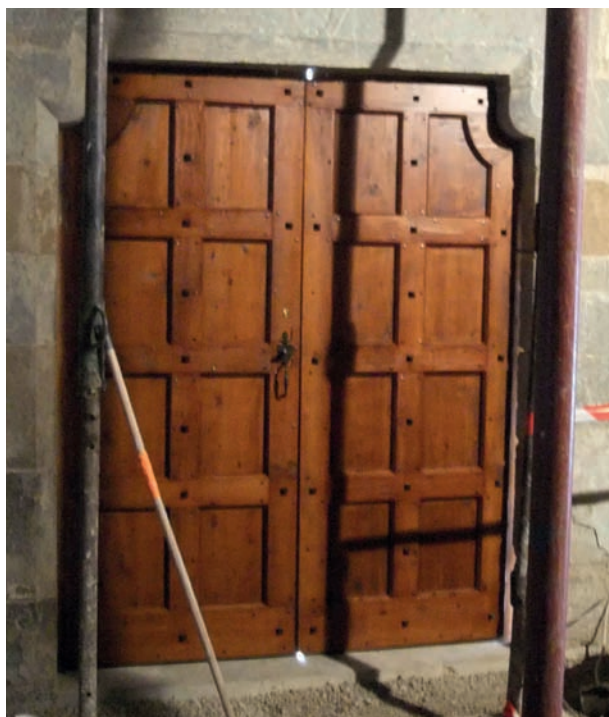
FIG. 20. VUE DE LA PORTE À LINTEAU DROIT du mur ouest du vestibule timbré aux armes de l'abbé qui ouvrait autrefois sur une salle d'apparat aujourd'hui disparue. Cl. J.-L. Rebière.
