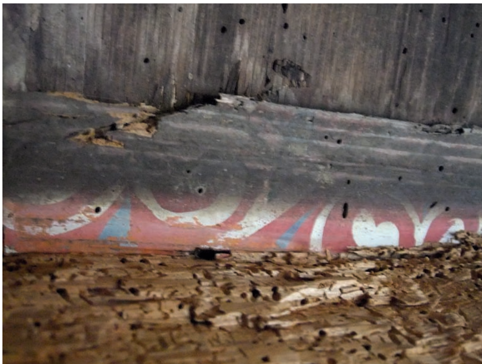
FIG. 11. DÉTAIL D'UN COUVRE-JOINT MONTRANT LA TRICHROMIE DE CE DÉCOR, Cl. J.-L. Rebière .
