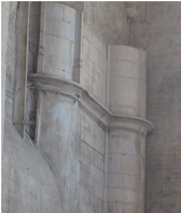
FIG. 28. PIÉDROIT DE LA BAIE HAUTE DE LA DEUXIÈME TRAVÉE DU BRAS SUD DU TRANSEPT et l'amorce de la pile engagée entre la seconde et la troisième travée. Cl. J.-L. Rebière.
