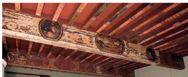
FIG. 9. LECTOURE, HÔTEL DESCAMPS, VUE NORD DU PLAFOND DU SALON SUD-OUEST DE L'ÉTAGE. Cl. P. Poitou, Inventaire général Région Midi-Pyrénées – Ville de Lectoure .
