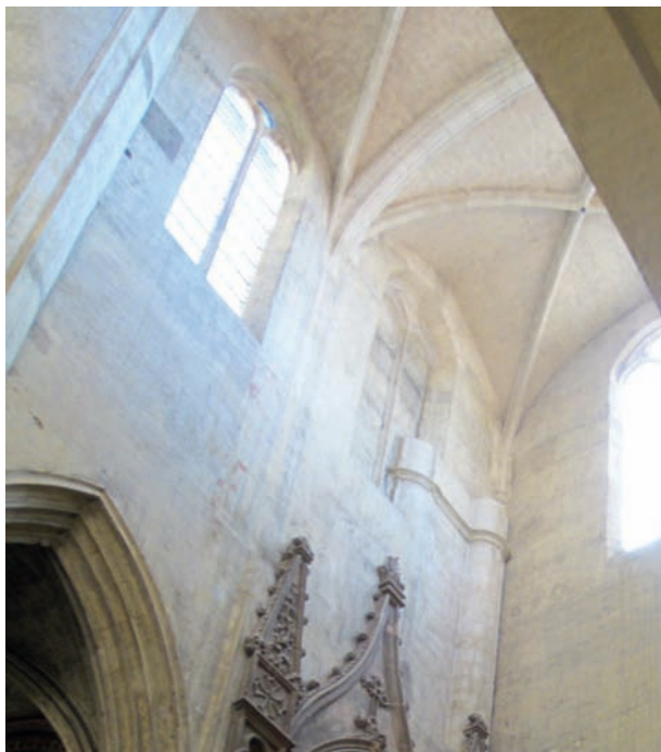
FIG. 13 - VESTIGE DE L'ÉLEVATION SUD DE LA QUATRIÈME TRAVÉE DE LA NEF RAYMONDINE DÉTRUITE. Il est perceptible au-dessus du tableau où l'on distingue un renflement de la maçonnerie souligné par un dépôt de poussière sur la saillie de la maçonnerie. Cl. J.-L. Rebière.
