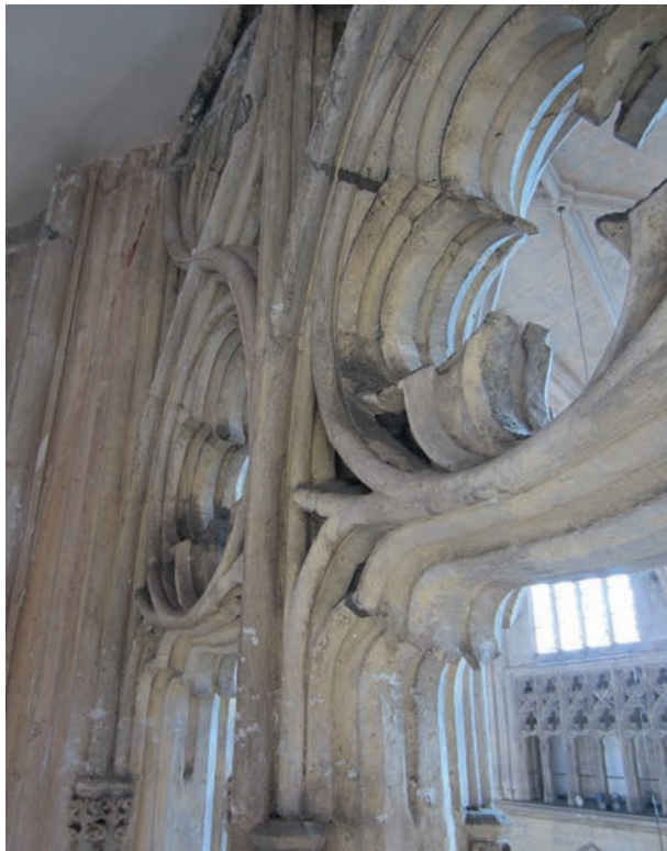
FIG. 2. DÉTAIL DES FEUILLURES PRÉSENTES SUR LES RÉSEAUX DES GALERIES DE TRIFORIUM. Cl. J.-L. Rebière
