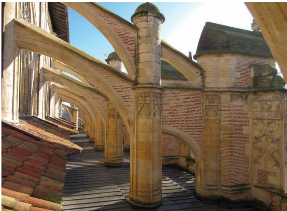
FIG. 9. PILES ET CULÉES DU BAS-CÔTÉ SUD ÉDIFIÉES PAR JEAN D'ORLÉANS. Cl. J.-L. Rebière.
