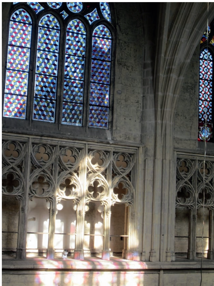
FIG. 16. DÉTAIL DU RÉSEAU DES GALERIES DU TRIFORIUM GOTHIQUE et de l'élévation nord du chœur. Cl. J.-L. Rebière.
