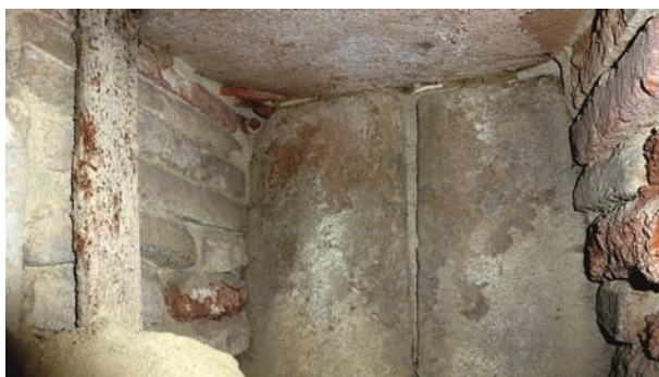
FIG. 7. ÉGLISE DE BOULOC. Armoire eucharistique : intérieur. Cliché J.-M. Lassure.
