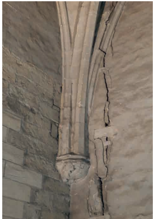
FIG. 16. AVIGNON, PALAIS APOSTOLIQUE, Tour de la Gâche, détail des pénétrations de nervures dans la hauteur du tas de charge, à partir de 1357. Cliché B. Sournia.
