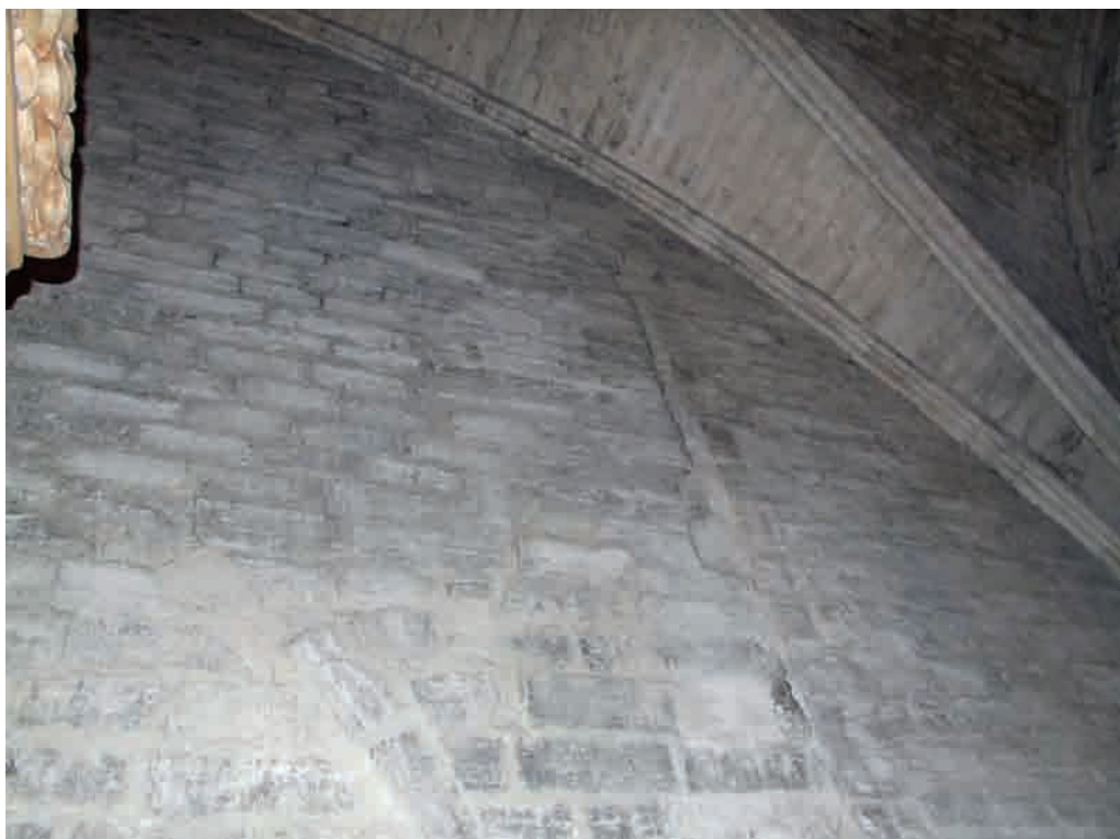
FIG. 31. ÉGLISE, REVERS DE LA FAÇADE avec la déliaison correspondant au jambage du cadre de la rose carrée. Cliché B. Sournia.
