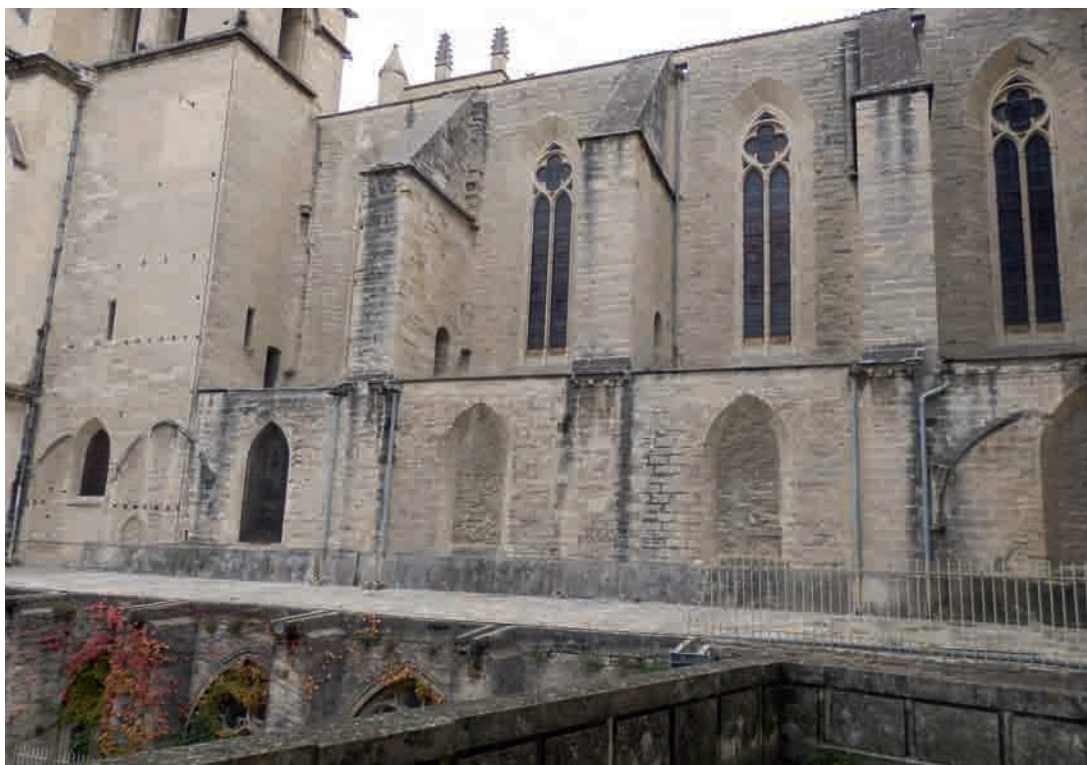
FIG. 7. FACE ORIENTALE DU CLOÎTRE ET ÉLEVATION LATÉRALE DE L'ÉGLISE : noter les segments de la corniche d'origine préservés au droit des murs boutants (voir aussi fig. 35 et 36.). Cliché B. Sournia.
