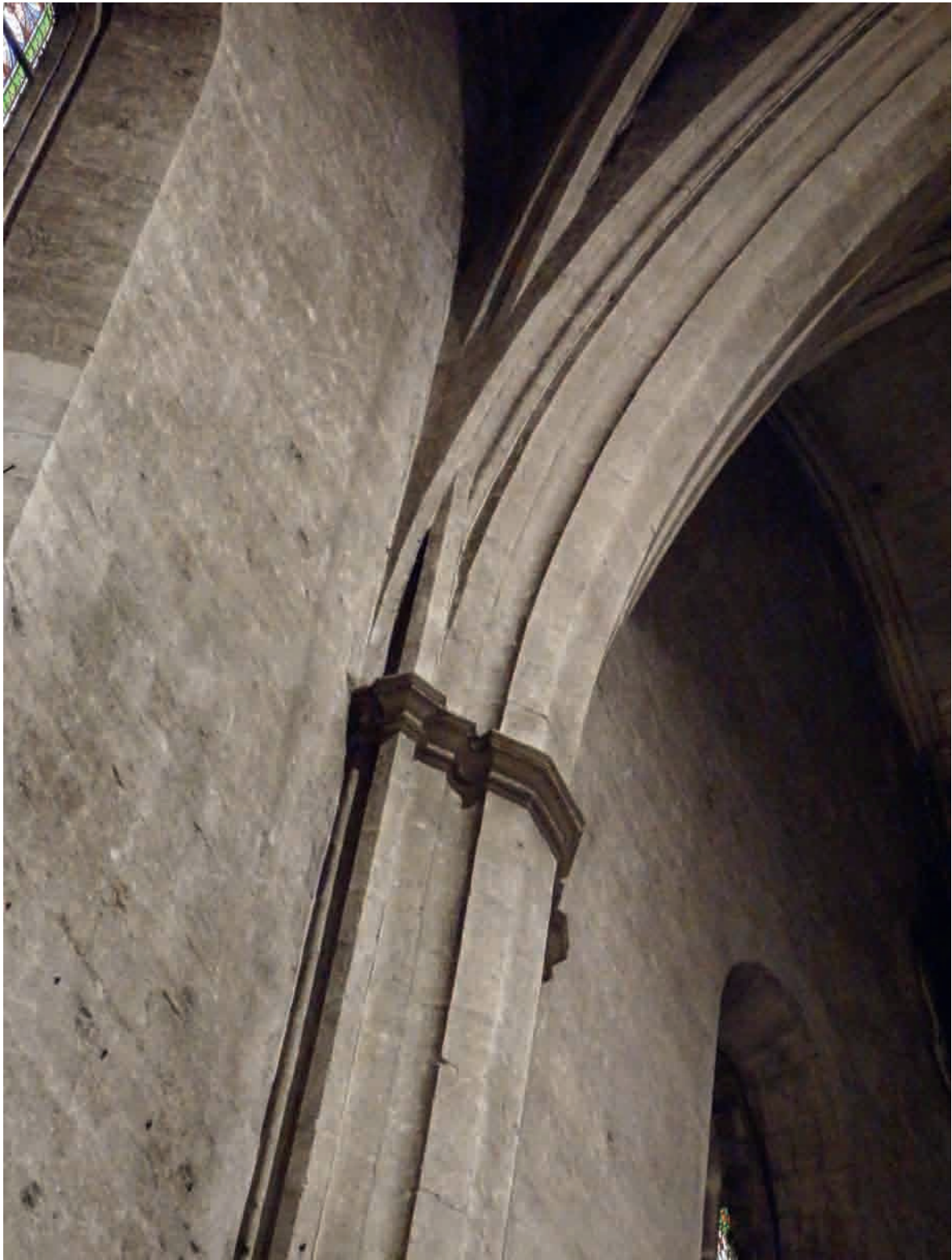
FIG. 18. AVIGNON, ÉGLISE-COLLÉGIALE SAINT-DIDIER, 1356, détail de la pile et du tas de charge. Les profils prismatiques font partie des traits caractéristiques à la mode des années 1350-1360. Cliché B. Sournia.
