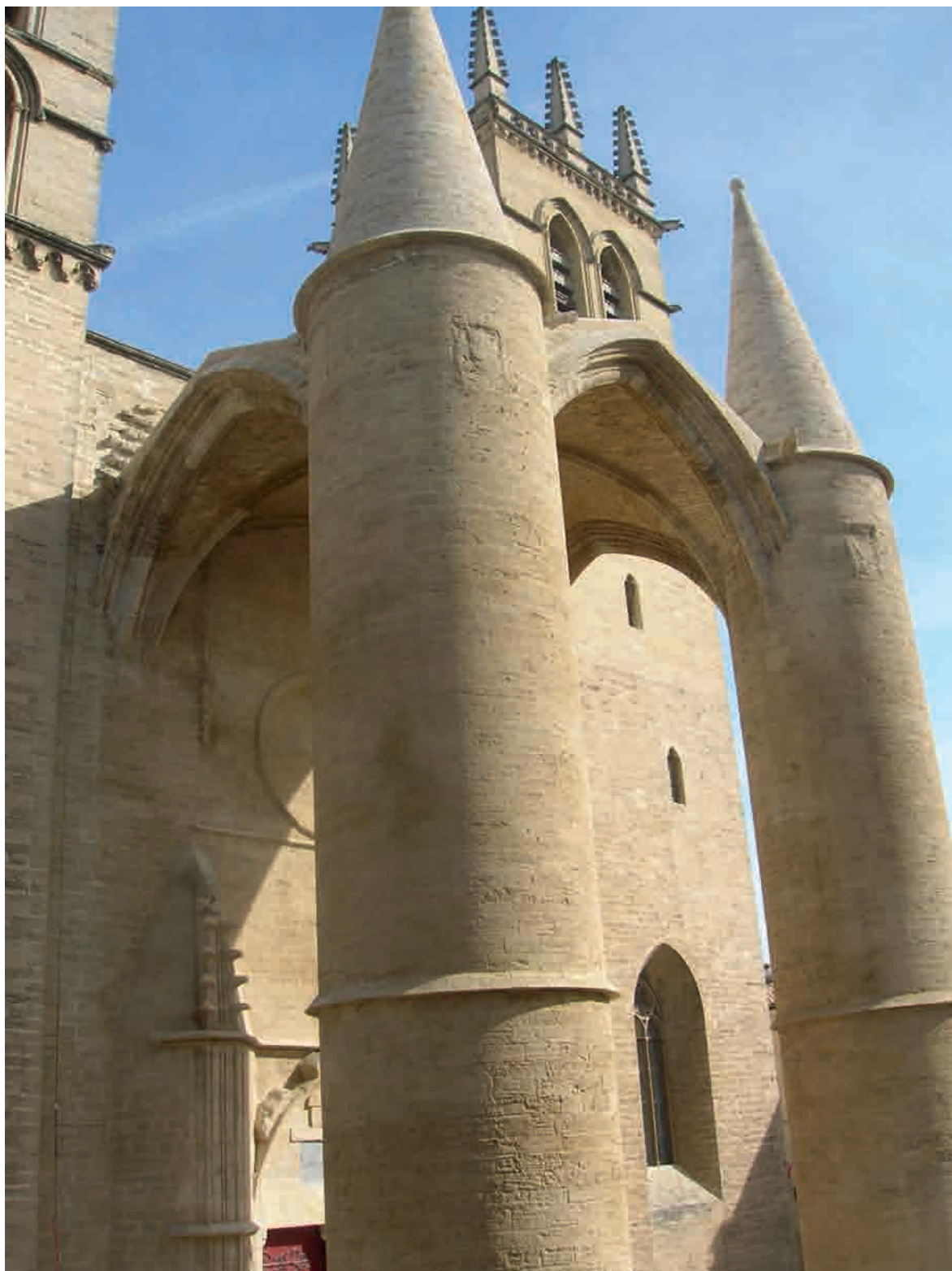
FIG. 22. LE PORCHE DE L'ÉGLISE, vue d'ensemble. Le clocher de droite, détruit en 1567, résulte en son état actuel de la reconstruction par Révoil au milieu du XIX e siècle. Cliché B. Sournia.
