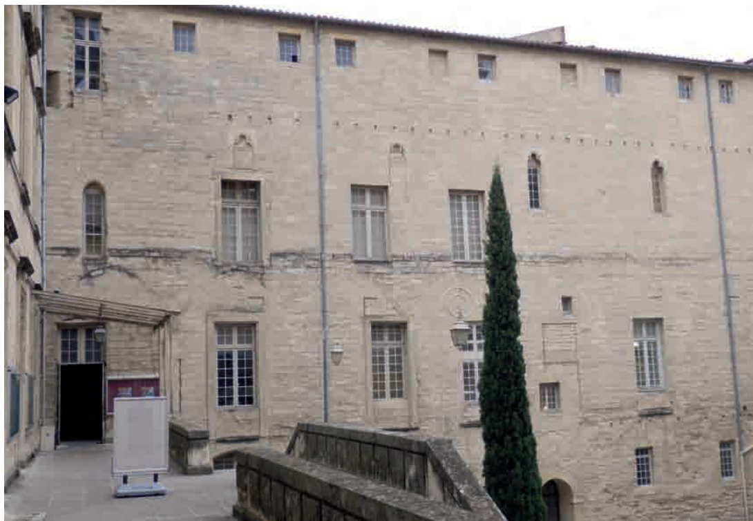
FIG. 6. COLLÈGE-MONASTÈRE, CORPS OUEST SUR LE CLOÎTRE. Apparaissent nettement visibles les arcs formerets des deux niveaux bas du cloître (détruits) et les opes des chevrons de couverture de son troisième niveau. Cliché B. Sournia.
