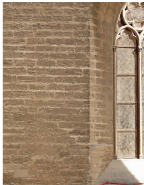
FIG. 20. ÉGLISE SAINT-BENOÎT-SAINT-GERMAIN, DÉTAIL DU PAREMENT du massif antérieur. Le remplage de la fenêtre résulte des travaux de Révoil, 1852. L'embrasement concave de la fenêtre appartient aussi aux traits usuels de l'architecture avignonnaise. Cliché B. Sournia.
