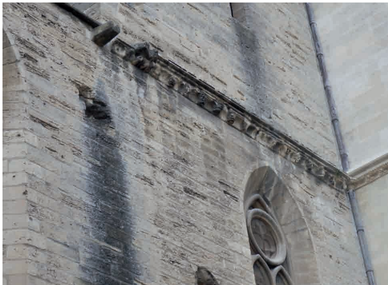
FIG. 35. ÉGLISE, BASE DE LA TOUR NORD-EST chevauchant la corniche couronnant l'alignement des chapelles latérales. Cliché B. Sournia.
