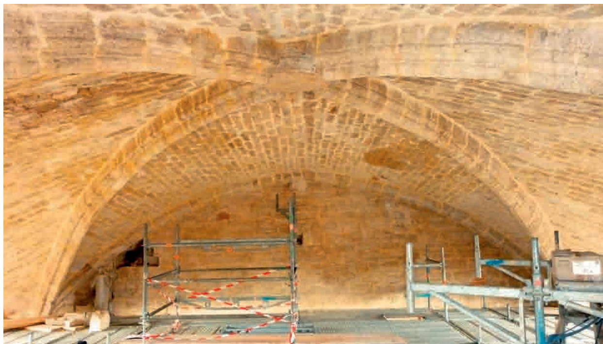
FIG. 32. ÉGLISE, L'ARC FORMERET de la voûte du porche. On discerne la cavité correspondant à l'enlèvement de quelques pierres de parement ayant permis d'observer le retour horizontal du cadre de la rose carrée. Cliché B. Sournia.
