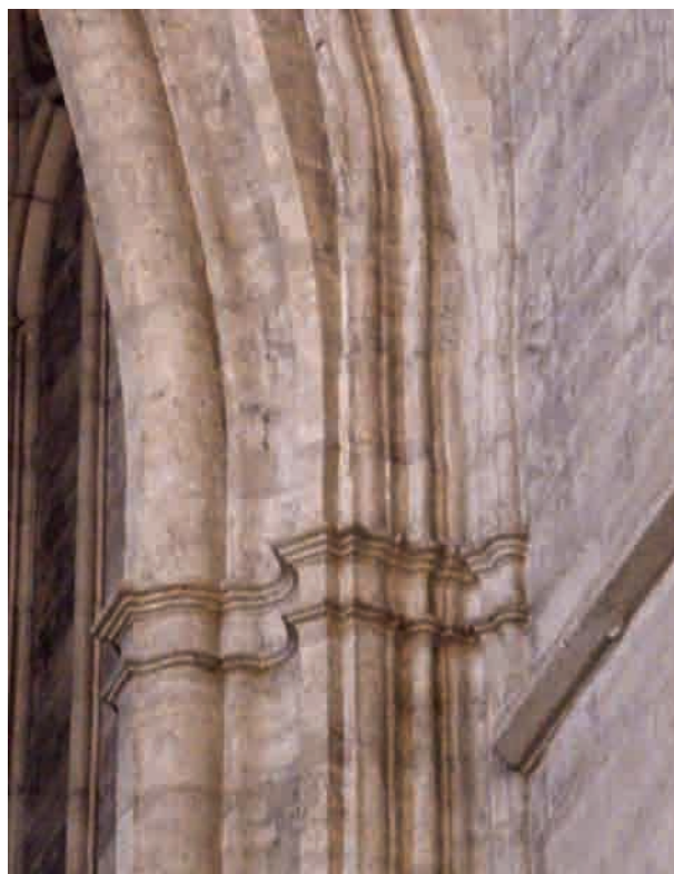
FIG. 12. NEF DE L'ÉGLISE, NAISSANCE DES NERVURES résultant de la réfection des voûtes de la nef dans les années 1630. Détail à la jonction des première et deuxième travées, côté ouest. Cliché B. Sournia.
