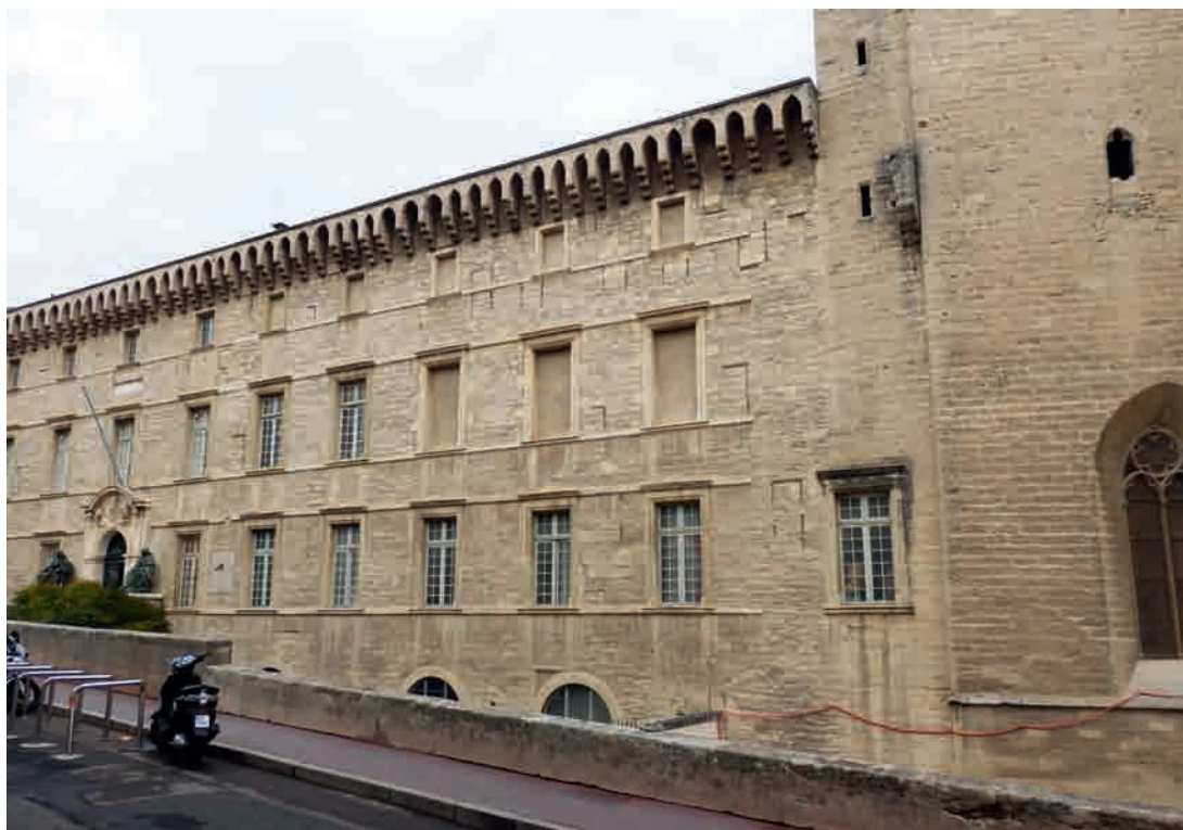
FIG. 5. FAÇADE NORD DU COLLÈGE-MONASTÈRE : l'aile des étudiants. Cliché B. Sournia.
