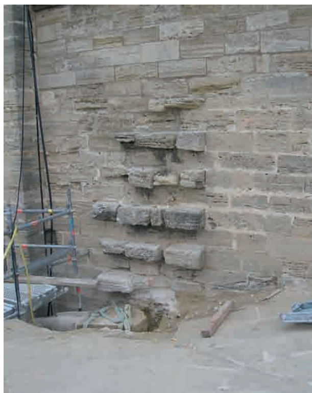
FIG. 33. ÉGLISE, APPAREIL D'ATTENTE au-dessus de l'extrados de la voûte du porche. Cliché B. Sournia.
