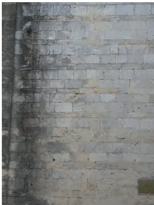
FIG. 19. MONTPELLIER, CHEVET DE L'ÉGLISE NOTRE-DAME DES TABLES, ouvrage de Jean Giral, années 1720, bel exemple d'appareil alterné dit « de Montpellier ». Cliché B. Sournia.
