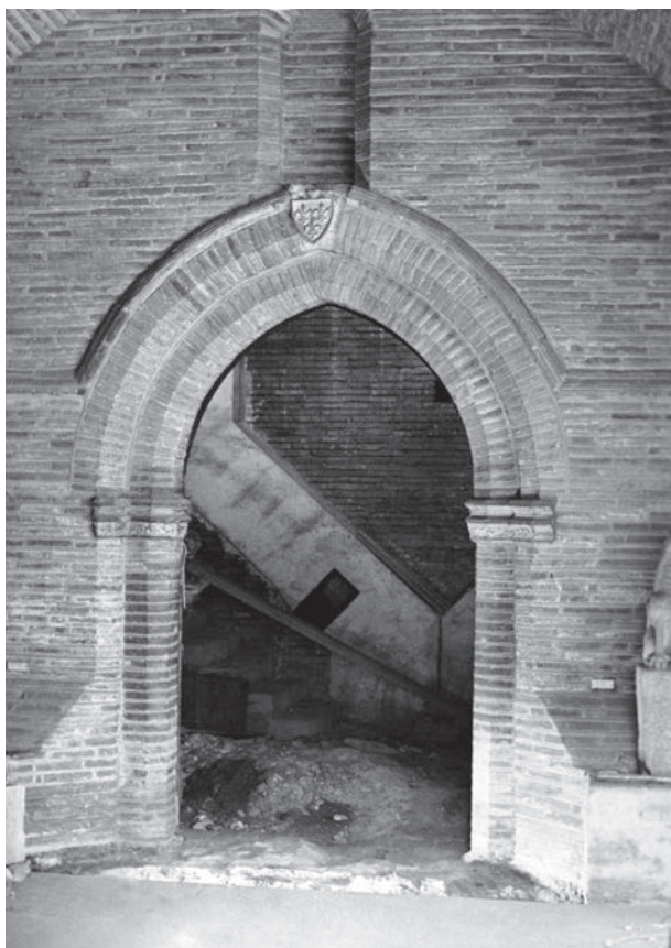
FIG. 19. LA PORTE ORIENTALE DU RÉFECTOIRE AU MOMENT DES TRAVAUX DE RESTAURATION DU COUVRE, EN 1977. Photo D. Cazes.
