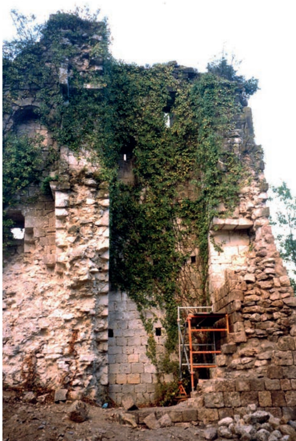
FIG. 3. DUNES. SITE DU « TURAS ». Début des travaux. Photo M.-T. Tinet-Lassure.
