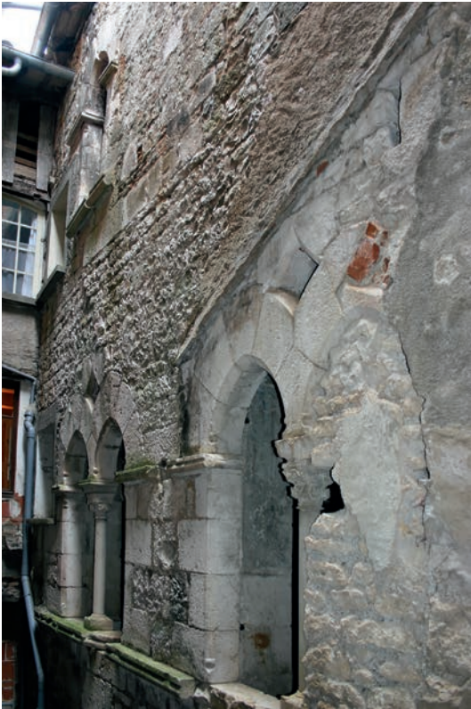
SAINT-ANTONIN-NOBLE-VAL. « Maison Le Maréchal » : fenêtres sur la courrette ; décor peint de « puzzle » ; cloison en pan de bois et détail du montage des éclisses, taillées et séparées par des cales de bois. Cl. A. Aleyrangues - M. Scellès.
