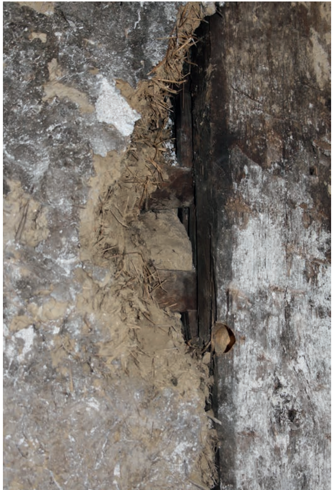
SAINT-ANTONIN-NOBLE-VAL. « Maison Le Maréchal » : fenêtres sur la courrette ; décor peint de « puzzle » ; cloison en pan de bois et détail du montage des éclisses, taillées et séparées par des cales de bois. Cl. A. Aleyrangues - M. Scellès.
