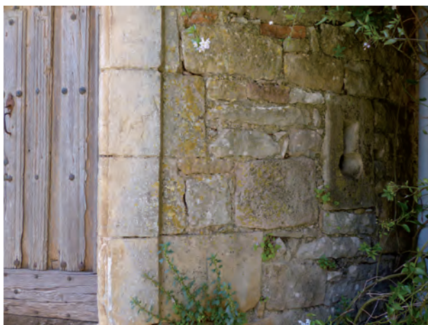
FIG. 1. BRUNIQUEL, DÉTAIL DE LA BOUCHE À FEU protégeant la porte de la tour d'escalier Cl. G. Séraphin.
