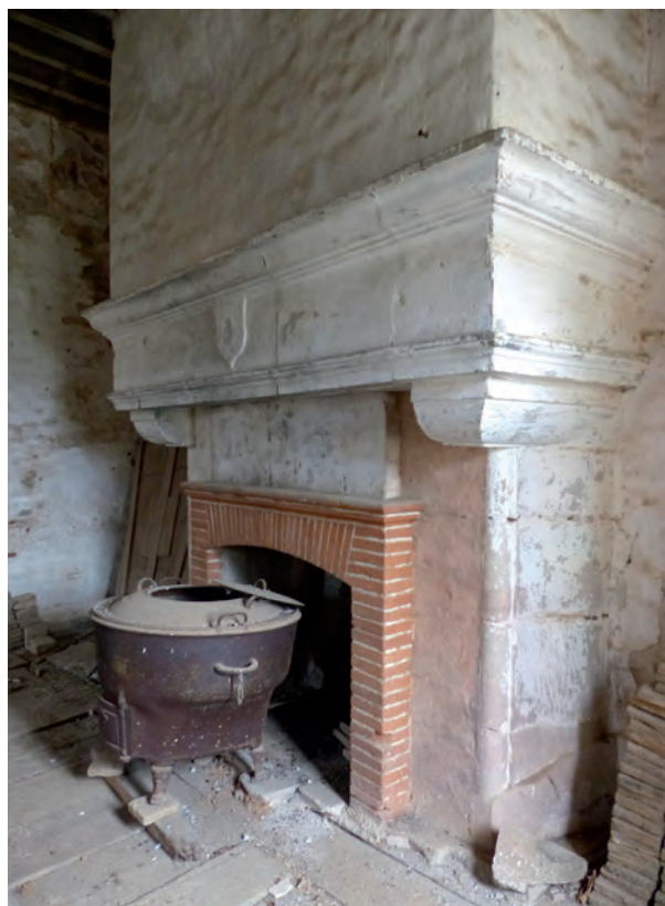
FIG. 3. BRUNIQUEL, CHEMINÉE AU PREMIER ÉTAGE DES LOGIS, caractérisée par sa corniche en doucine, ses jambages en demi-rond et son écu à l'italienne. Cl. G. Séraphin.
